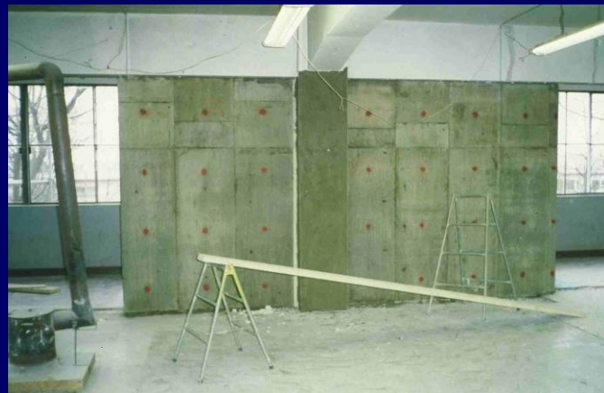
袖壁による補強
