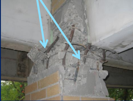
主筋の破断、座屈
