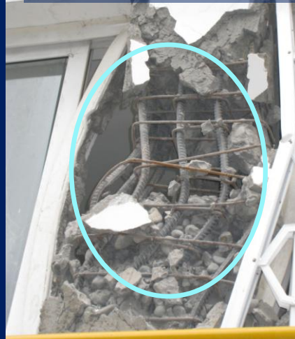
主筋の破断、座屈
