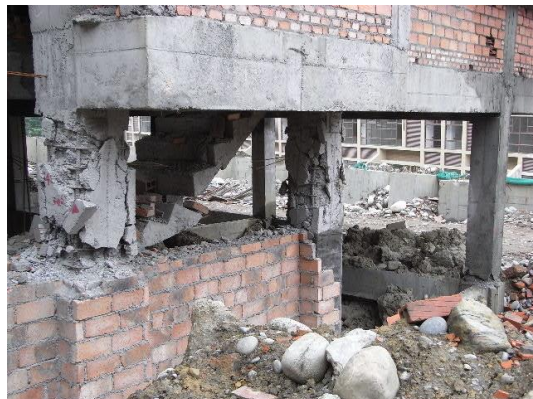
写真96 短柱と長柱が混在により短柱がせん断破壊
