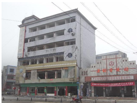
写真15 建物全景（道路側正面）
