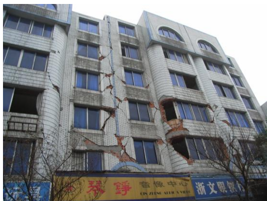
写真13 警察署周辺の集合住宅（外壁に損傷）
