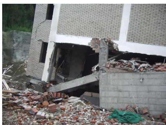
写真88 中央建物の山側ピロティ柱の崩壊
