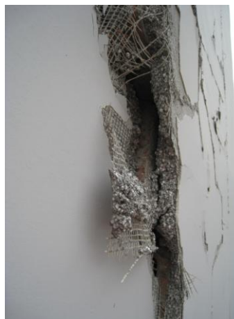
写真54 繊維メッシュを用いたレンガ壁の仕上げ 写真55 左写真ひび割れ部の拡大 (モルタルに発泡スチロールの粒を混入)
