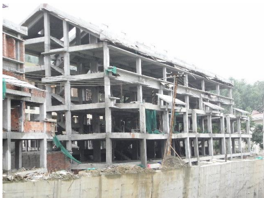
写真95 骨組だけの建物全景
