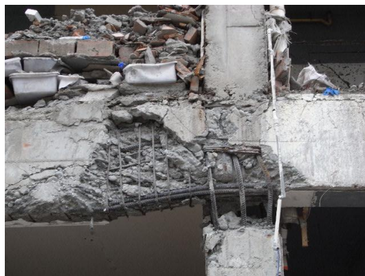
写真120 2階梁柱接合部周辺の損傷状況
