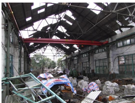
写真40 妻壁が崩落し、屋根材も落下
