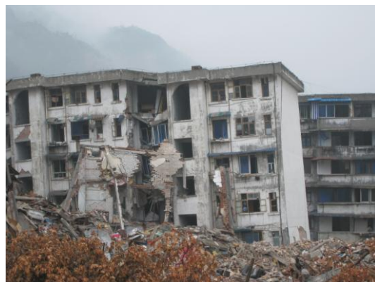
写真23 大きく傾斜した集合住宅
