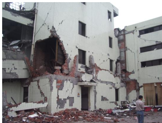
写真75 大破したレンガ壁 (④)
