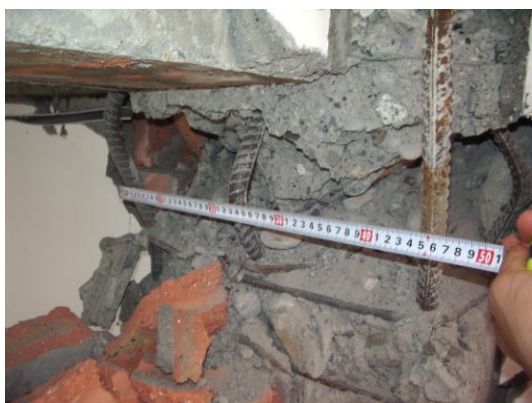
写真53 柱頭の曲げ圧壊と主筋の座屈
