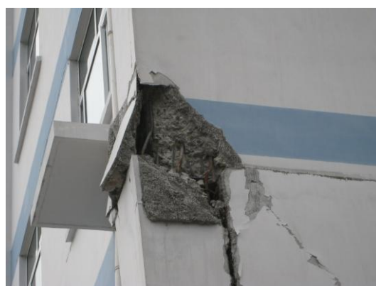
写真52 柱頭と柱梁接合部の損傷
