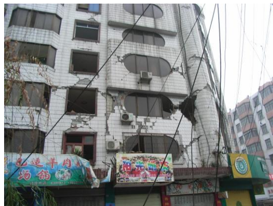
写真12 レンガ壁の損傷
