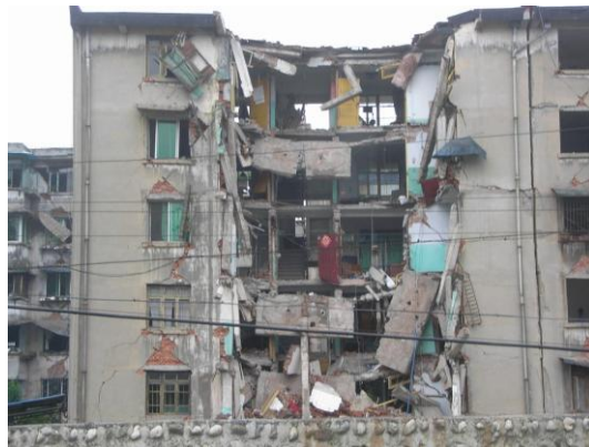
写真21 左写真の崩壊した部分
