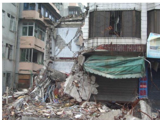
写真11 崩壊部分の拡大
