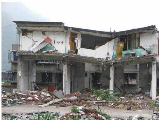
写真22 部分崩壊し大きく変形した住宅
