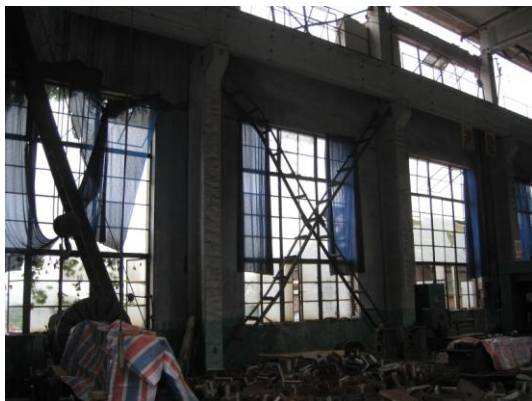
写真44 格子型ブレースの座屈
