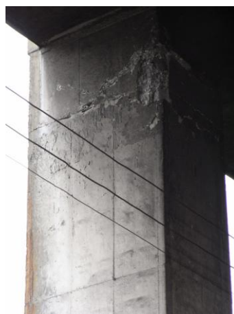
写真33 1階柱頭の打ち継ぎ面の損傷
