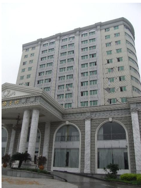
写真107 建物全景、開口周辺のせん断ひび割れ
