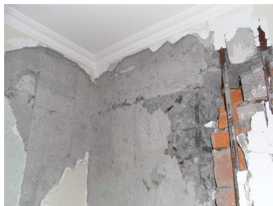
写真104 柱頭打ち継ぎ部の損傷
