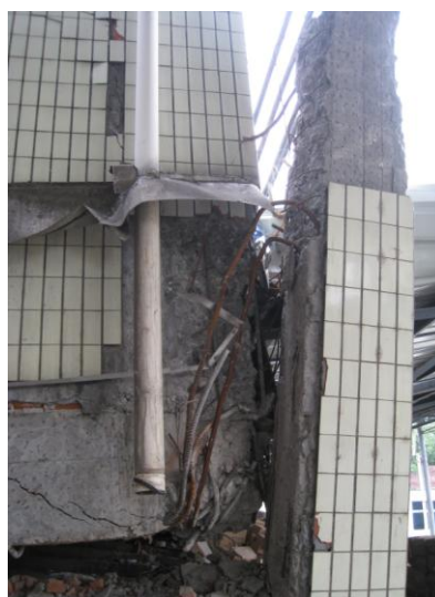
写真77 1層崩壊した柱頭の損傷 (⑥)
