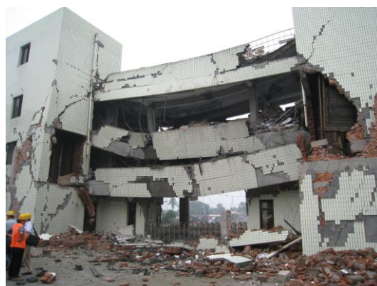
写真73 2階の層崩壊部分（②）
