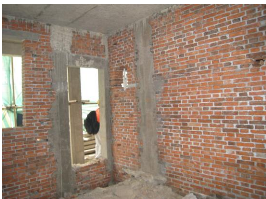
写真69 先積みレンガ+枠組みの壁
