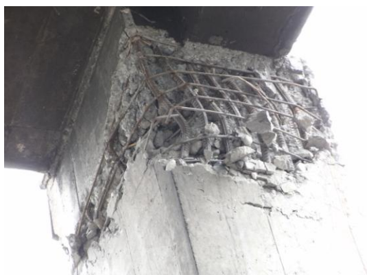
写真32 1階柱頭の短辺方向の塑性ヒンジ
