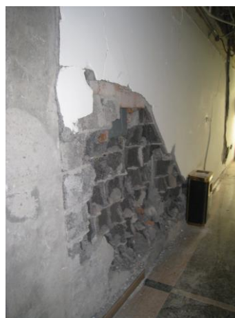
写真66 ブロック壁の損傷状況
