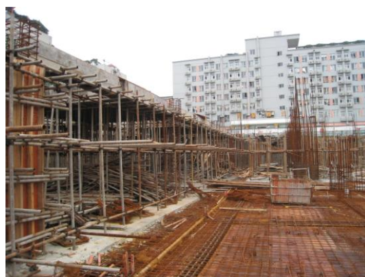
写真128 地下1階スラブ配筋
