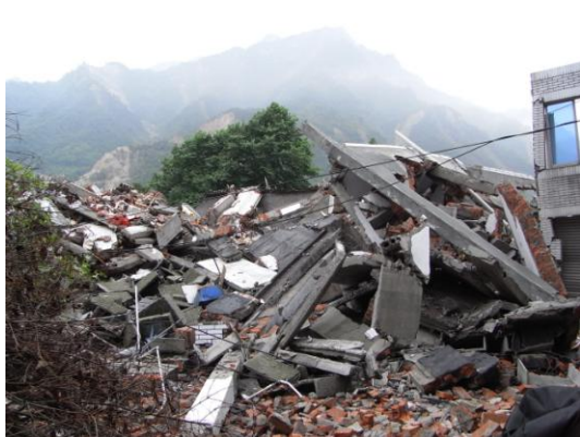
写真48 完全に倒壊した6階建て建物
