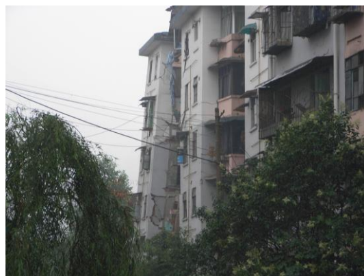
写真14 警察署周辺の傾斜した集合住宅
