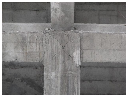
写真85 杭頭柱梁接合部のせん断ひび割れ
