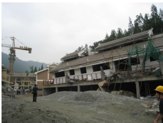
写真86 層崩壊した中央建物全景
