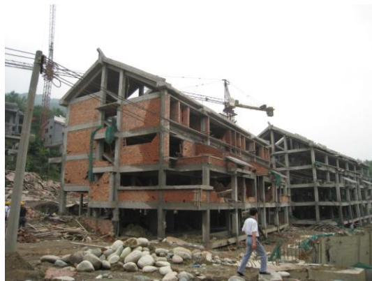
写真94 レンガ壁が施工された建物全景
