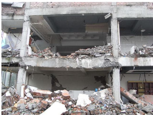
写真119 左側建物の2階梁のたわみ
