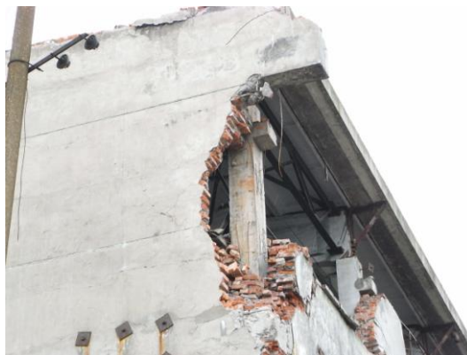
写真45 RC架構外側のレンガ壁の部分崩壊
