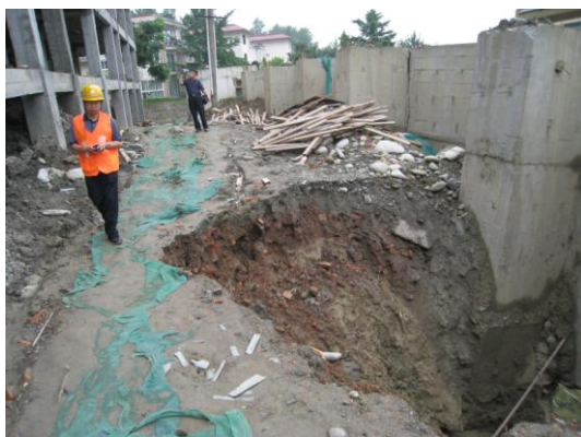
写真99 擁壁下部から土砂が流出
