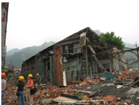
写真39 部分崩壊した小規模工場の全景
