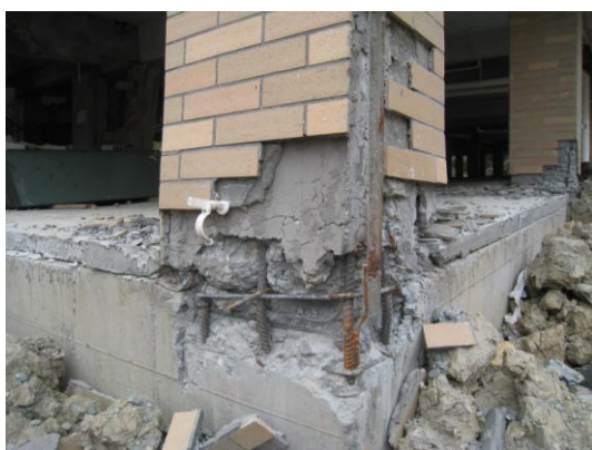
写真82 柱脚主筋の破断
