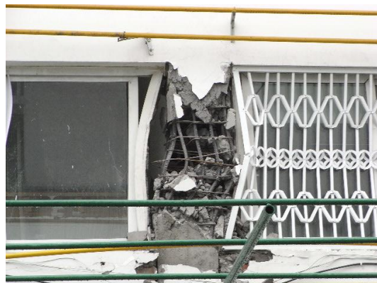
写真116 レンガ造腰壁による短柱のせん断破壊
