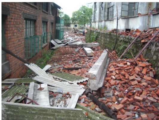
写真46 崩落した外壁レンガと臥梁
