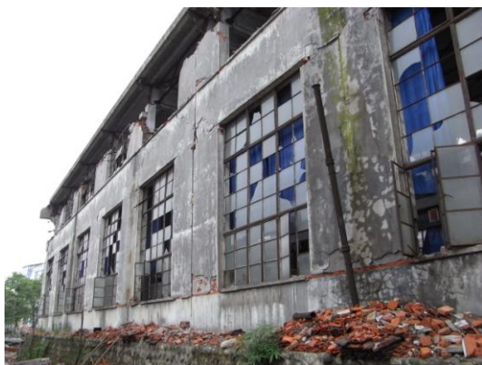
写真42 鉄骨ラチス屋根をもつ中規模工場の外観
