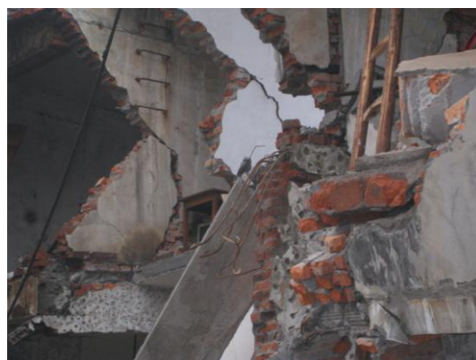
写真8 レンガ壁の損傷
