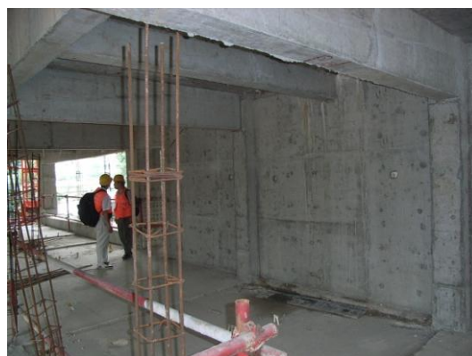
写真131 RC造耐震壁
