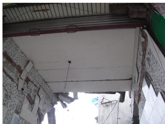
写真6 落下を免れた床スラブ
