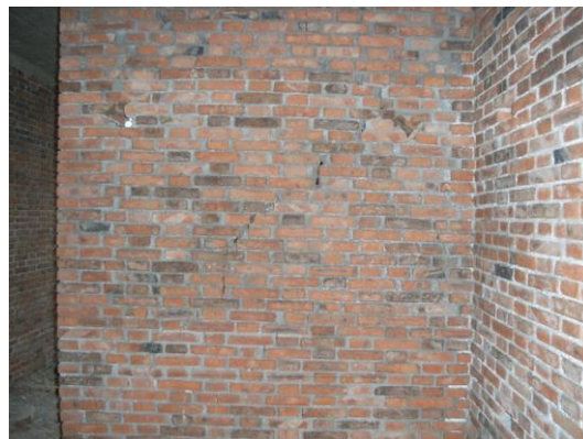
写真70 レンガ壁のせん断ひび割れ
