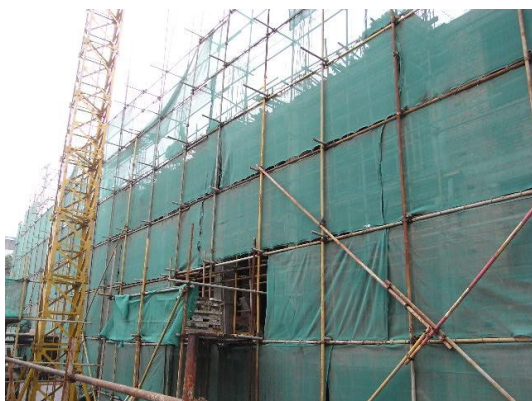
写真67 建設中の集合住宅の全景
