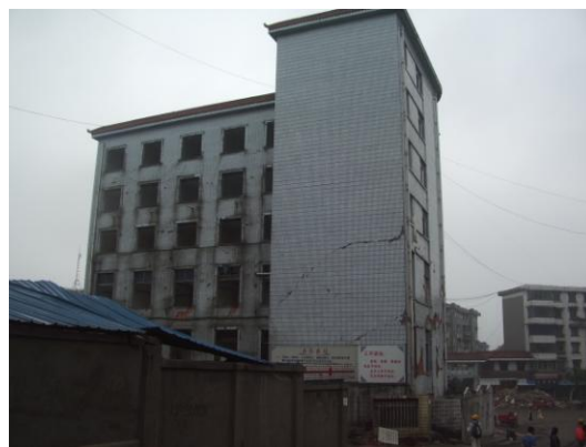
写真16 建物全景（道路と反対側）
