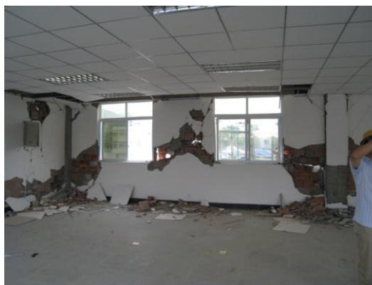
写真57 レンガ壁の損傷
