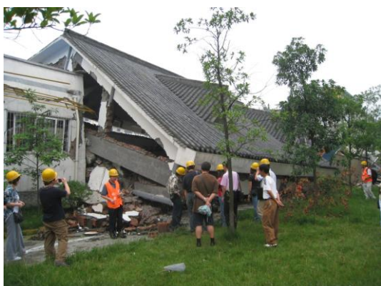
写真113 倒壊した瓦屋根の商業ビル
