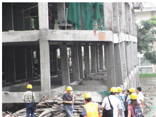
写真100 基礎が強制変位を受け不同沈下
