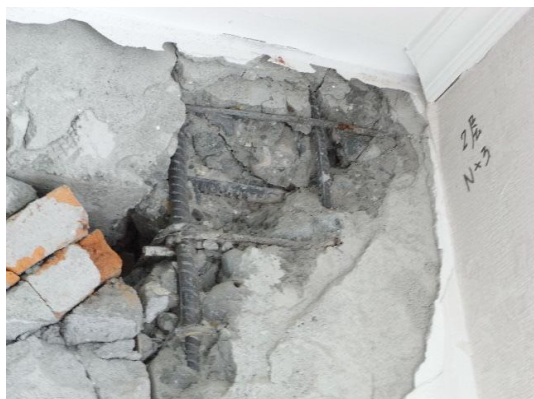
写真105 柱頭のせん断破壊
