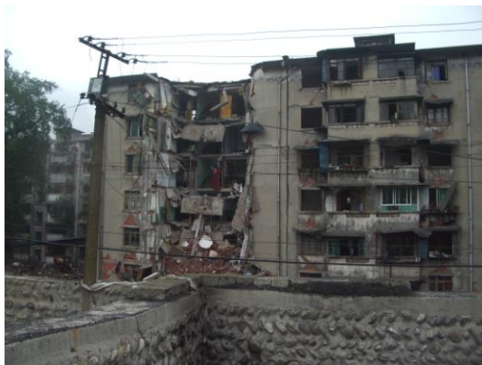
写真20 部分崩壊した集合住宅
