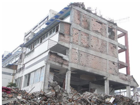
写真118 6階建て集合住宅3棟の左側建物
