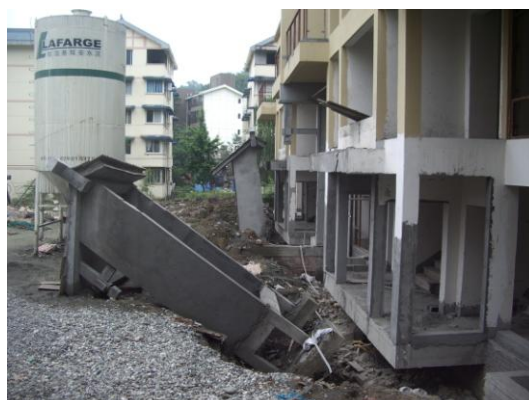
写真92 エントランスゲートの転倒
