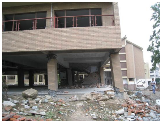
写真81 建物1階に残留変形
