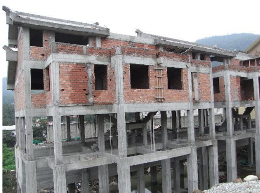
写真84 杭埋め戻し前の建物全景
