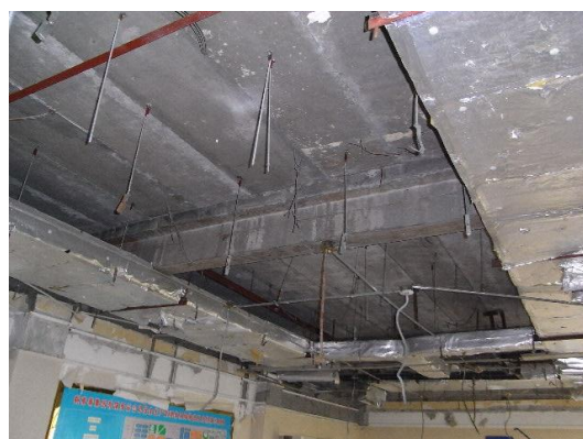
写真64 PCa床板による床スラブ
