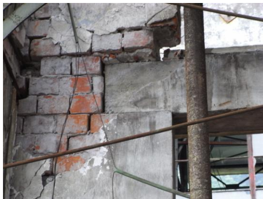
写真41 レンガ壁の面外方向へのずれ
