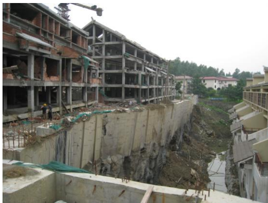
写真93 傾斜地に建設中の2棟の集合住宅
