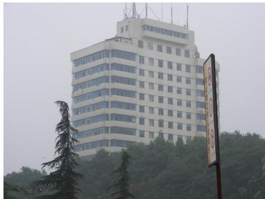
写真25 付近の新しい建物（倒壊していない）
