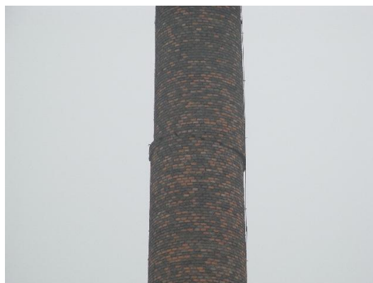
写真2 高さ中央で水平ずれが生じた煙突
