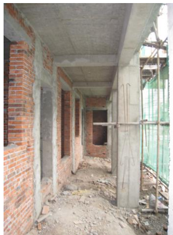
写真68 バルコニー部分はRC架構で住居部は組積造
