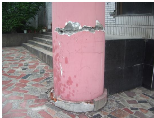
写真59 1階丸柱の打ち継ぎ部分の水平のひび割れ
