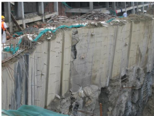
写真97 擁壁の傾斜
