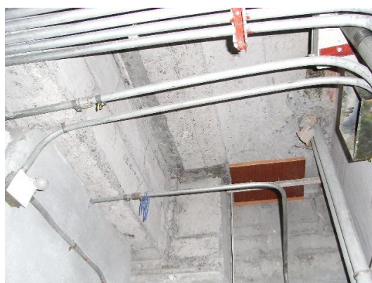
写真110 点検口等から見える躯体コンクリートの品質は良好
