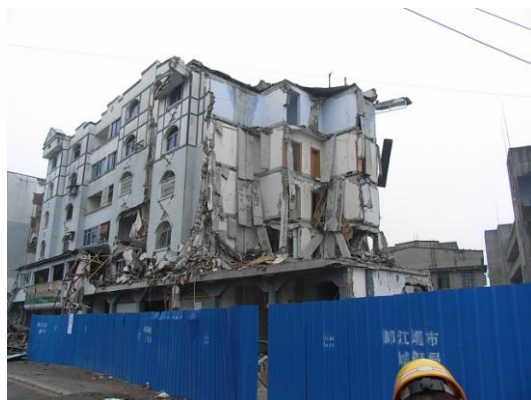
写真124 建物右側の2階から上部の部分崩壊
