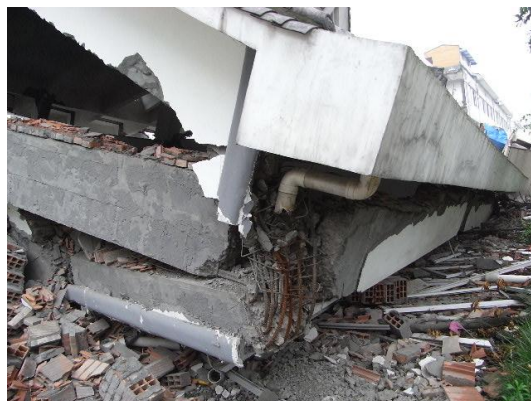
写真114 崩壊建物の柱頭
