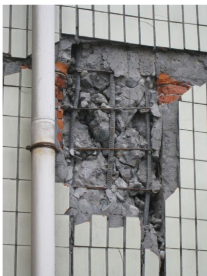
写真78 1階短柱のせん断破壊 (⑦)
