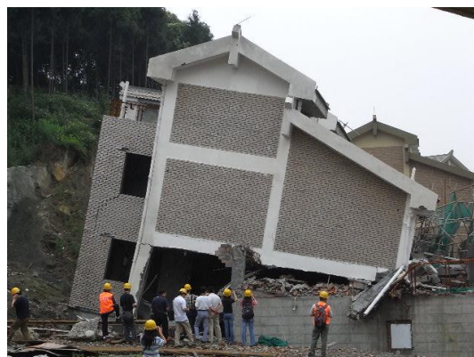
写真87 2階層崩壊により道路側に傾斜
