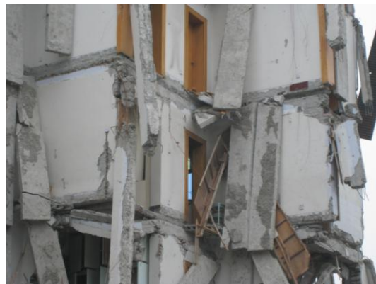
写真125 建物左側の2階から上部の部分崩壊 写真126 PCa中空スラブの崩落
