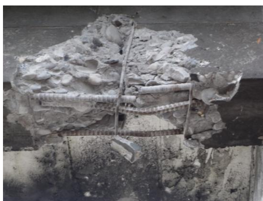
写真35 左写真の塑性ヒンジの拡大
