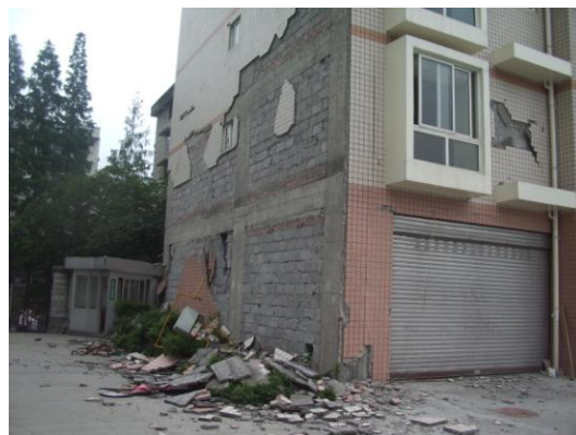
写真106 建物妻面の仕上げモルタルの剥落
