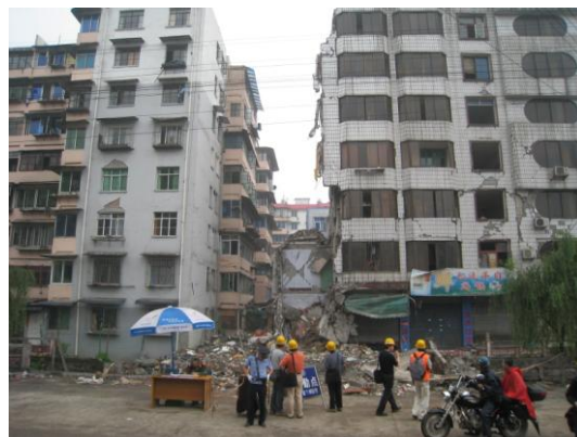
写真10 警察署建物（右）の左端が部分崩壊
