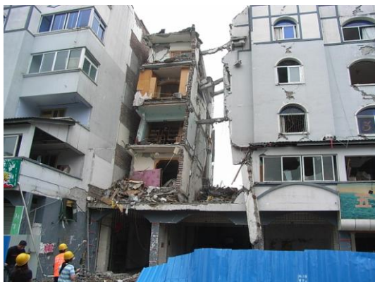
写真125 建物左側の2階から上部の部分崩壊 写真126 PCa中空スラブの崩落
