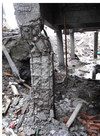
写真89 地盤変状が原因と思われる柱の損傷
