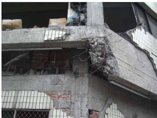
写真74 層崩壊した部分のアップ (③)
