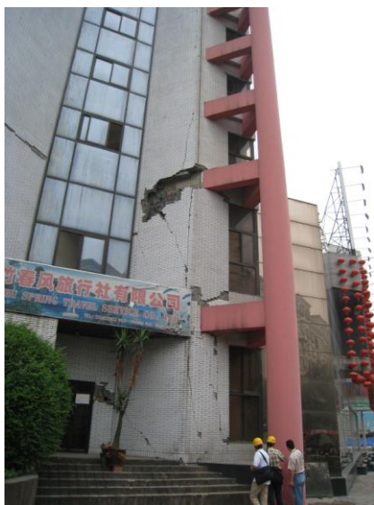
写真60 レンガ壁の損傷
