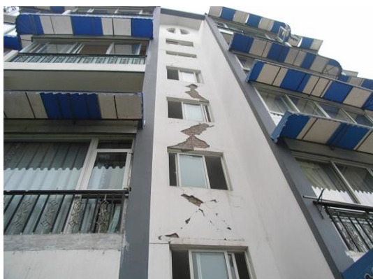
写真121 集合住宅の被害は比較的軽微
