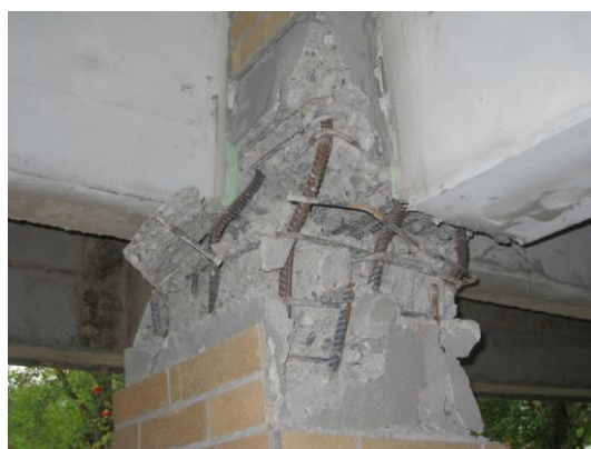
写真83 側柱柱頭の曲げ圧壊（損傷度V）
