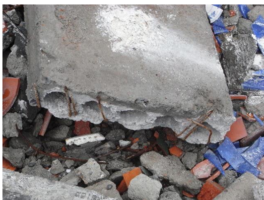
写真7 落下したPCa中空スラブの端部
