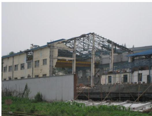
写真47 周辺の他の工場の被害状況
