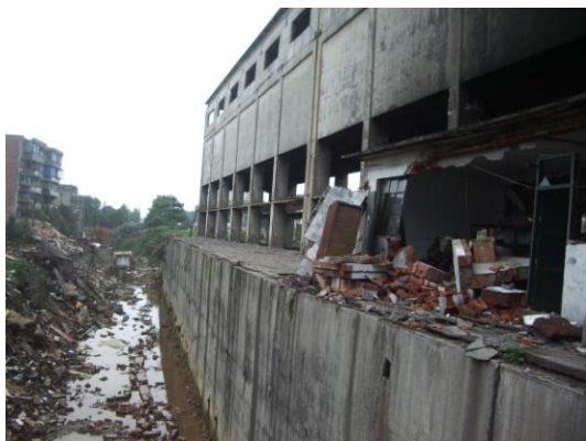
写真28 補給基地は川沿い立地している
