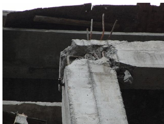
写真102 接合部の破壊
