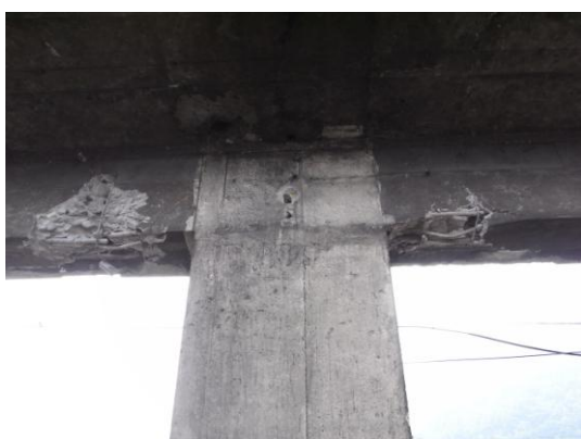
写真34 長辺方向の2階梁端の塑性ヒンジ
