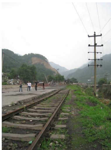
写真31 地盤変状による線路面の波打ち
