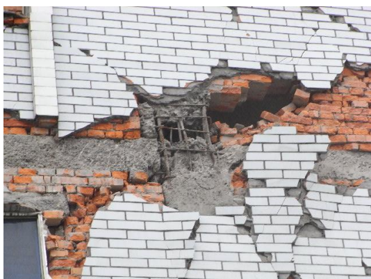
写真17 柱脚と柱梁接合部のコンクリートの崩落
