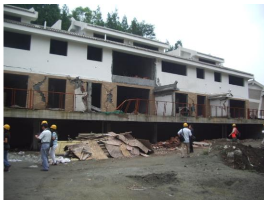
写真91 レンガ壁のひび割れ
