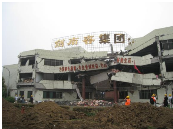
写真72 酒造工場の正面全景（図中①）
