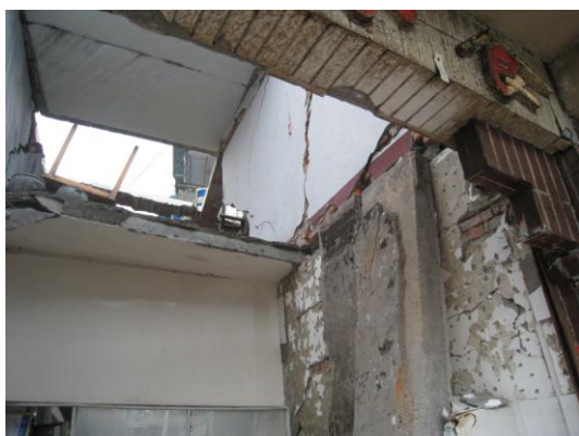
写真5 2階のPCa中空スラブの落下
