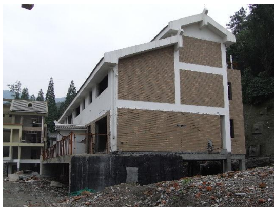
写真90 レンガ壁のひび割れ
