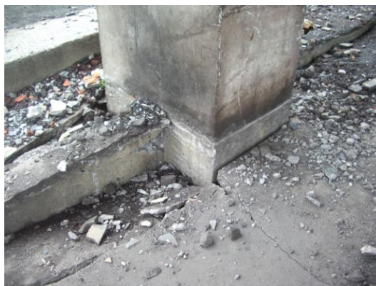
写真29 1階床スラブの沈下の形跡
