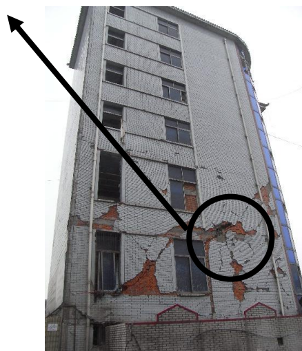
写真19 妻面におけるレンガ壁のひび割れ
