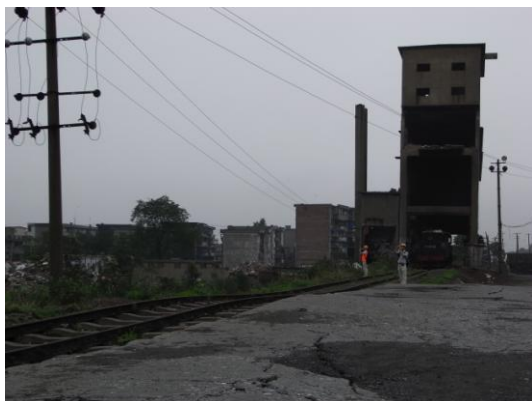
写真30 地盤変状による線路面の波打ち
