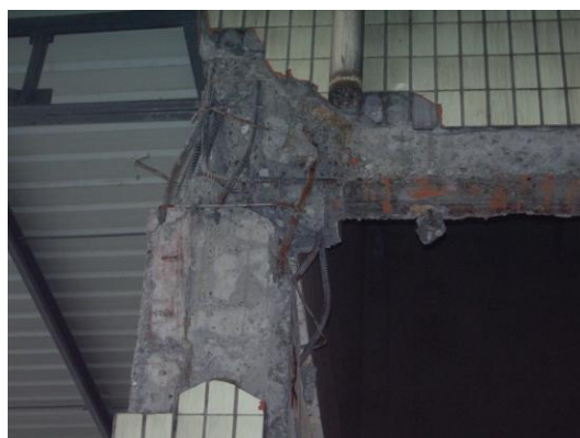
写真79 柱頭部の破壊 (⑧)
