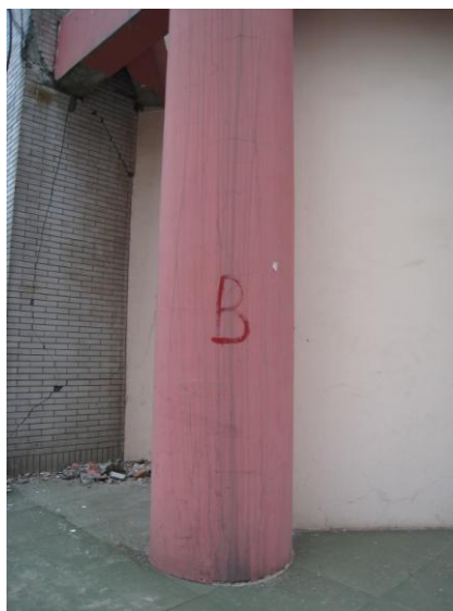
写真61 復旧可能性のB判定(補修で復旧可能)
