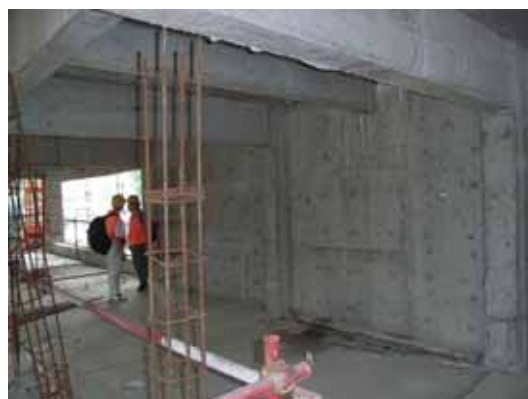
写真131 RC造耐震壁
