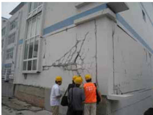
写真54 繊維メッシュを用いたレンガ壁の仕上げ 写真55 左写真ひび割れ部の拡大 (モルタルに発泡スチロールの粒を混入)
