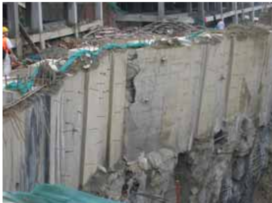
写真97 擁壁の傾斜
