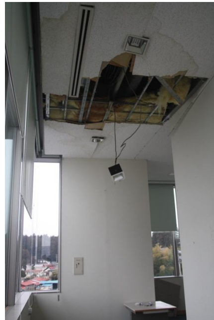
(d) 4階市議会の天井被害
