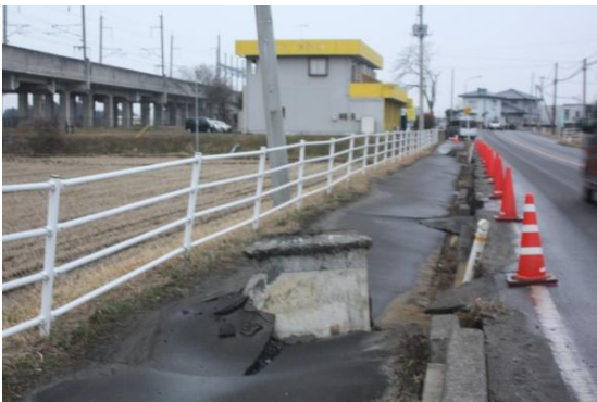
写真4 志波姫付近の液状化被害 (マンホールの浮上)
