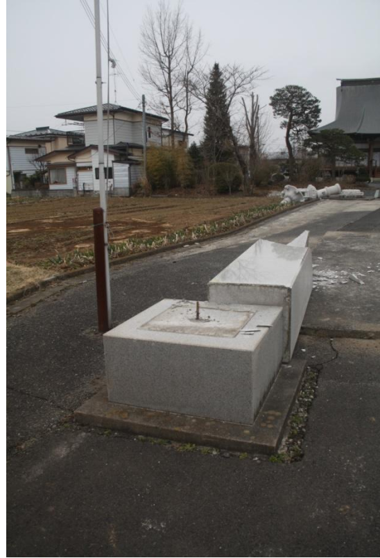
写真1 2 甘露寺の2つの門柱の転倒（西方向へ転倒）
