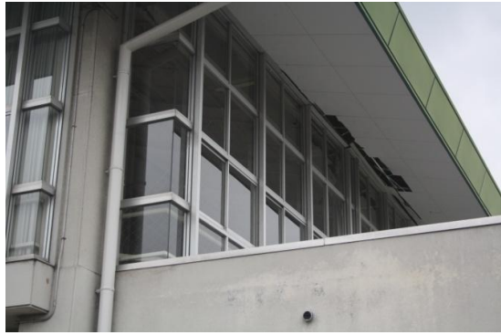
写真3 築館体育センターと軽微な非構造材被害
