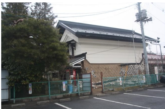
写真8 土蔵の土壁の落下被害
