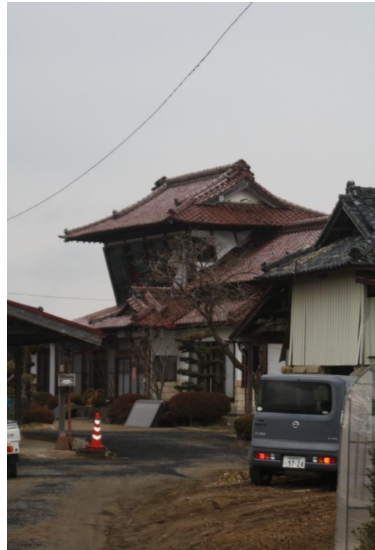
写真1 4 2階部分が大破し傾斜した木造建物
