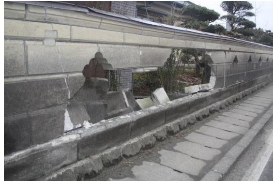
写真6 無被害ブロック壁と石塀の被害
