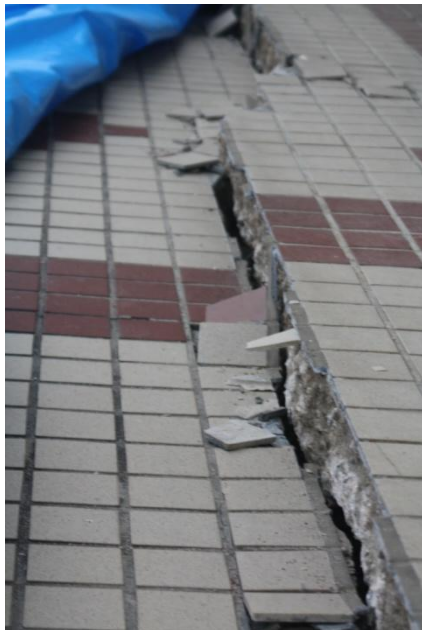
写真10 校舎周辺地盤の沈下
