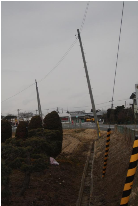
写真1 1 電柱の傾斜
