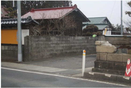
写真6 無被害ブロック壁と石塀の被害
