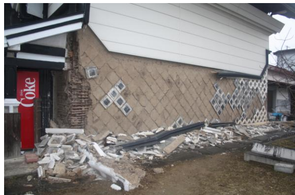
写真8 土蔵の土壁の落下被害
