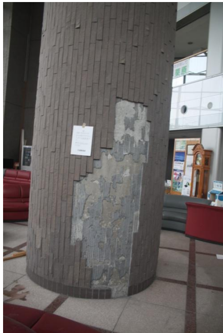
(c) 吹き抜け部の柱仕上げ材の剥離
