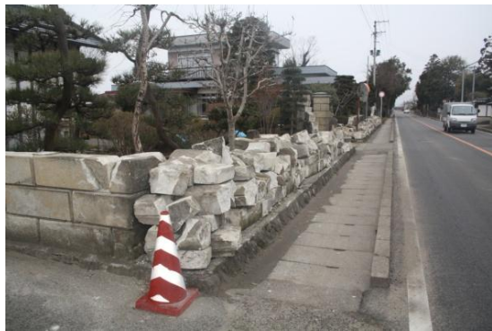
写真5 石塀の倒壊現場
