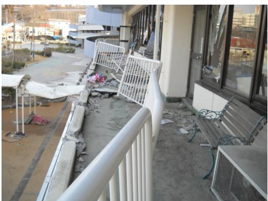
写真19 2階のベランダの被害
