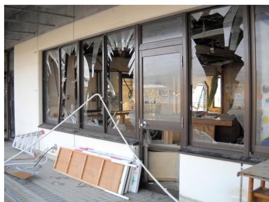
写真18 1階の津波の被害
