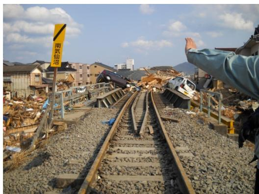
写真 22 気仙沼線の線路の被害
