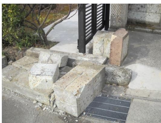
写真9 大谷石の塀の被害
