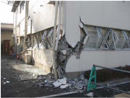
写真13 若林区卸町3丁目のRC造3階建の崩壊
