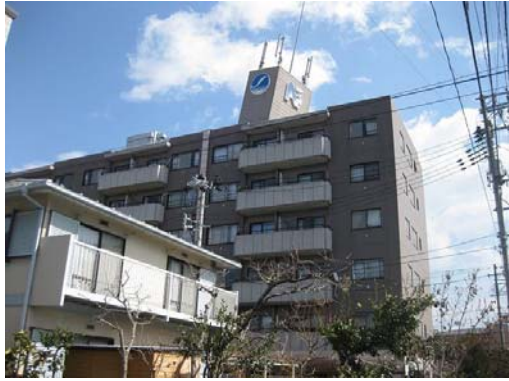
写真5 ペントハウスの被害（若林区成田町）
