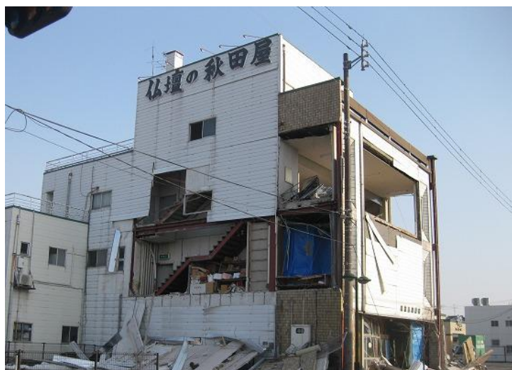
写真 15 加美町中新田地区の S 造 3 階建て店舗（外壁の大規模剥落）
