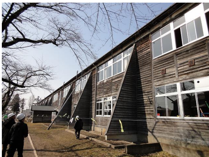
写真 5 大崎市立古川第一小学校（木造2階建て）
