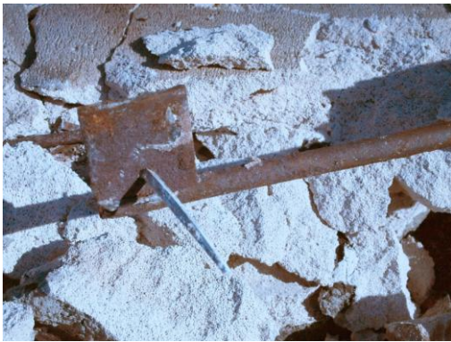
写真 11 落下したALC版外壁の取りつけ 部分
