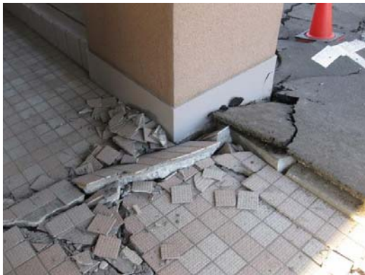
写真19 柱脚部周辺の状況
