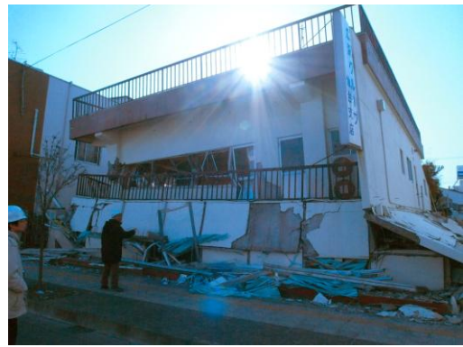
写真12 若林区卸町2丁目のRC造2階建て建物の崩壊
