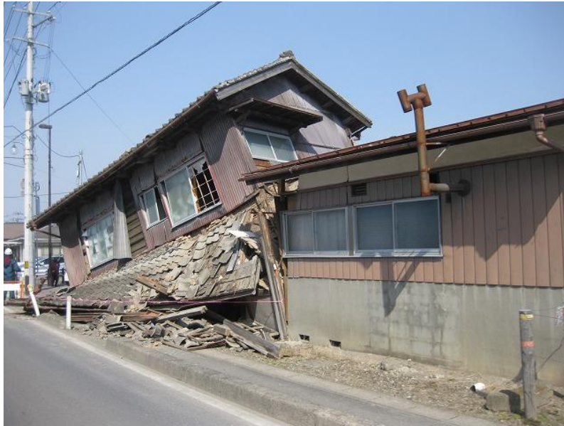
写真2 2階建て木造住宅の倒壊
