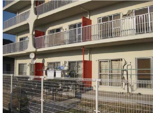
写真17 非構造壁のせん断破壊
