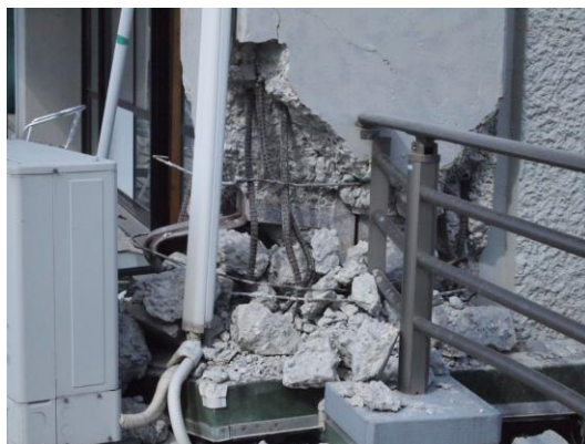
写真4 東側妻壁単側の外柱の被害状河
