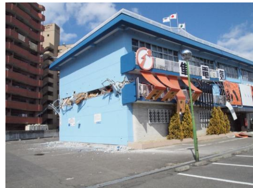
写真7 2階部分の倒壊
