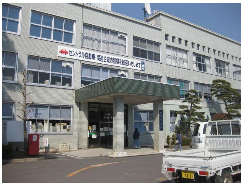
写真 4 大崎市役所（鉄筵コンクリート3階建て）
