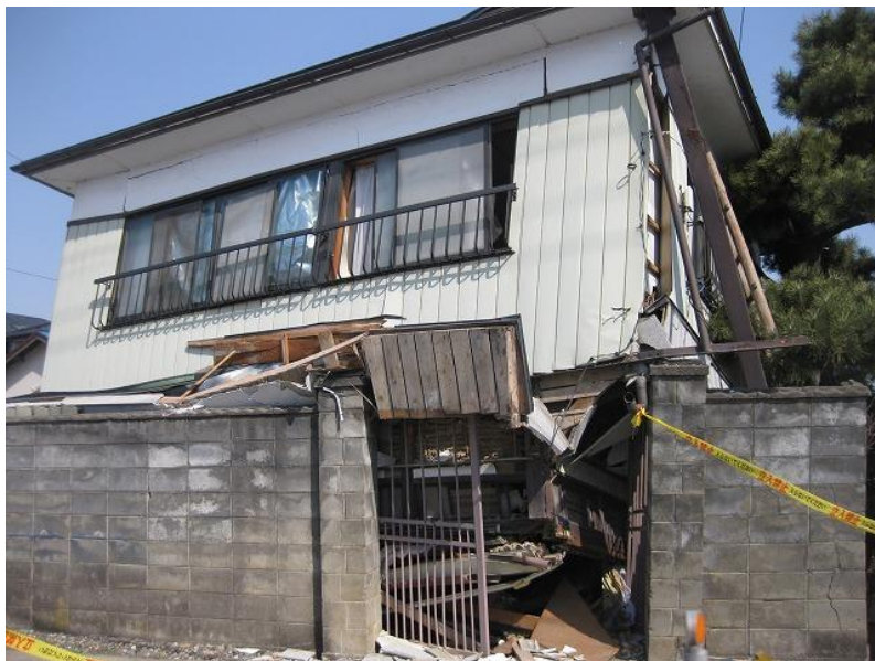
写真3 2階建て木造住宅の倒壊
