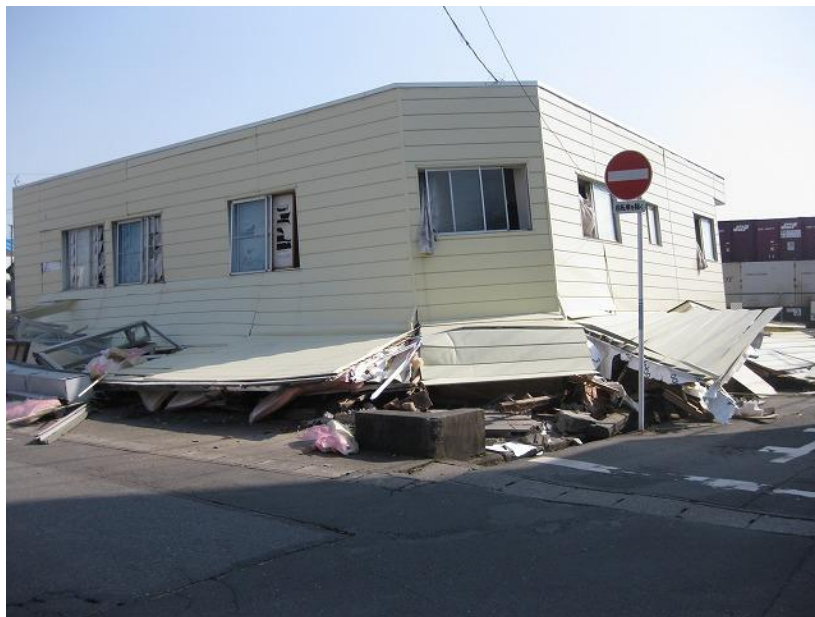
写真 9 2 階建て木造店舗併用住宅の倒壊
