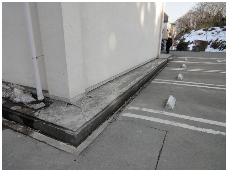
写真 12 岩出山高校校舎（RC 造 3 階建て）の基礎と犬走り境界部のひび割れ
