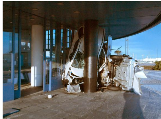
写真 2 2 津波により被害を受けた夢メッセ 写真 2 3 津波により流された自家用車が展示場に侵入
