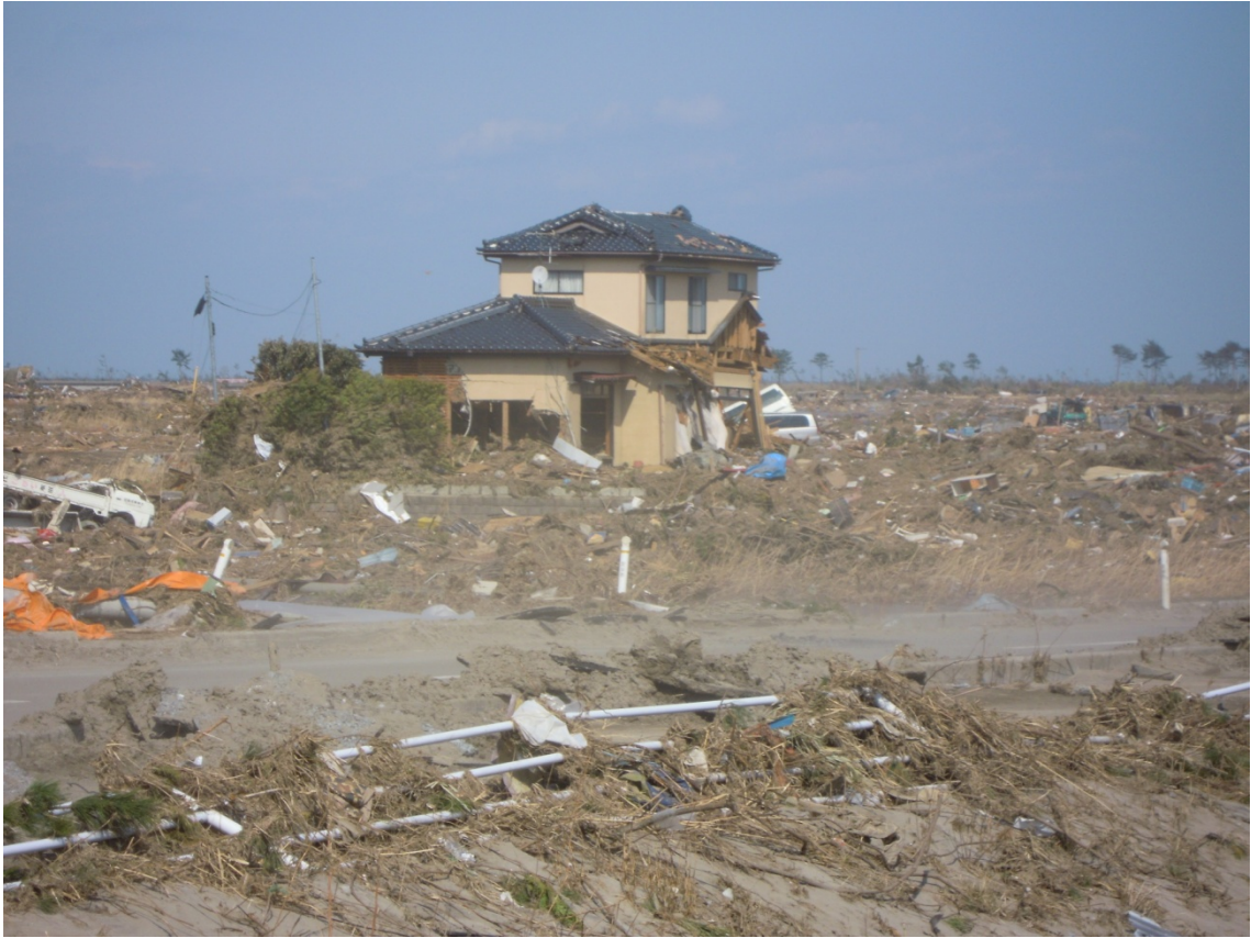
1階部分が津波によって倒壊寸前の状態。
