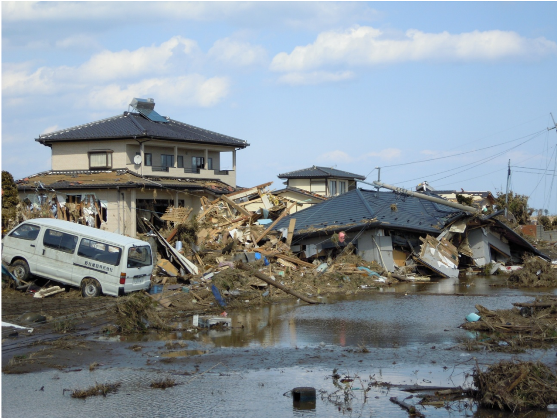
1階の屋根まで津波がきていて、手前の家は倒壊している。
