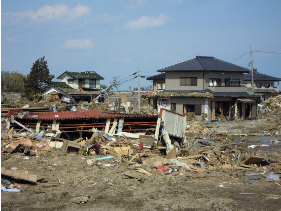
1階の屋根まで津波が来ている。
