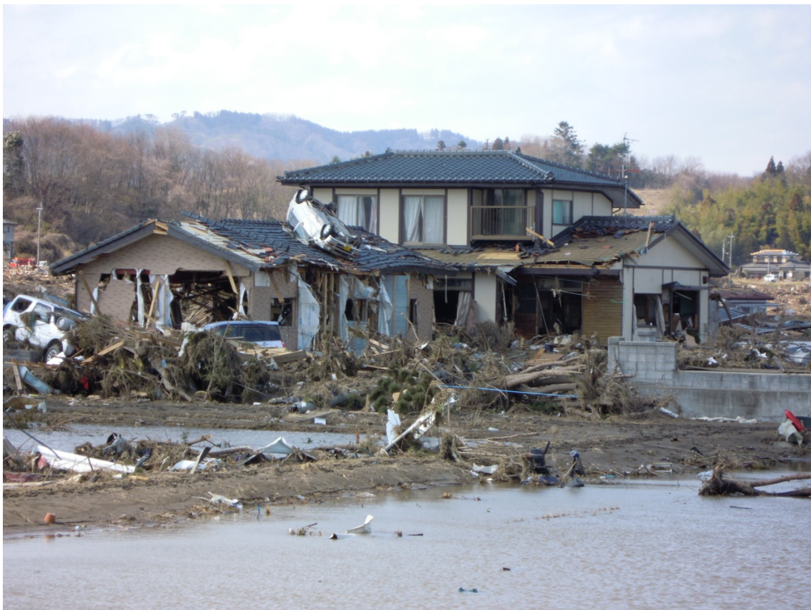
1階の屋根に車が載っている。
