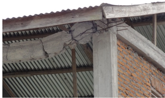
(d) Collapse of confining element
