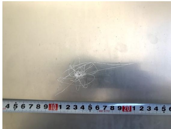
図2 免震層のけがき板の状況
