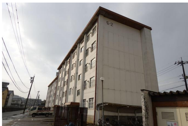
(f) 2号棟全景（目立った被害はない）
