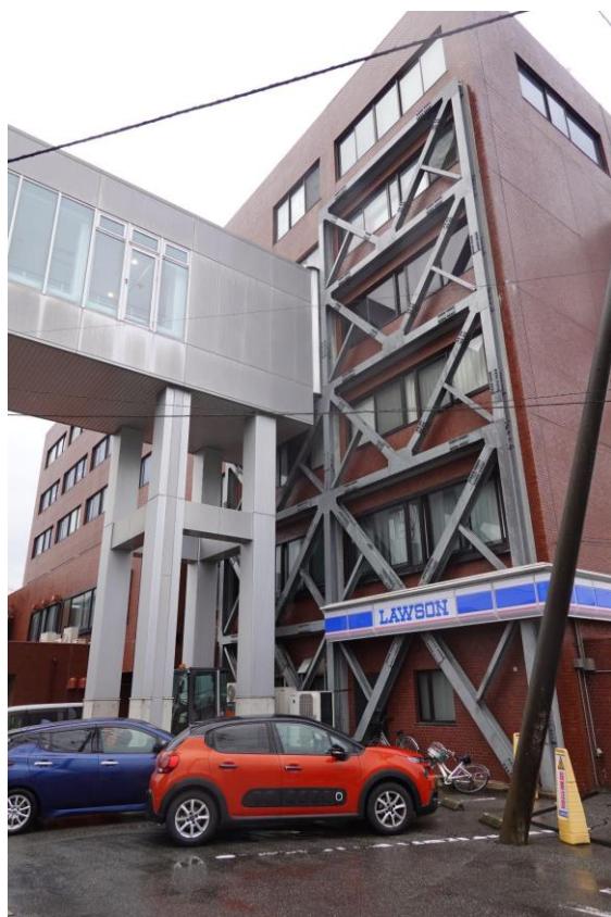
(h) 外付けブレース補強
