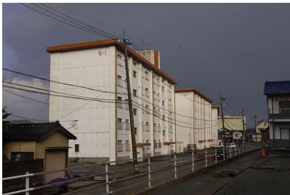
(g) 1号棟は西側（川側）へ7/1000傾斜。高架水槽も傾斜 図 4.3 W-3 の被害事例
