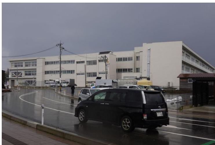
図 4.11 建物全景。一番右の校舎が南に 3/100 傾斜
