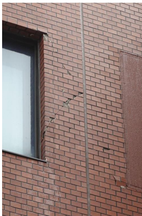
(i) 補強が少なくなる層での損傷
