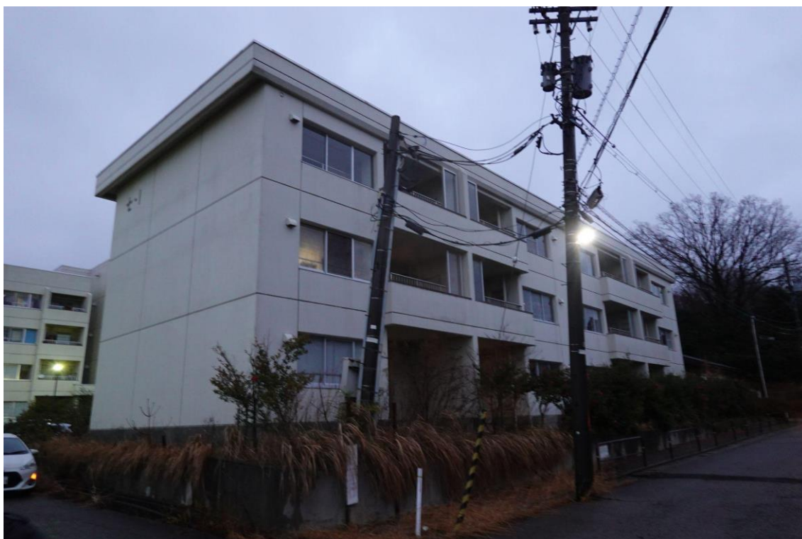
図 4.30 建物全景 被害なし
