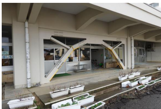
(d) 昇降口の補強フレーム
