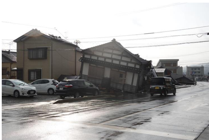
図 4.6 道路の反対側の木造住宅の倒壊。この辺りは木造の倒壊も多い
