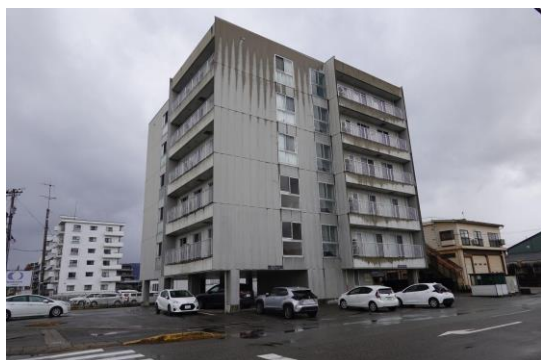
(a) 全景（ピロティに見えるがS造）
