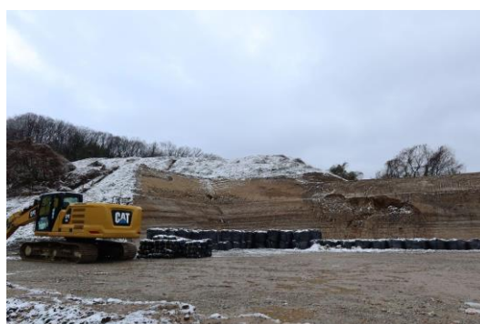
(d) 近隣にある造成中の敷地
