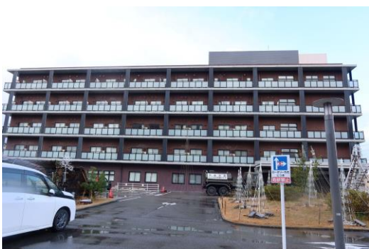
(m) 鉄骨造と思われる5階建て介護施設全景
