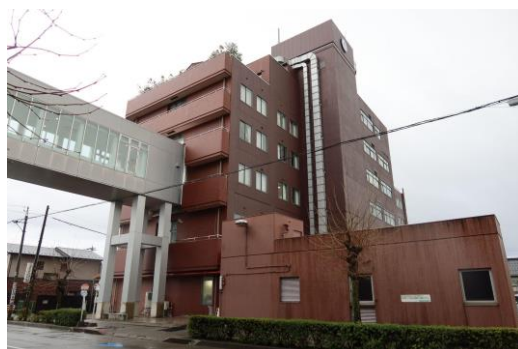
(j) RC造6階建て病棟②全景
