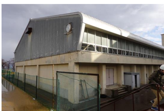
(i) 体育館1 目立った被害なし
