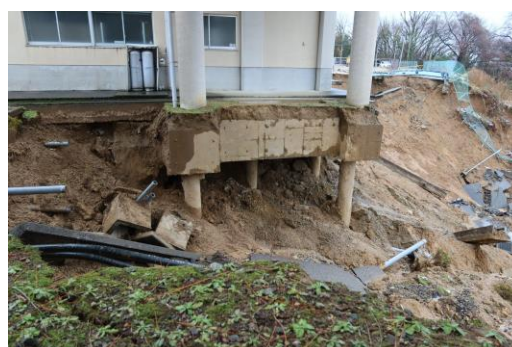
(b) むき出しになった基礎構造
