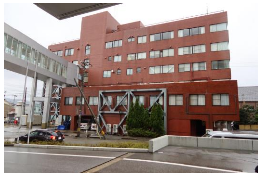
(g) 昭和 55 年建設の RC 造 6 階建て
