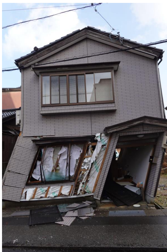
図 4.16 周辺の木造被害
