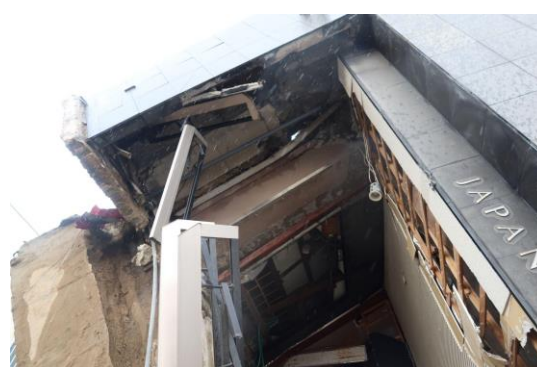
(h) 柱の巻き立て補強がされている？
