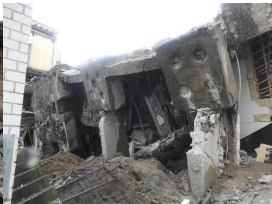
(c) 杭先端が埋まっていたと思われる穴部。型枠の木と思われるものが見える。
