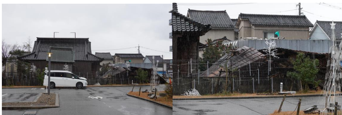
(c) お寺の被害。一棟倒壊 図 4.24 N-1 周辺の被害
