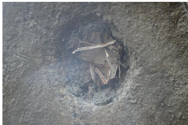
(c) 杭先端が埋まっていたと思われる穴部。型枠の木と思われるものが見える。
