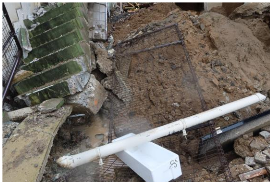
(c) 杭先端が埋まっていたと思われる穴部。型枠の木と思われるものが見える。
