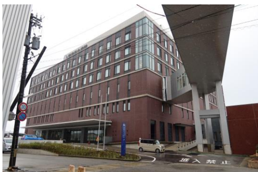
(c) 免震構造の病棟全景 (2013 年築)
