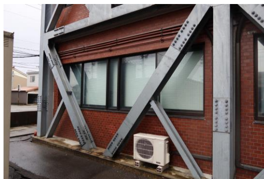
(h) 外付けブレース補強
