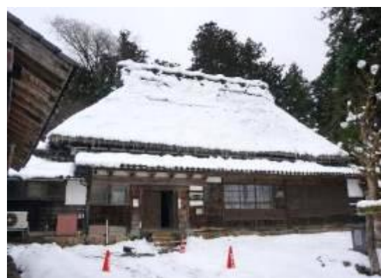
懐古館（七尾市）。外観上顕著な被害なし
