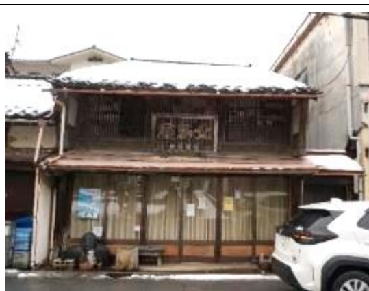
北島屋茶店（七尾市街）外観上被害なし
