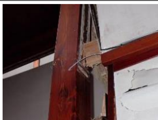
土間境柱内法で曲げ破壊（大崎邸）
