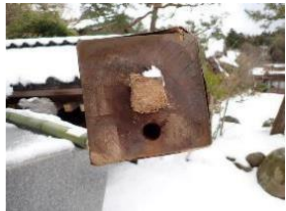
総持寺手水舎・柱脚
