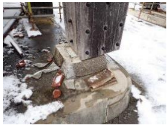
総持寺門・柱脚のずれ
