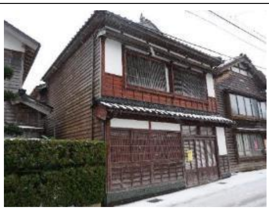
古い建物だが目立つ被害なし（鳳至町上町）
