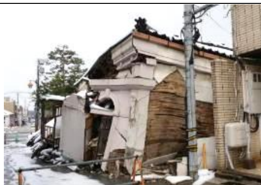
春木屋洋品店（七尾市街）初層崩壊。前面木部に腐朽
