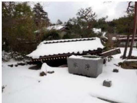
総持寺手水舎・倒壊
