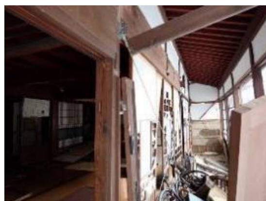
2007年地震被災後の補強ブレース（同左）
