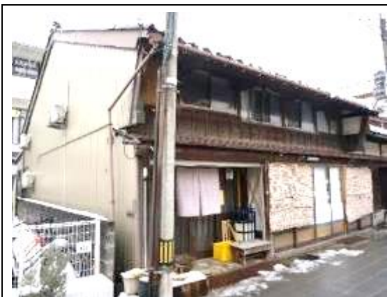
勝本家住宅（七尾市街）外観上被害なし
