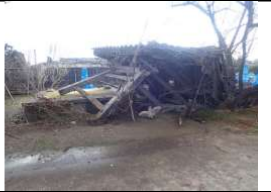
高福寺 鐘楼倒壊
