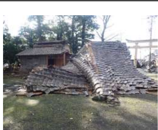
傾斜建物 土壁+片筋違の耐力壁（周辺で類似の仕様を散見）
