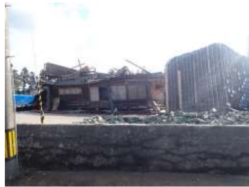
千光寺 境内 建物倒壊
