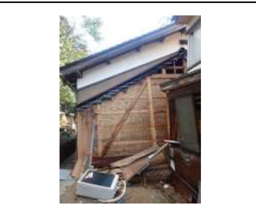
傾斜建物 土壁+片筋違の耐力壁（周辺で類似の仕様を散見）
