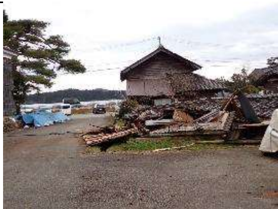
室木家住宅 隣家 倒壊
