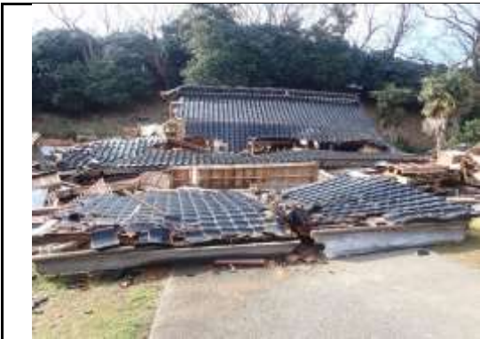
曹源寺 本堂 倒壊
