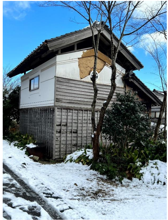
図 4.1.26 土倉の被害
