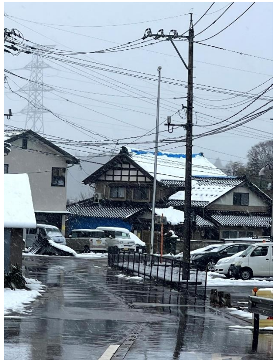
図 4.4.4 木造住宅の被害
