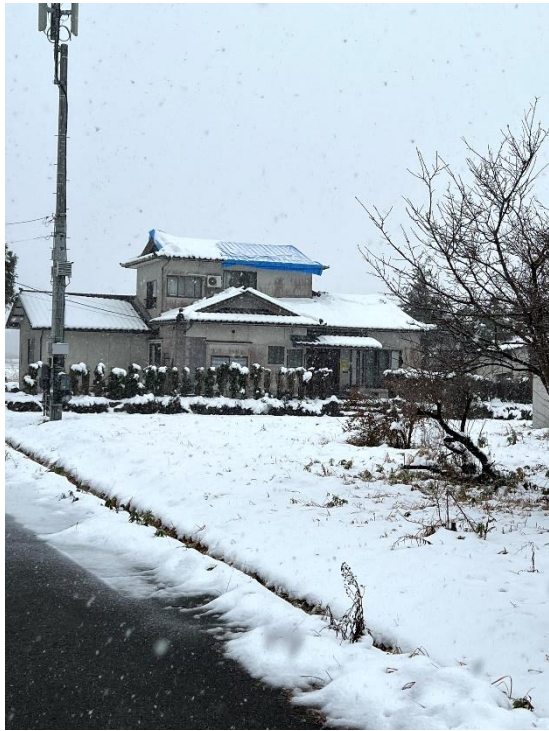
図 4.4.1 木造住宅の被害
