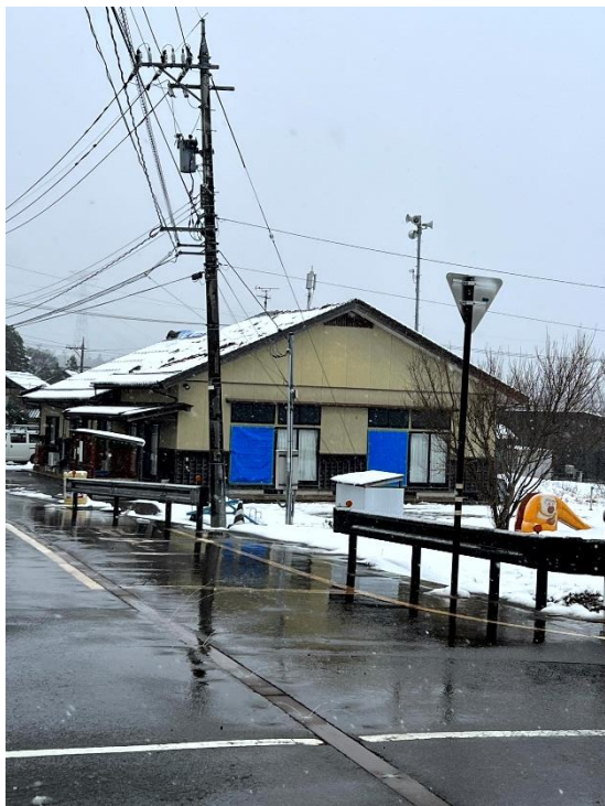
図 4.4.3 木造住宅の被害
