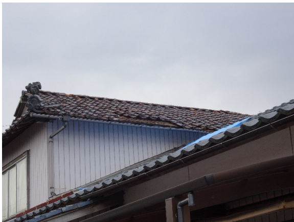
図 13. 屋根瓦の崩落（吉崎）
