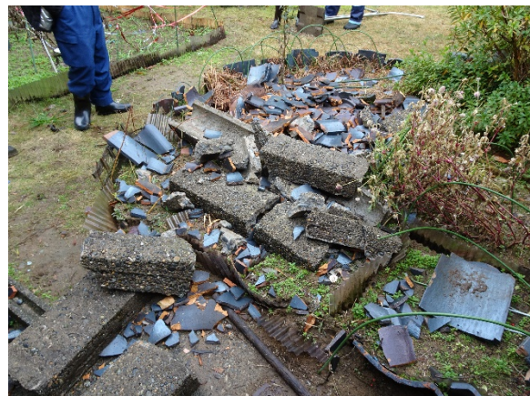
図 14. 崩落した棟モルタル（吉崎）
