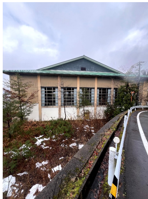
図8. 南面の外観（屋根直下の架構の両側に壁2枚が配置されている）
