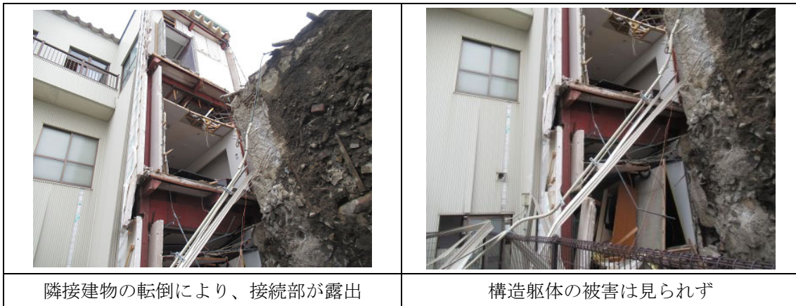
図 4-6-9 輪島市内のオフィスビル（鉄骨造）の様子
