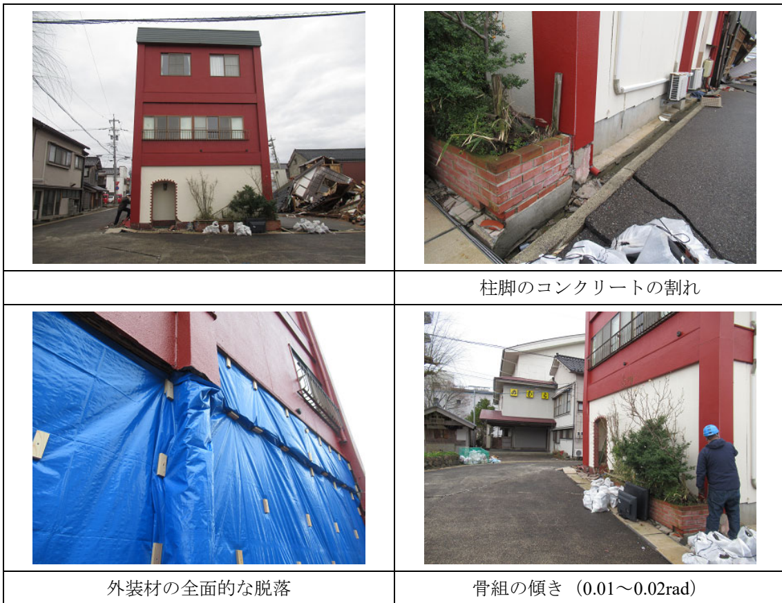
図 4-6-7 輪島市内のオフィスビル（鉄骨造）の様子
