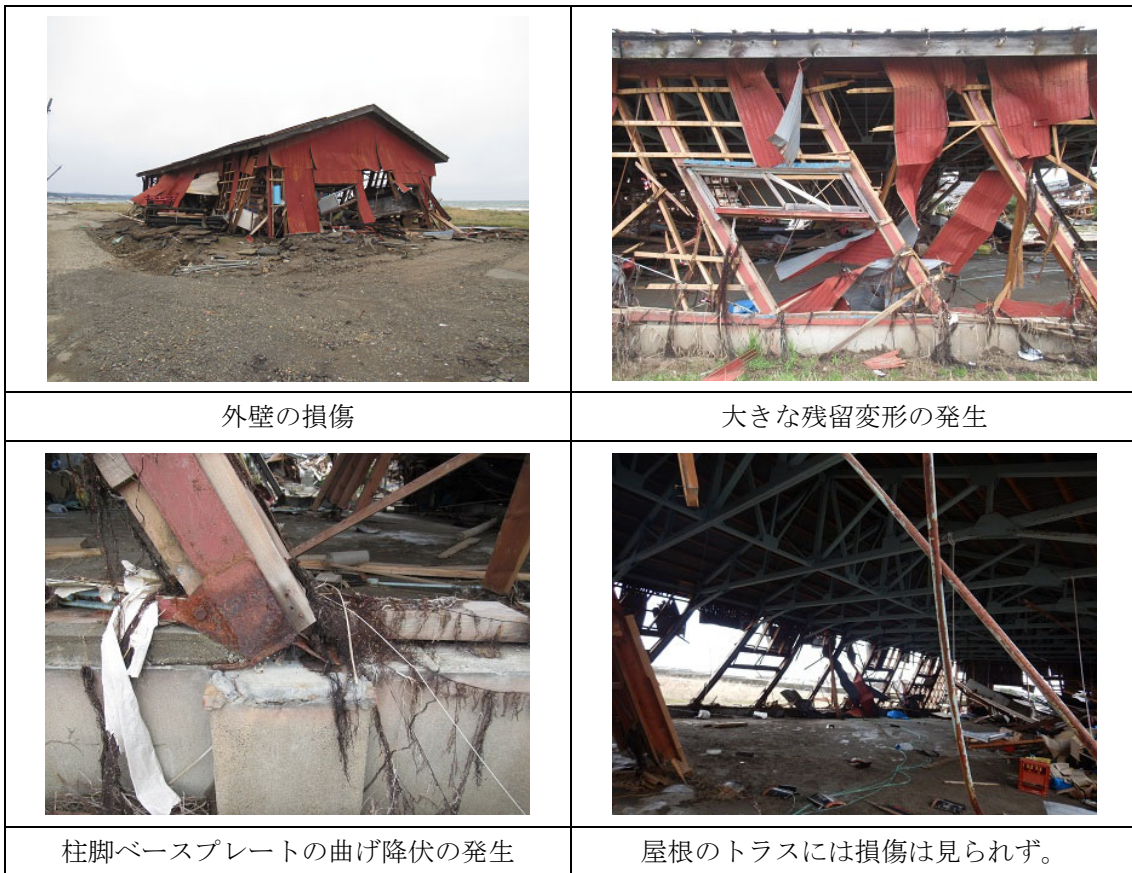
図 4-3-11 珠洲市内の倉庫（鉄骨造）の様子
