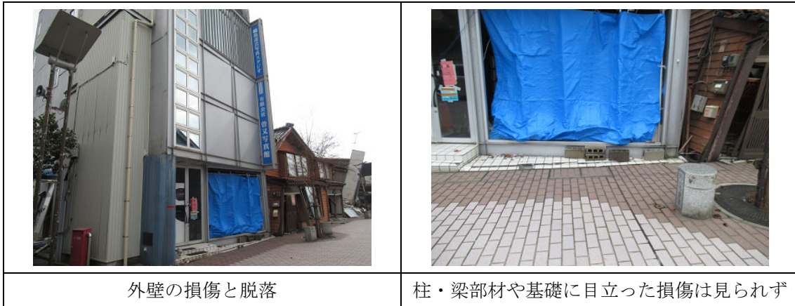
図 4-6-8 輪島市内のオフィスビル（鉄骨造）の様子
