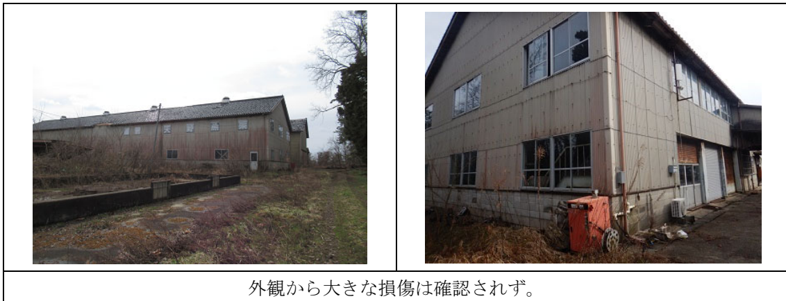
図 4-3-5 珠洲市内の工場（鉄骨造）の様子
