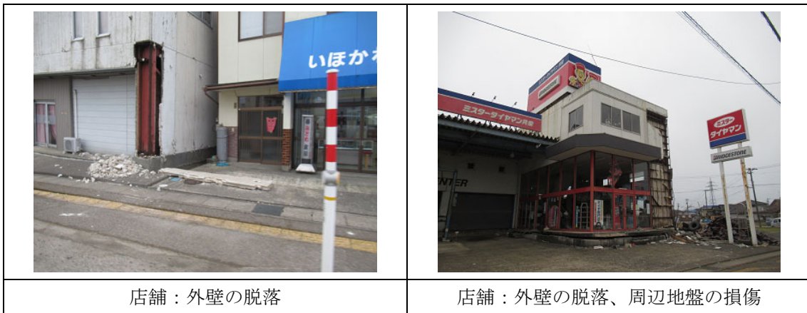
図 4-5-3 穴水町の道路沿いの鉄骨造の様子（移動中の車内より撮影・観察）
