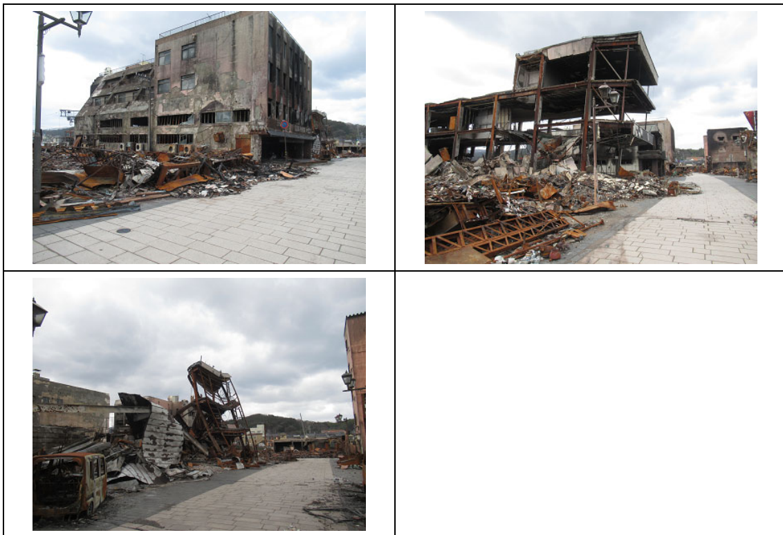
図 4-6-11 輪島朝市通りの鉄骨造の様子
