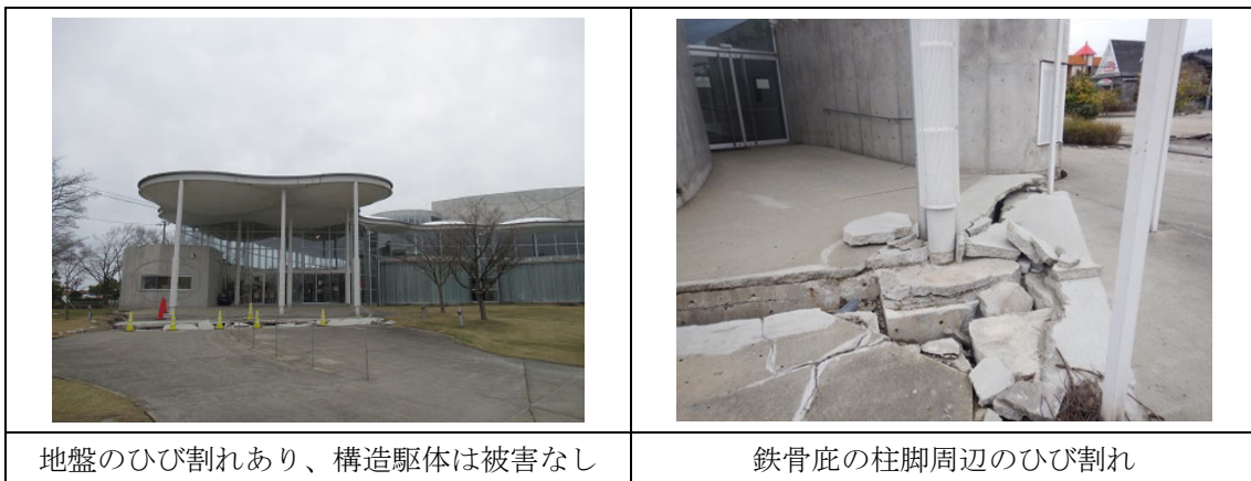
図 4-3-10 鉄骨と RC の混構造の多目的ホールの様子
