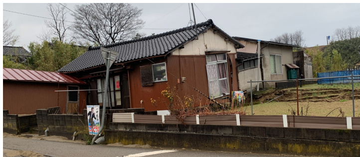
液状化による道路の傾斜
