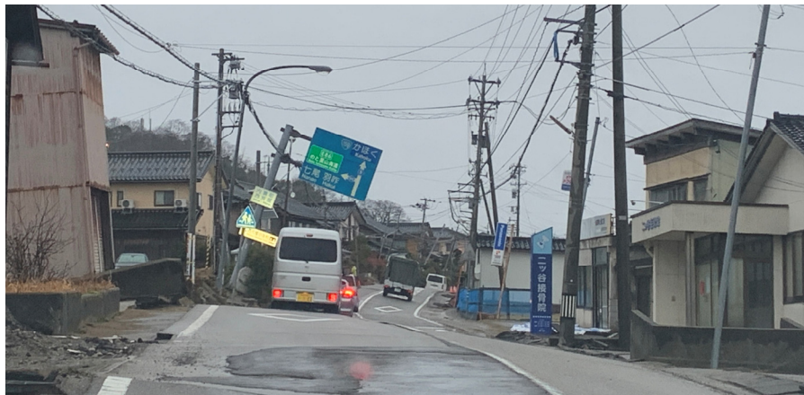
液状化による道路の傾斜
