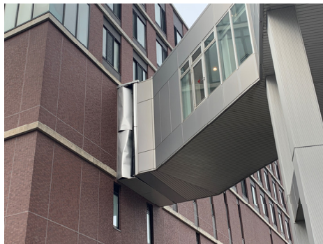
通路と建物のジョイント
