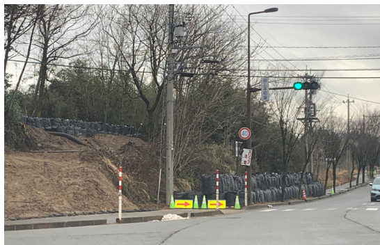
①斜面崩壊
