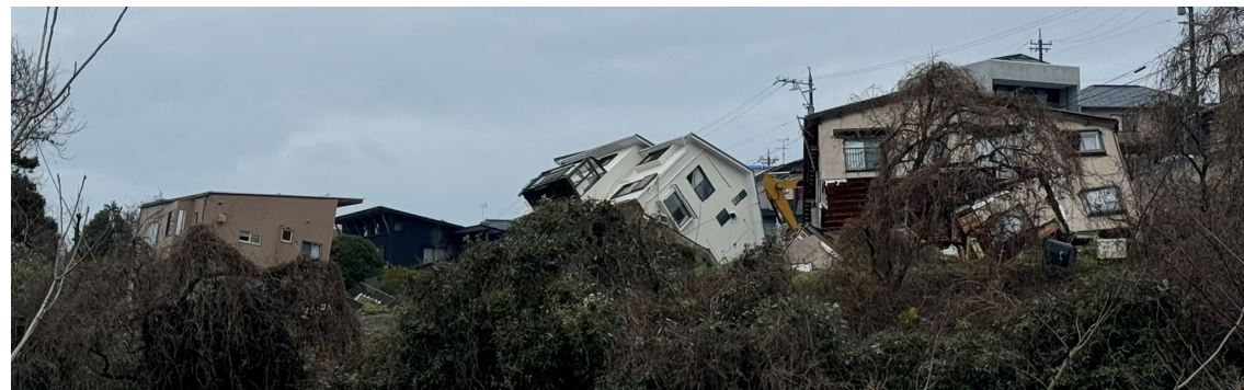
④斜面崩壊による木造住宅の全壊
