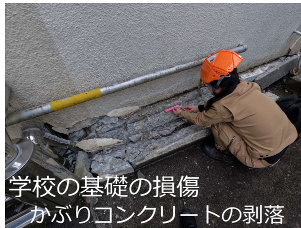
手前のRC建物の沈下 建物自体は健全
