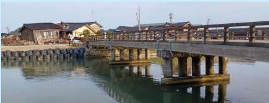
鶴飼川の最も海側の橋(鶴飼漁港に向かう)も通行止め
