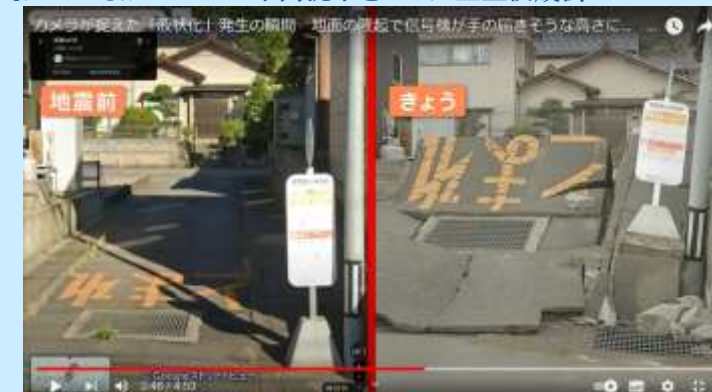
写真の道路被害は確認できなかった(バス停は小学校前)
