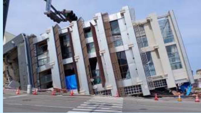
ビルの被害は新潟地震(1964)のような地盤の液状化による転倒と思っていたが基礎梁の折損など抵抗の跡が見られる。RC柱がスチールで覆われ破損状況が確認できない
