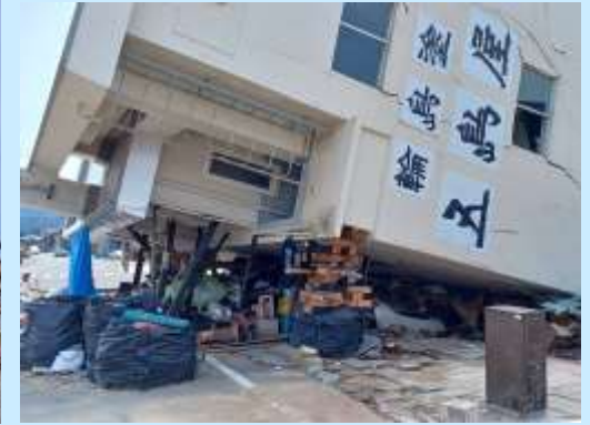
ビルの被害は新潟地震(1964)のような地盤の液状化による転倒と思っていたが基礎梁の折損など抵抗の跡が見られる。RC柱がスチールで覆われ破損状況が確認できない
