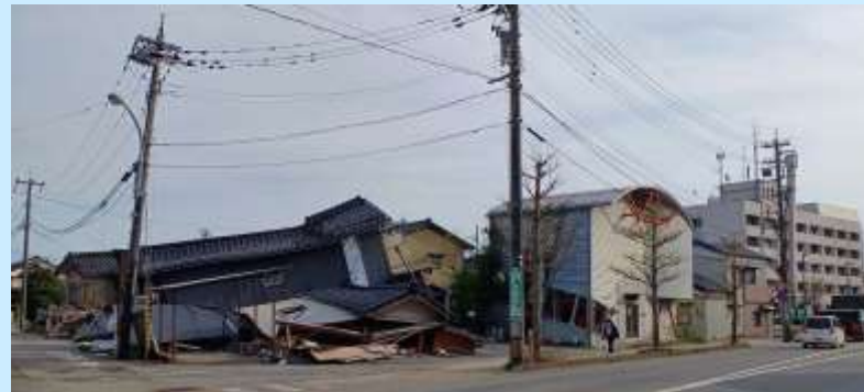
倒壊した家屋の奥に珠洲市役所が見える
