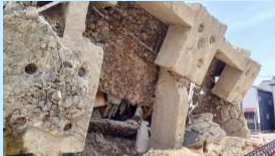
ビルの被害は新潟地震(1964)のような地盤の液状化による転倒と思っていたが基礎梁の折損など抵抗の跡が見られる。RC柱がスチールで覆われ破損状況が確認できない
