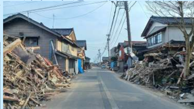
道路啓開のため被災住宅の破壊状態は判然としない
