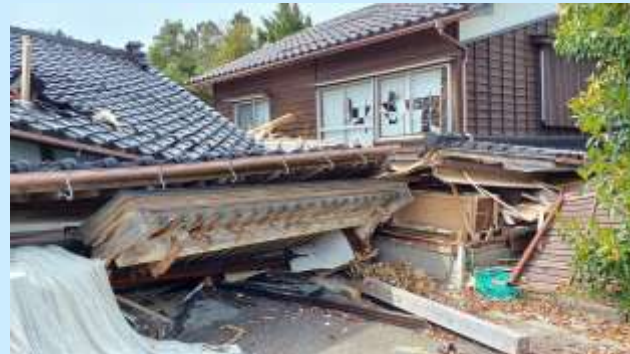
木造住家の被災状況
