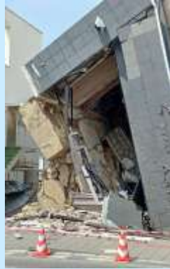
ビルの被害は新潟地震(1964)のような地盤の液状化による転倒と思っていたが基礎梁の折損など抵抗の跡が見られる。RC柱がスチールで覆われ破損状況が確認できない
