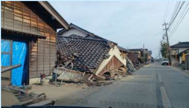
地震で全壊した木造住家
