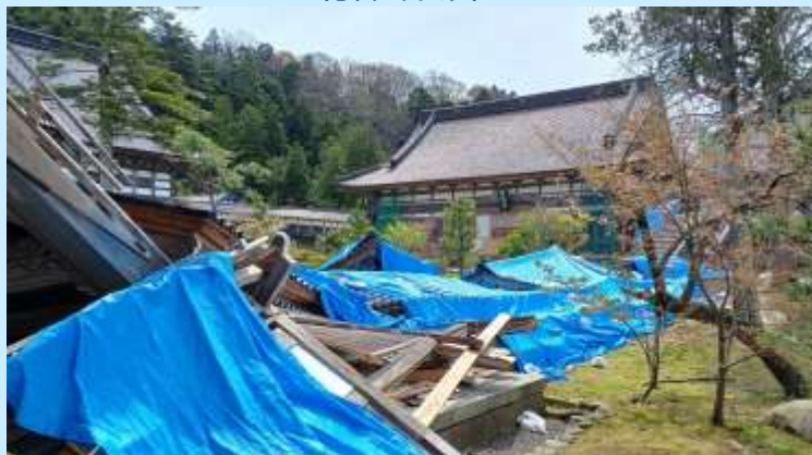
総持寺境内の被害状況
