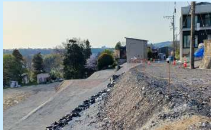
崩壊斜面上の被災住宅はさすがに片付けられていたが, 造成地は現状に復元されることなく, 道路も通行禁止になっている
