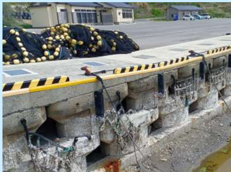
鹿磯漁港の岸壁
