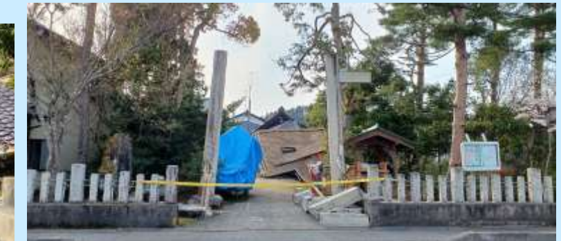
上戸町神社の被害状況
