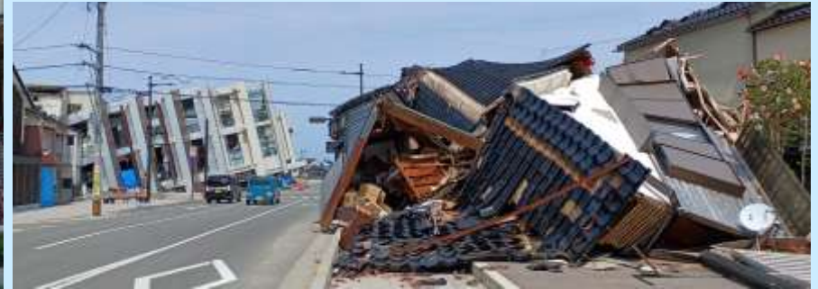
ビルの被害は新潟地震(1964)のような地盤の液状化による転倒と思っていたが基礎梁の折損など抵抗の跡が見られる。RC柱がスチールで覆われ破損状況が確認できない
