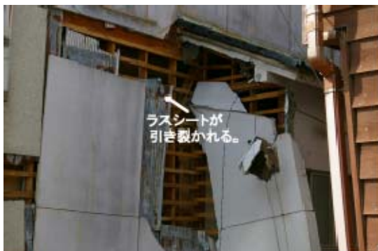
写真9 木造ラスシート剥落の例
