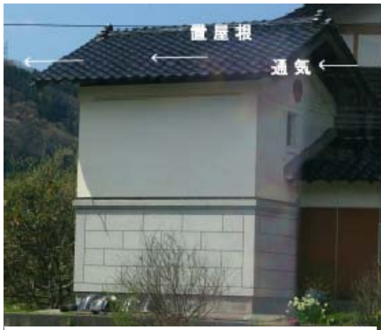
写真3 被害が見られなかった土蔵 通風を考慮した置屋根工法では、土壁や下地、躯体の腐朽がしにくい
