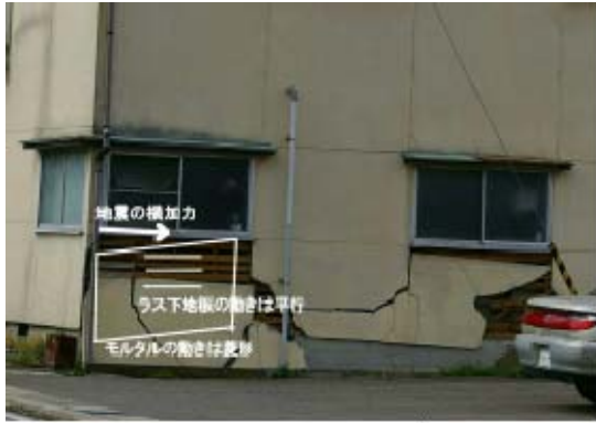
写真8 開口部のラスモルタル剥落例
