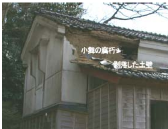
写真4 剥落した土壁表層部 瓦を防水シートなしに取付けてあることから、雨水が直接土壁に進入し、構造部材、木舞、土壁を腐朽させている。下塗り層は健全であり、防火性能は確保できている。
