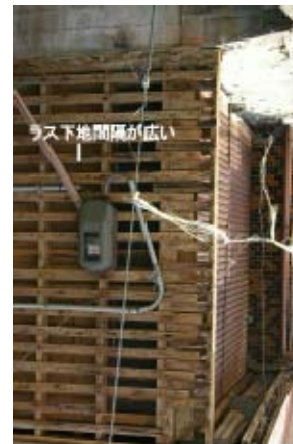
写真6 ラスモルタル外壁の剥落事例 ラス下地板間隔が広いと、ステーブルの留め付け間隔が粗くなり保持力不足が生じる。
