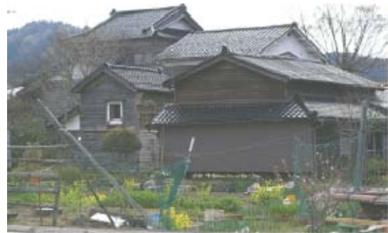
写真1 被害が見られなかった建物
