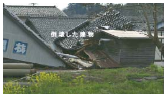
写真2 倒壊した建物
