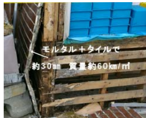
写真7 ラスモルタルタイル仕上げの剥落事例 下地板間隔が広いこと、躯体および下地に腐朽が見られること、ラスモルタルとタイル仕上げの質量が約60kg/m 2 と重いこと、ラスの質量不足、ステーブルの長さ不足などが原因と思われる
