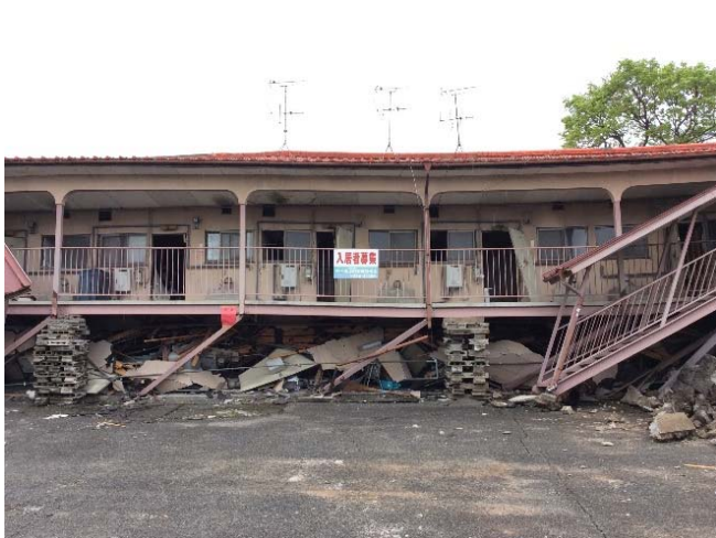
木づくり下地壁木賃アパートの一層崩壊、西側に変形
