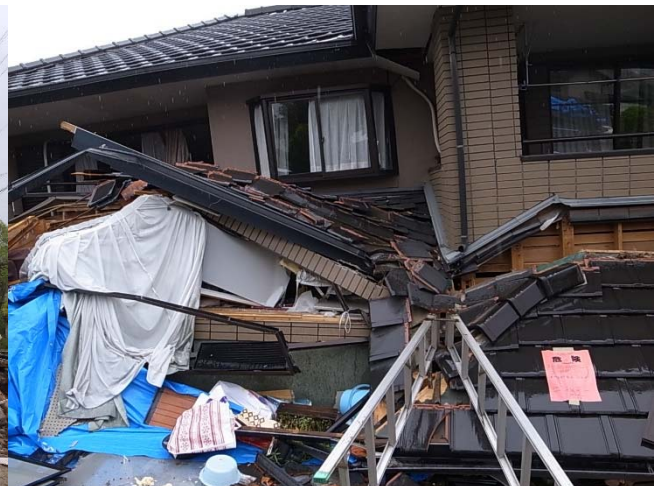
一層崩壊と下屋の脱落
