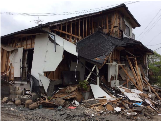
外壁の剥落と下屋の脱落
