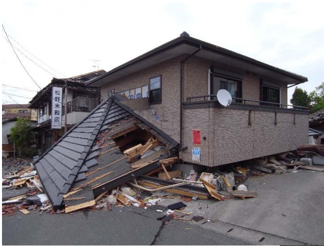
軸組接合部と金物の破壊状況
