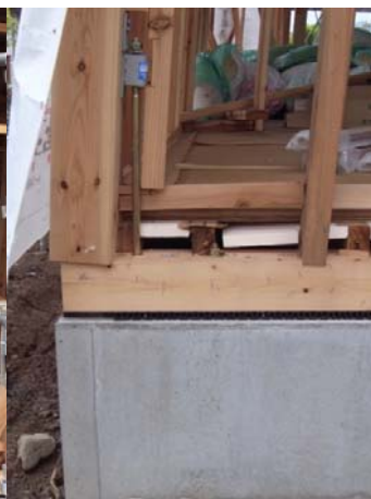
HD金物とアンカーボルト の設置状況と柱のずれ
