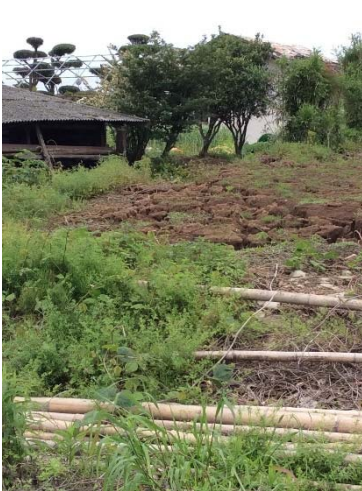
安永地区南側の地割れ
