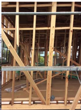
筋かい・間柱の座屈、 筋かい金物の引抜け
