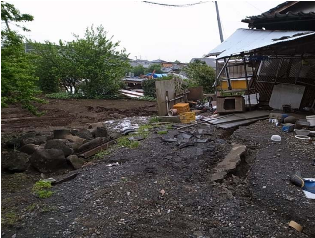
安永地区南側、公民館分室の西側付近の地割れ(右写真上に見える住宅は地割れにより転倒崩壊か?)
