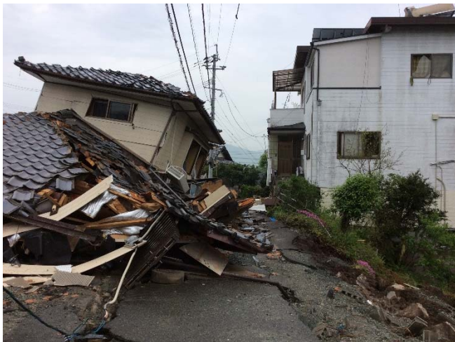
造成斜面の崩落と周辺家屋の被害
