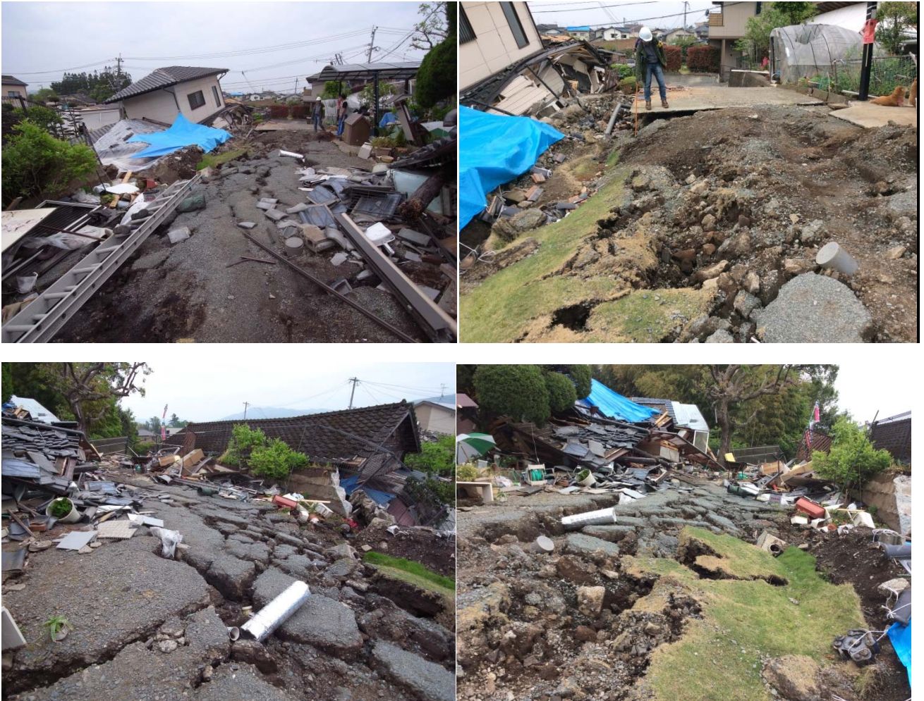
宮園公民館付近の大規模な地割れと擁壁の崩落および周辺家屋の倒壊
