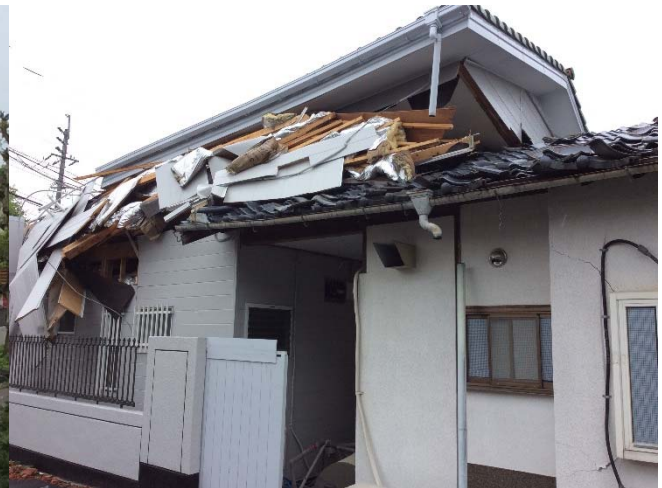
2 階部分の倒壊
