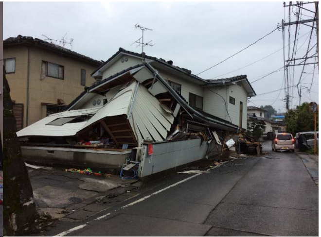
1階部分が西側に倒壊
