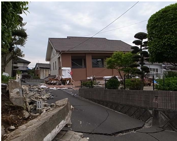
外壁全面 ALC パネル住宅（南面）の一層崩壊
