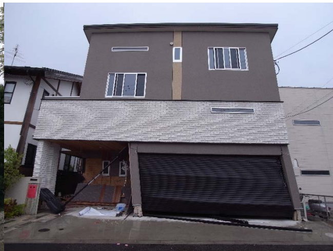
ガレージ部分の変形 東に傾斜
