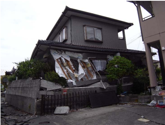
1階部分が西側に傾斜
