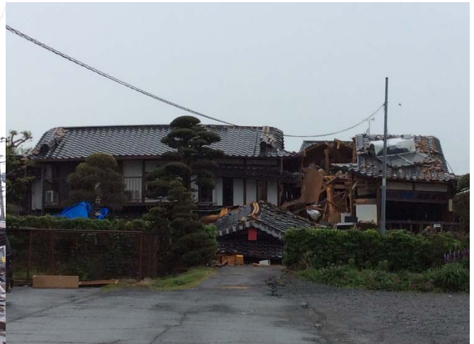
一層崩壊と下屋の脱落
