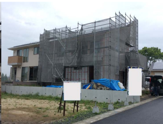
平成28年5月完成予定の分譲住宅
