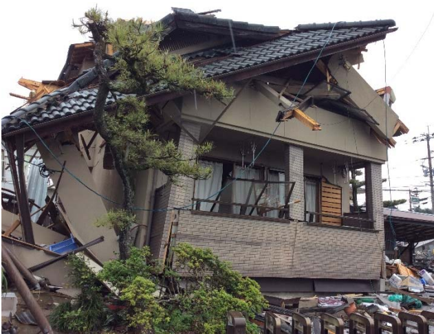
一層崩壊と 2 階屋根の脱落
