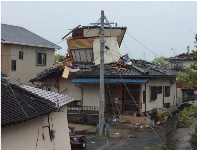
一部 2 階部分の損傷と 2 階屋根の脱落
