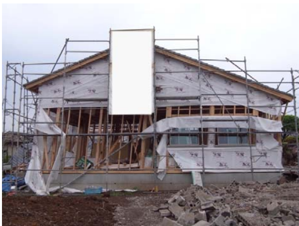
内壁石膏ボード施工前の軸組
