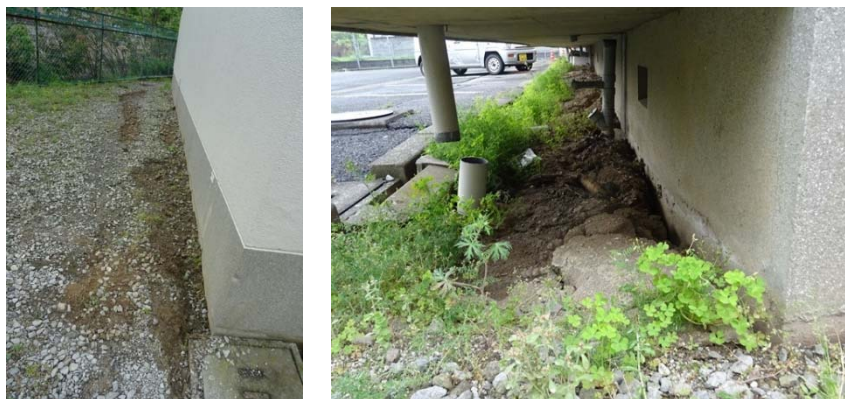
Fig.15 団地C（宇土市）の建物の状況
