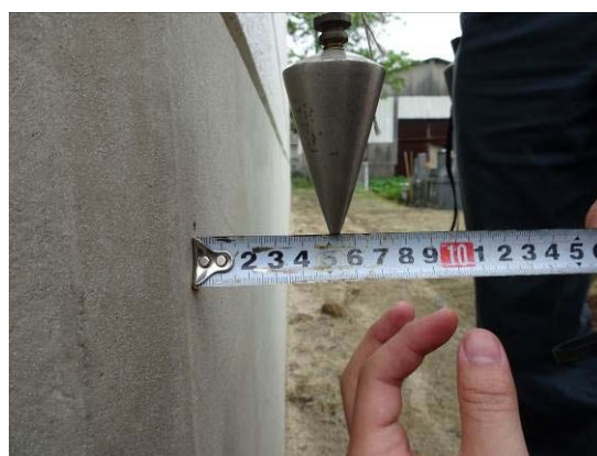
Fig.13 建物の傾斜の計測
