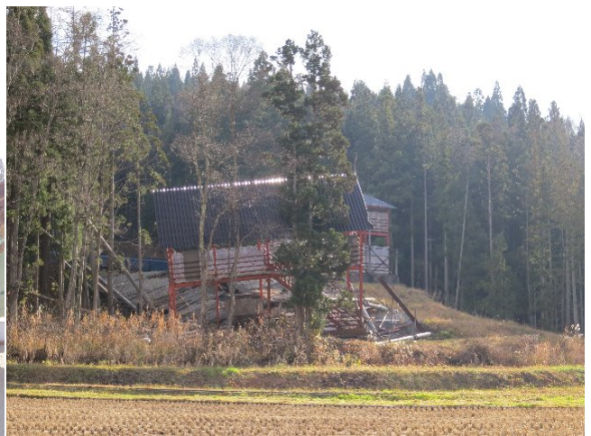
写真 60 被災 S 造建物(地盤変状)
