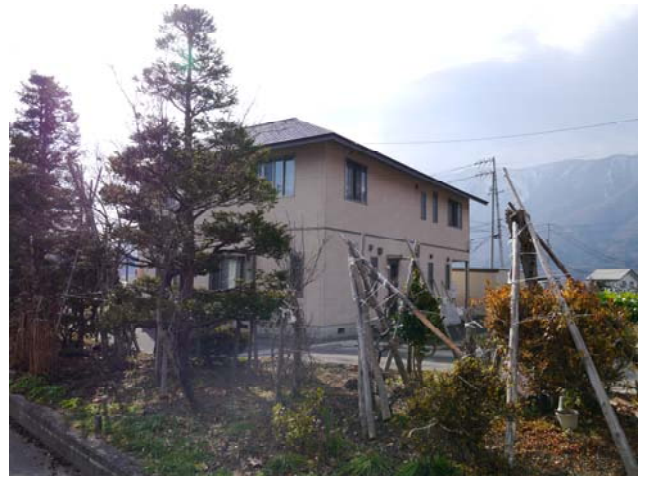
写真 34 外観上被害無し
