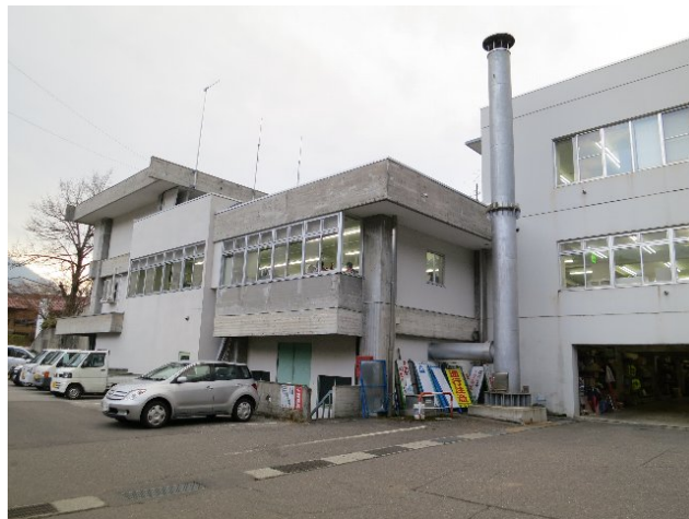
写真 6 小谷村地震計 周辺の状況
