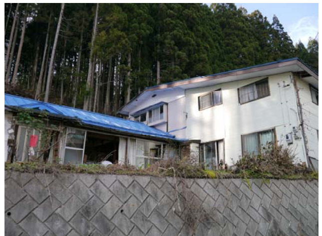
写真 38 北方向へ傾斜した住宅
