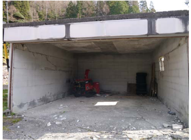
写真 22 補強 CB 造の目地のき裂
