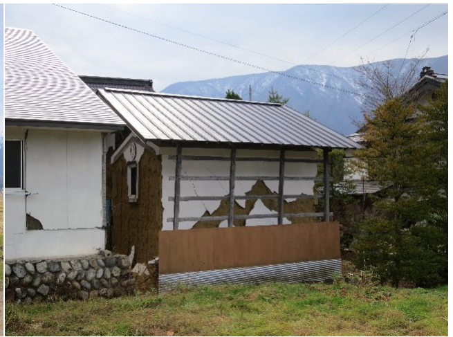
写真 64 被災建物外観(土蔵)
