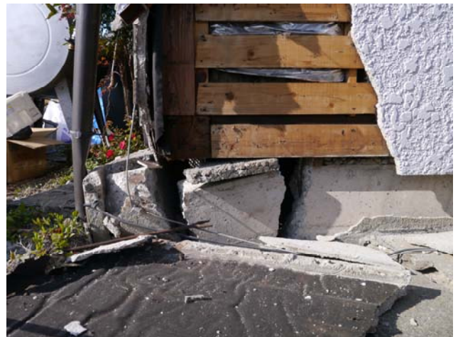
写真 26 無筋コンクリート基礎の被害
