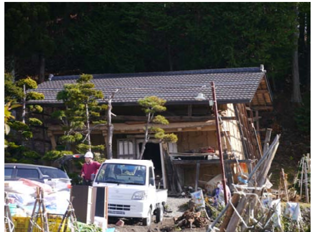
写真 24 土蔵の北への傾斜
