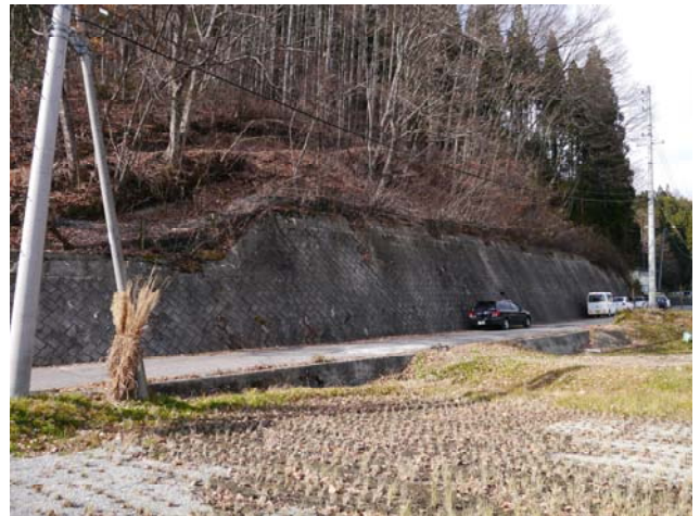
写真 36 大きく亀裂の入った擁壁
