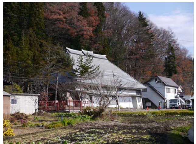
写真 14 伝統的構法の住宅の北への傾斜
