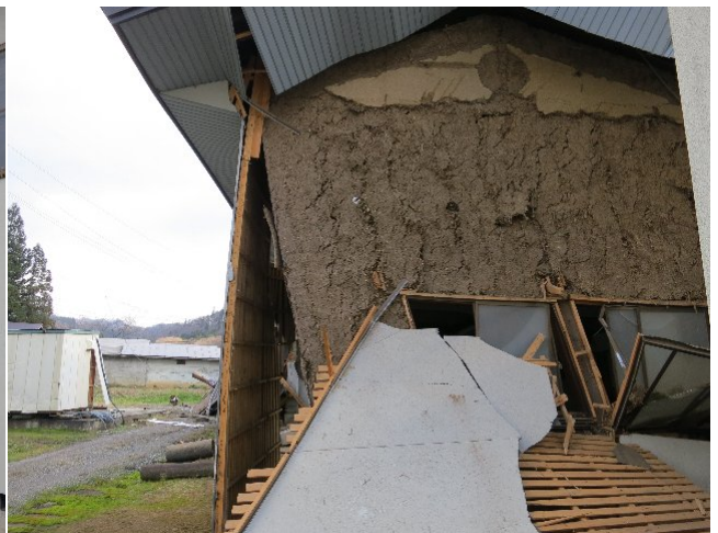
写真 58 被災建物残留変形
