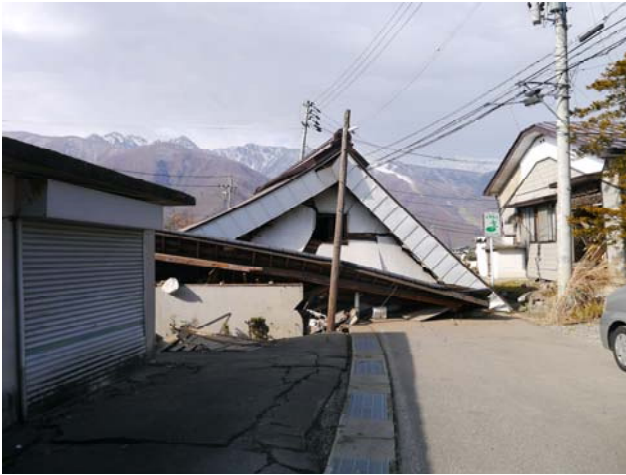
写真 15 伝統構法建物の倒壊
