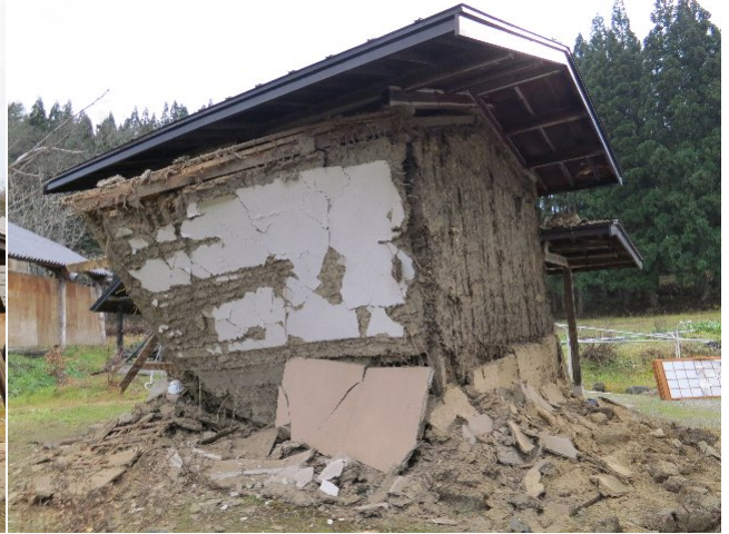
写真 70 被災建物外観(土蔵)
