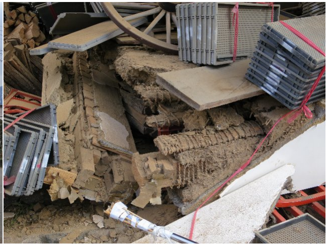
写真 62 被災建物軸組 (蟻害なし)
