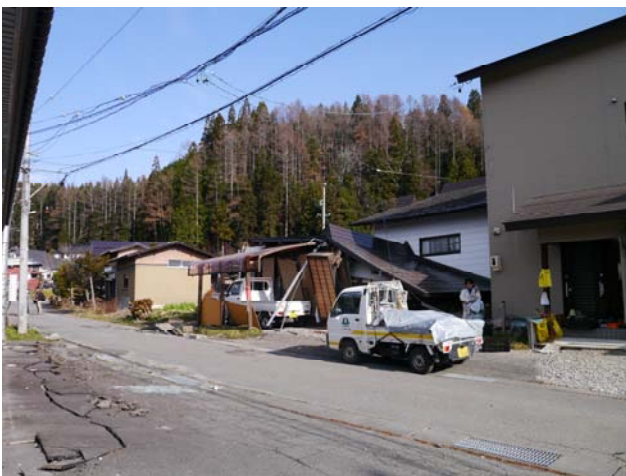
写真 13 在来構法 2 階建住宅の倒壊
