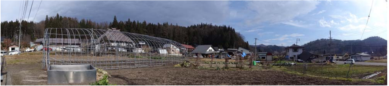
写真 9 堀之内 A 地区の被害状況
