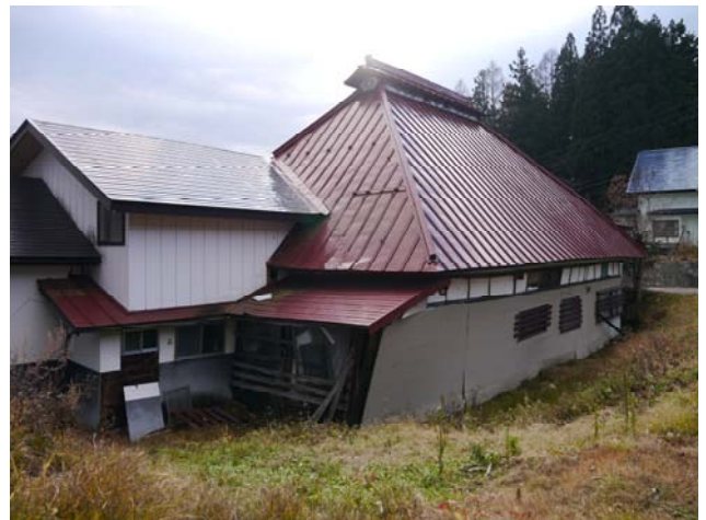
写真 54 北方向への傾斜
