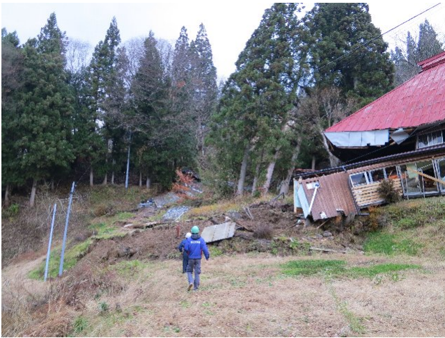
写真 81 被災建物近傍の地滑り
