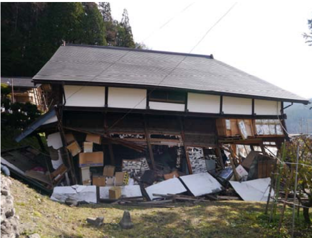
写真 23 垂れ壁付き独立柱の北への傾斜と折損
