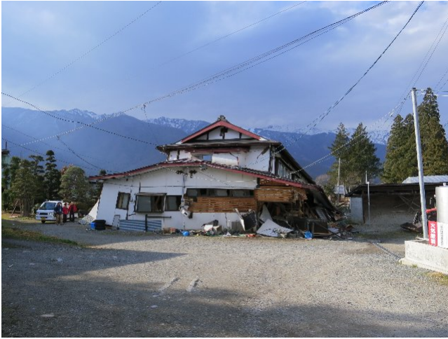
写真 55 被災建物外観 (旅館)
