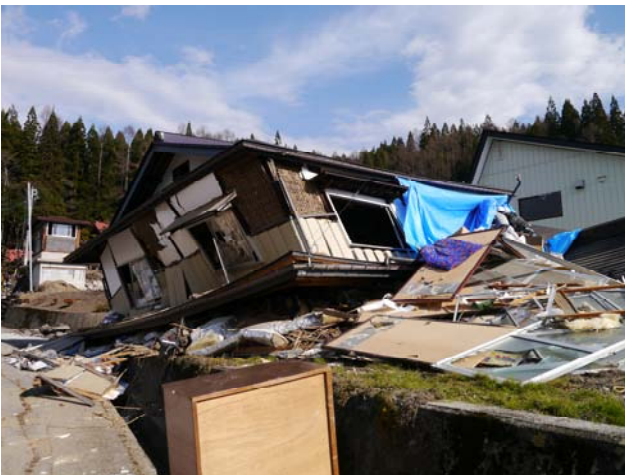
写真 25 土壁の在来構法 2 階建て住宅の倒壊
