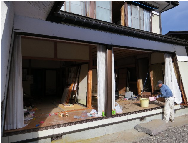
写真 67 被災建物室内の様子
