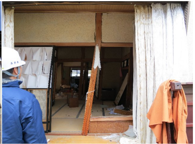
写真 68 被災建物柱の折損
