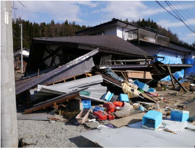
写真 27 倉庫の倒壊
