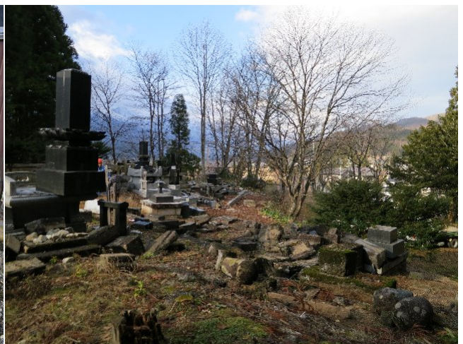
写真 76 三日市場地区の墓石転倒状況
