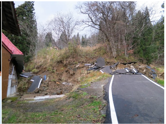
写真 84 被災建物裏の地滑り
