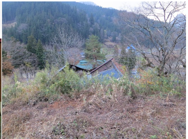
写真 86 被災建物（廃屋）
