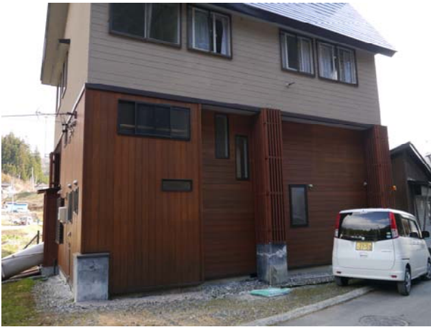
写真 39 1階に角形鋼管が使用されている
