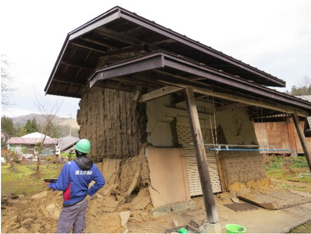
写真 69 被災建物外観(土蔵)
