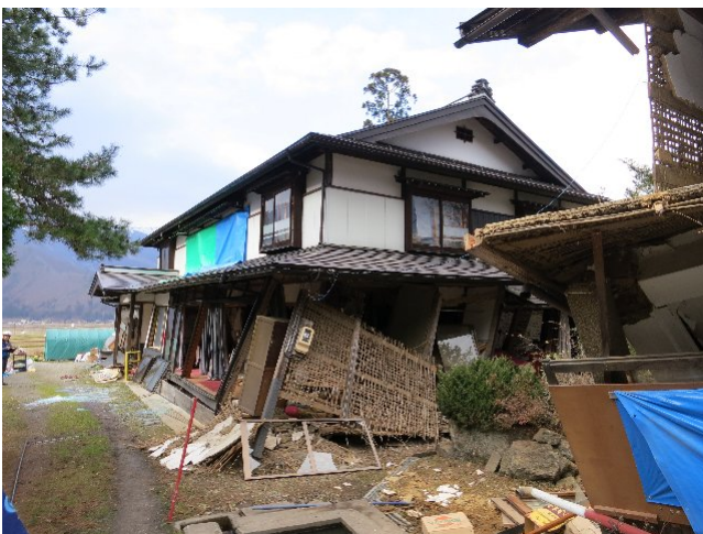
写真 71 被災建物外観(住宅)
