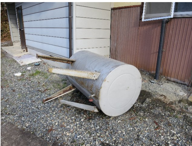
写真 75 灯油タンクの転倒
