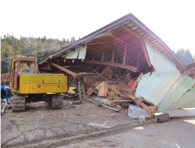
写真 59 被災建物外観 (車庫)
