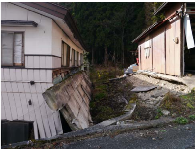
写真 41 崩壊した擁壁に押された建物
