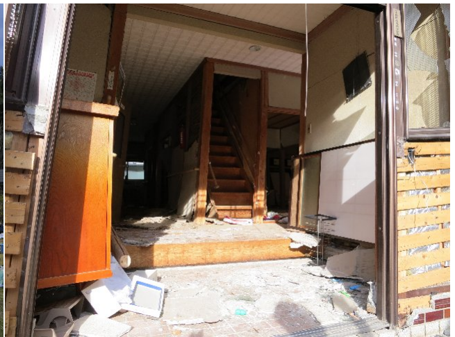
写真 66 被災建物室内の様子
