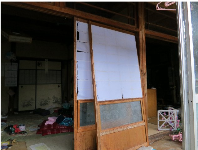
写真 79 被災建物の室内
