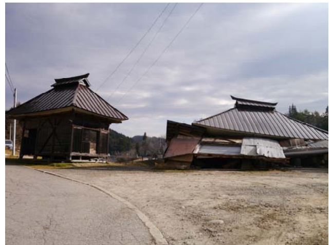
写真 50 倒壊した土壁の伝統構法建物
