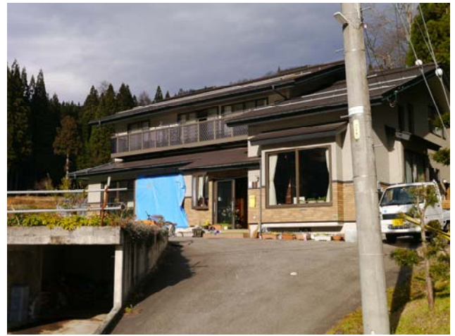
写真 48 応急危険度判定 要注意、傾斜なし
