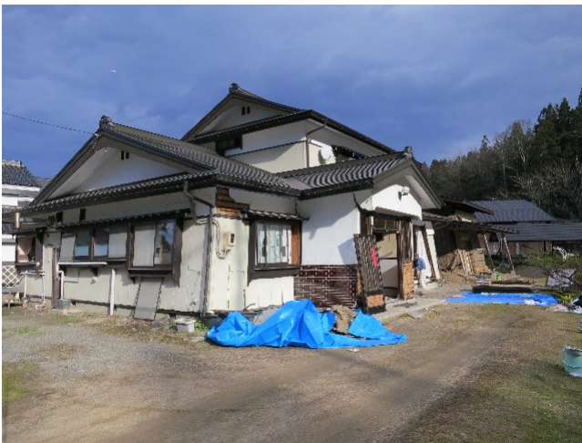
写真 65 被災建物外観
