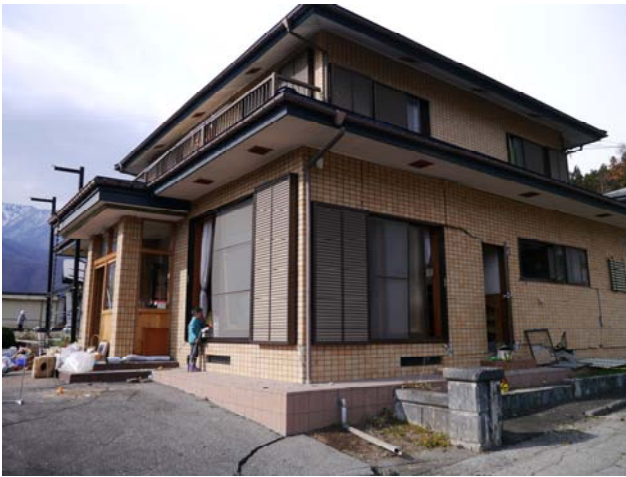
写真 33 モルタルのき裂と剥落
