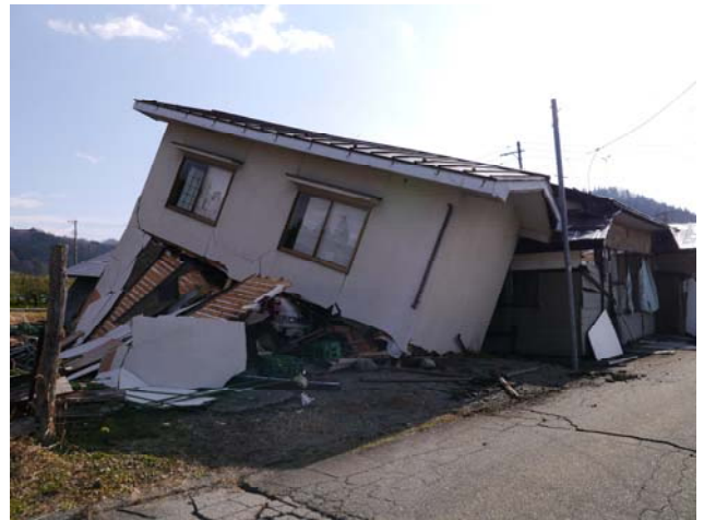
写真 18 車庫の倒壊
