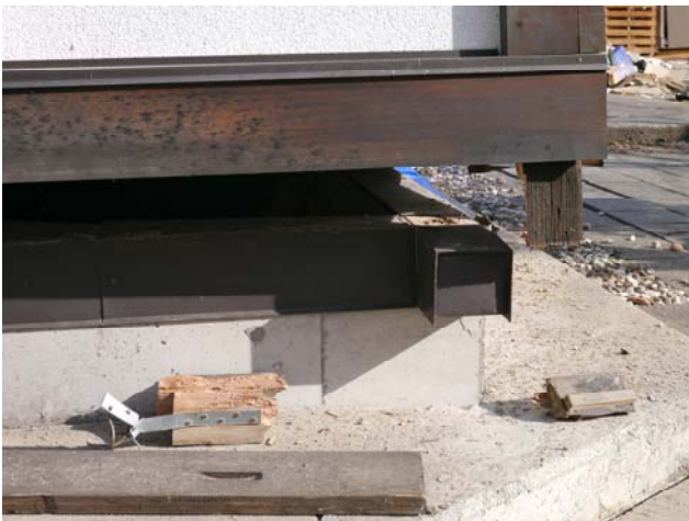
写真 43 柱脚金物の破損
