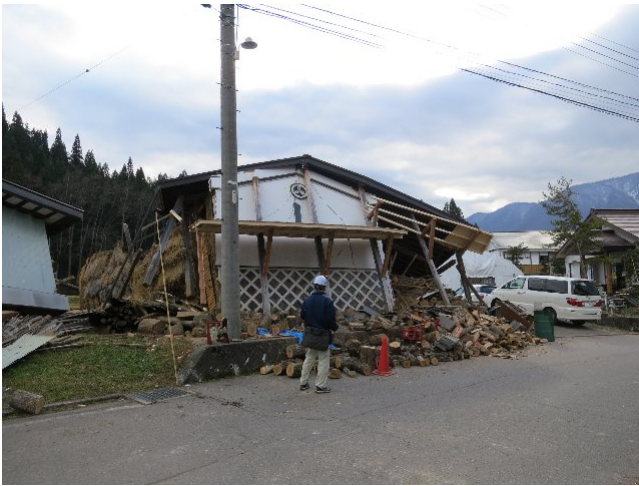
写真 61 被災建物外観(土蔵)
