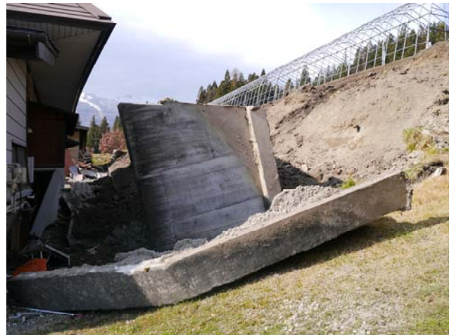
写真 30 建物背面の擁壁の崩壊
