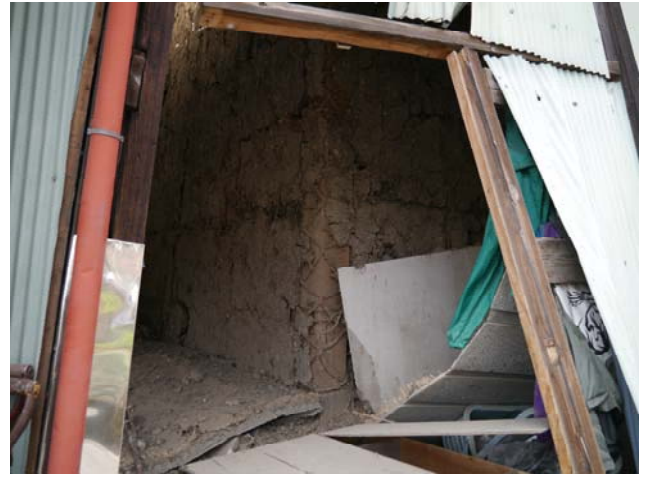
写真 46 土蔵のしっくい剥落
