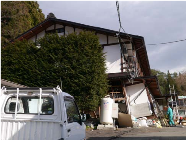
写真 45 旅館 1 階の傾斜（北方向）
