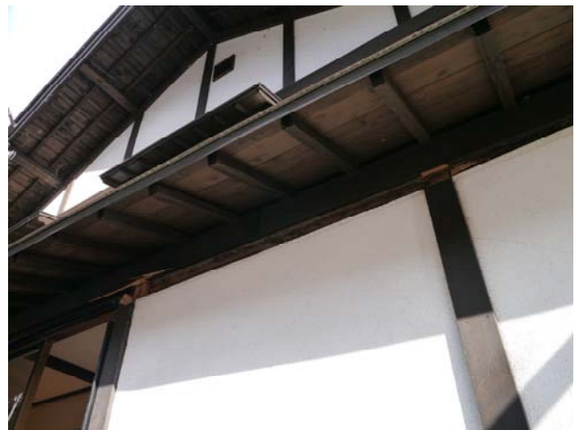
写真 42 柱頭長ほぞの抜け出し
