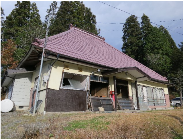
写真 73 被災建物外観(住宅)
