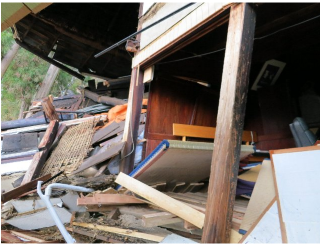
写真 83 被災建物の室内
