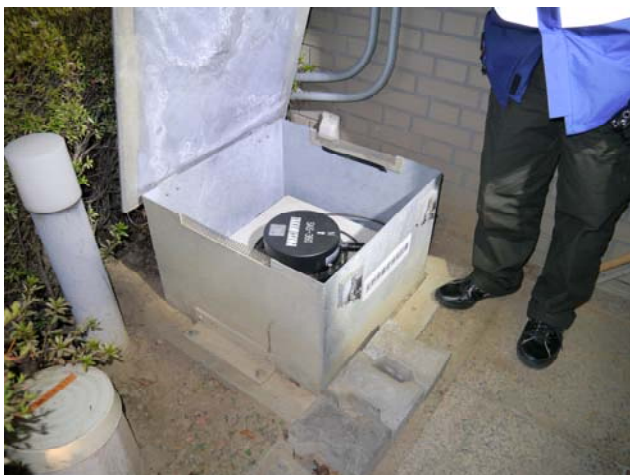
写真 7 小川村地震計 設置状況
