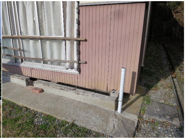
写真 74 被災建物のズレ
