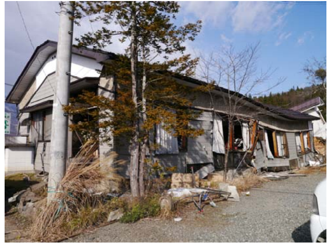
写真 16 堀之内公民館の傾斜と不陸
