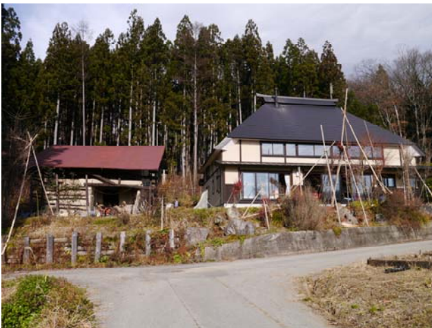
写真 31 右の建物は外観上無被害
