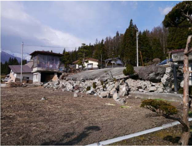
写真 21 擁壁の崩壊
