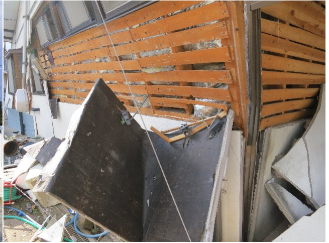
写真 56 被災建物外壁 (タッカー針の密度不足)
