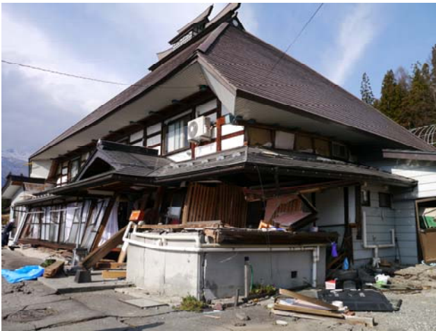
写真 29 伝統的構法の住宅の北への傾斜
