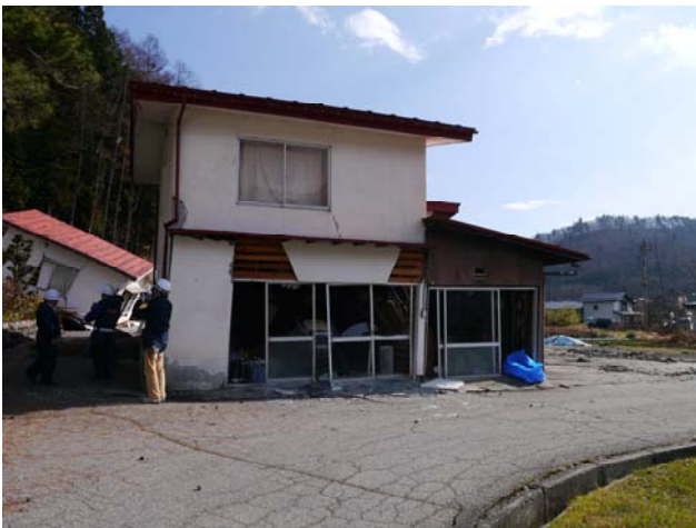
写真 19 モルタルの剥落
