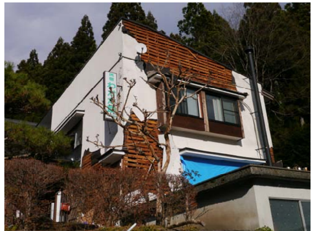
写真 44 モルタルの剥落
