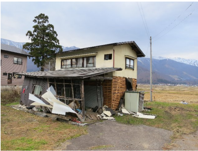
写真 63 被災建物外観
