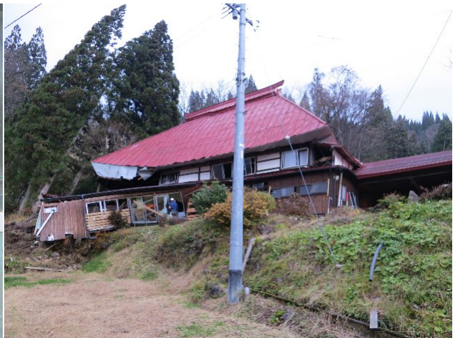
写真 80 被災建物外観
