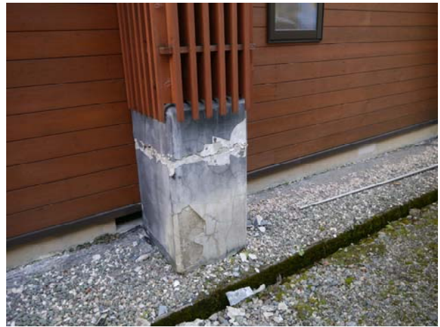
写真 40 写真 39 の鉄骨柱脚の被害
