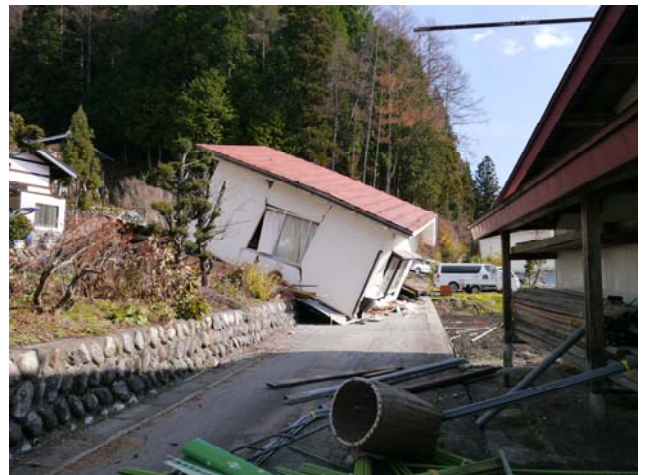
写真 20 南側へ倒壊し、道路へ転落
