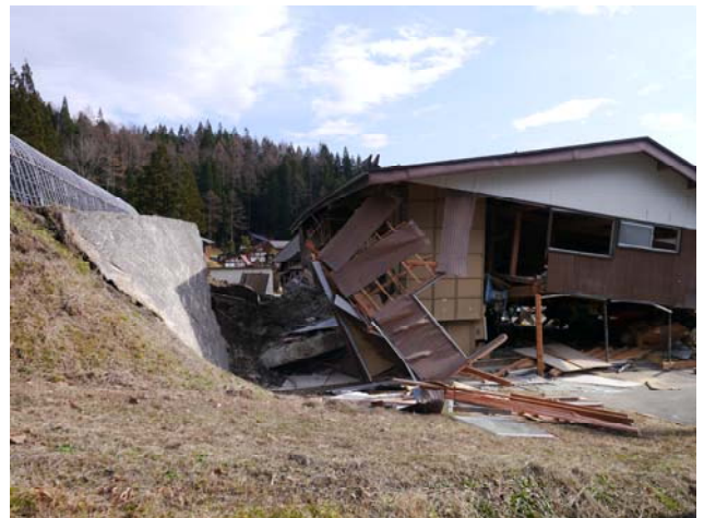
写真 32 崩壊した擁壁に押された建物
