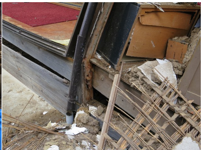
写真 72 被災建物柱の折損
