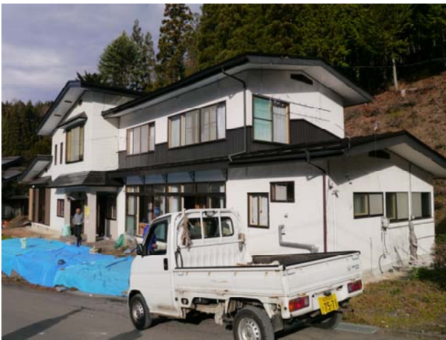
写真 49 応急危険度判定 要注意、傾斜なし
