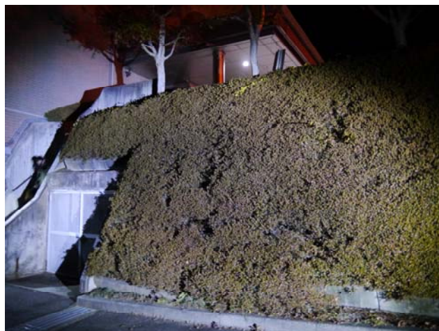
写真 8 小川村地震計 周辺の状況
