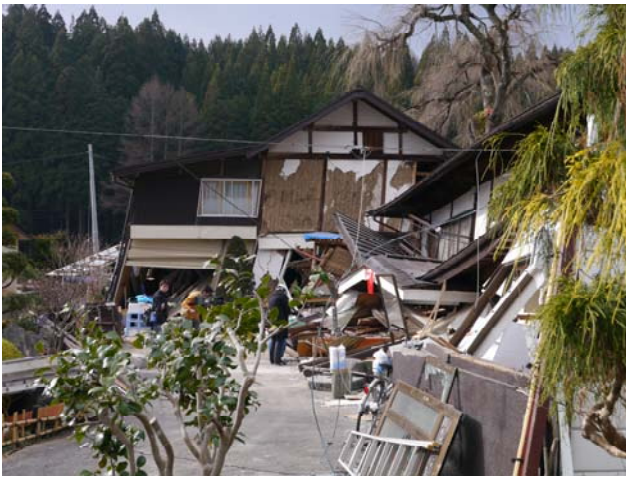
写真 47 北方向への傾斜と倒壊
