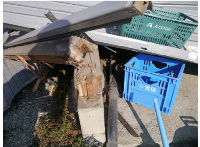
写真 28 写真 27 の柱脚固定金物は無し
