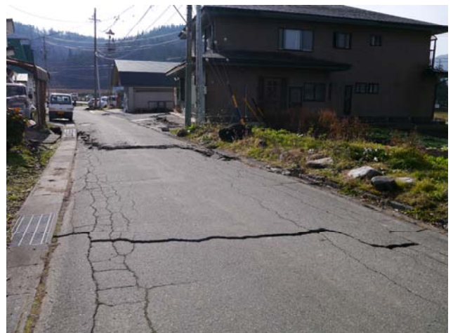
写真 12 地盤の被害
