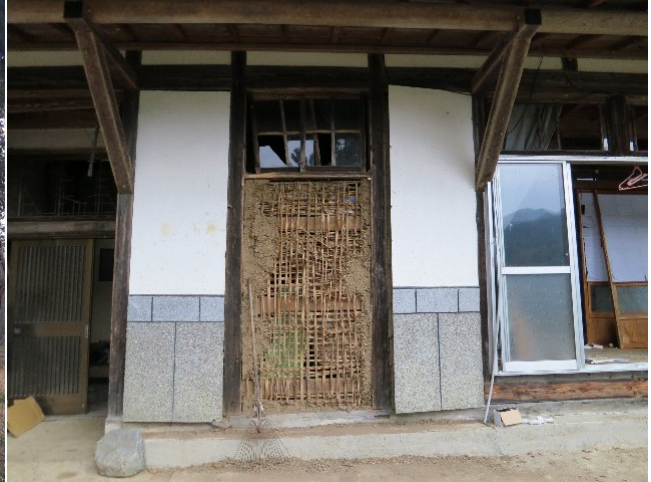
写真 78 土壁の脱落
