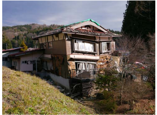
写真 52 高基礎建物（丸鋼φ9の鉄筋）の傾斜 （筋かいは40×115）
