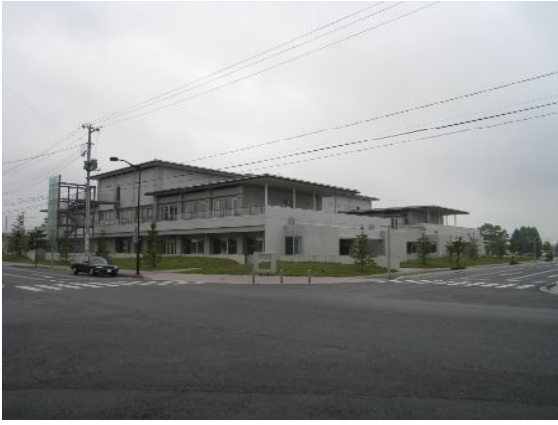
写真4 建物全景（栗原市立若柳病院）
