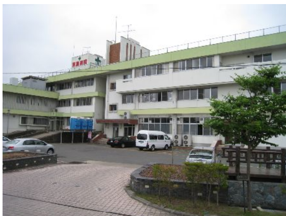
写真2 建物全景 (栗駒市立栗駒病院)
