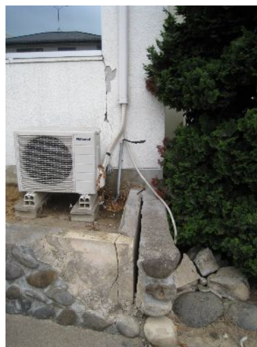
写真3 不同沈下 (栗駒市立栗駒病院)
