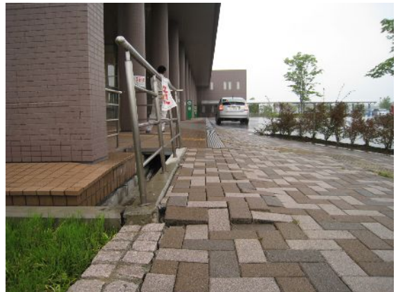
写真6 ドライエリアの損傷（栗原市立栗原中央病院）
