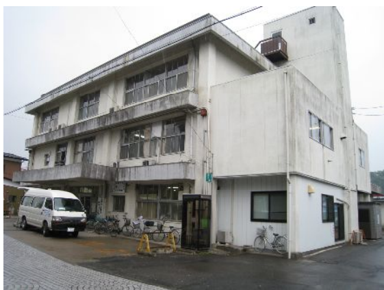
写真1 建物全景 (大崎市民病院岩出山分館)
