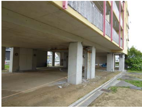
純ピロティ構面の被害
