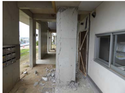
付着破壊した柱
