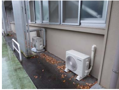
補強構面腰壁の水平ひび割れ
