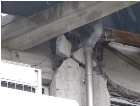
損傷した接合部の拡大写真
