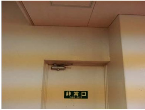
短スパン梁のひび割れ
