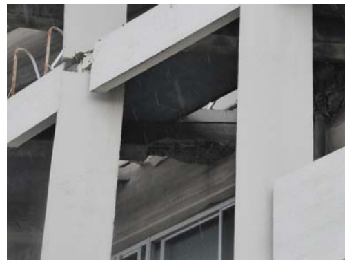
バルコニーを支える斜め梁の損傷
