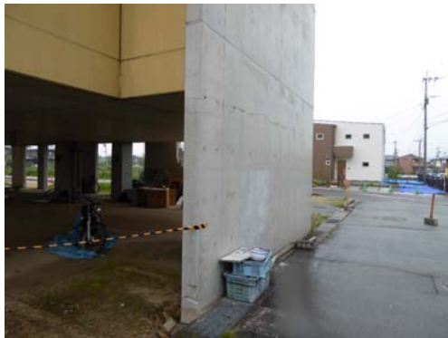
直交壁の面外ひび割れ
