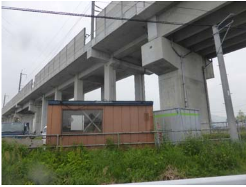
宇土市 RC造橋脚（無被害）
