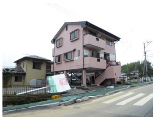
益城町 軽量鉄骨住宅（危険）
