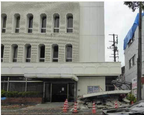
熊本市 外壁材の脱落
