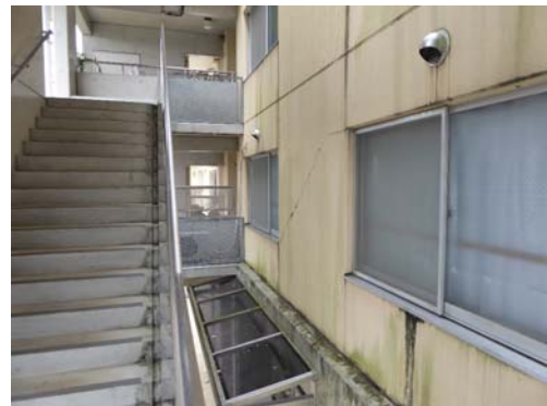
2階方立壁の損傷
