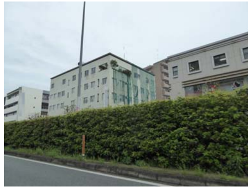
熊本市 病院の外壁（方立壁）の損傷
