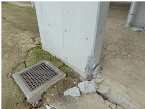
構面外壁の端部筋の損傷
