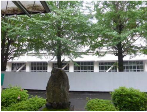
耐震補強された体育館
