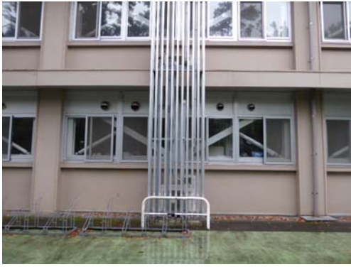
耐震補強ブレース
