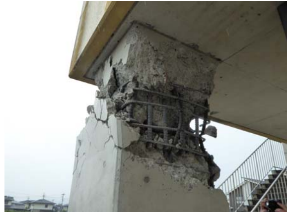
柱頭の損傷（主筋破断）
