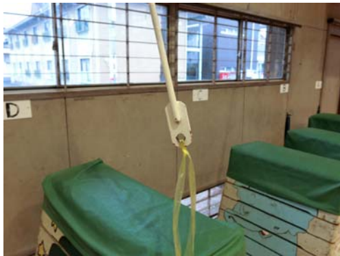
ボルト破断した既存屋根ブレース
