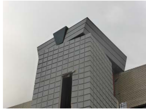
EV棟の被害
