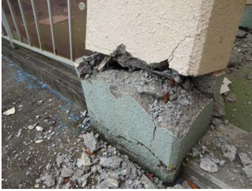
渡り廊下 主筋破断
