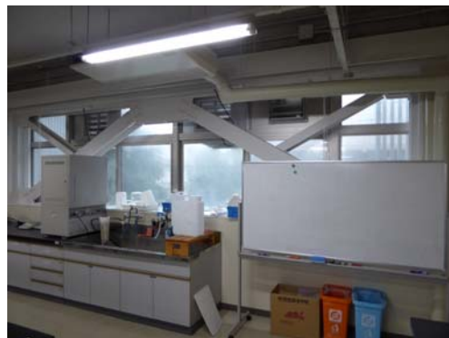
耐震補強ブレース
