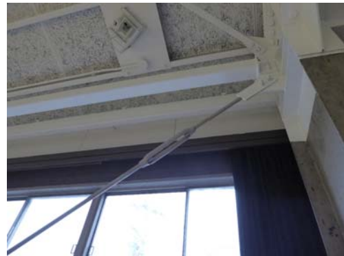
既存の水平ブレース
