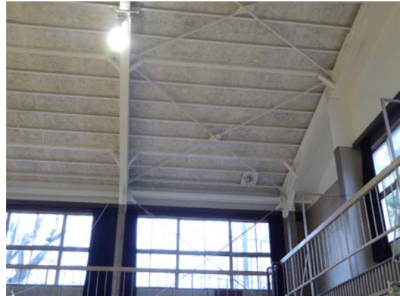
座屈したアングル屋根ブレース
