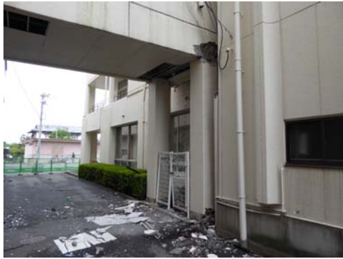
渡り廊下の損傷状況
