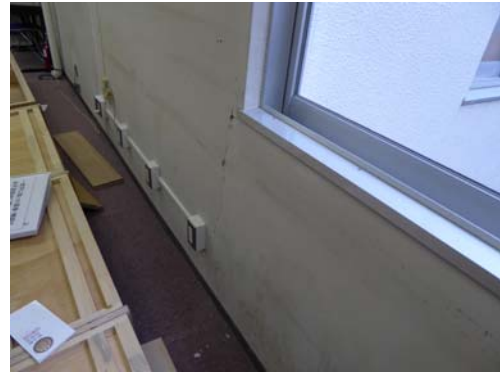
腰壁つき梁のひび割れ
