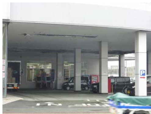
熊本市 天井の脱落被害
