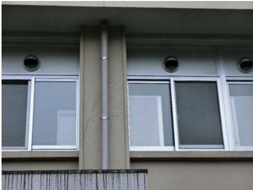
2階柱のせん断ひび割れ
