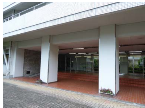
SRFシートによる補強
