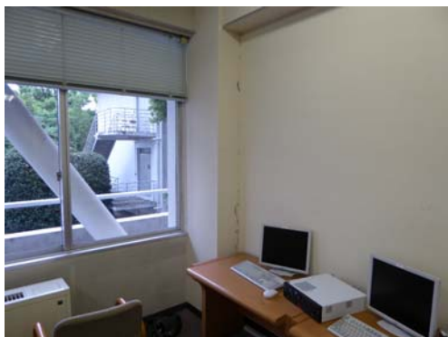
壁収縮目地でのひび割れ
