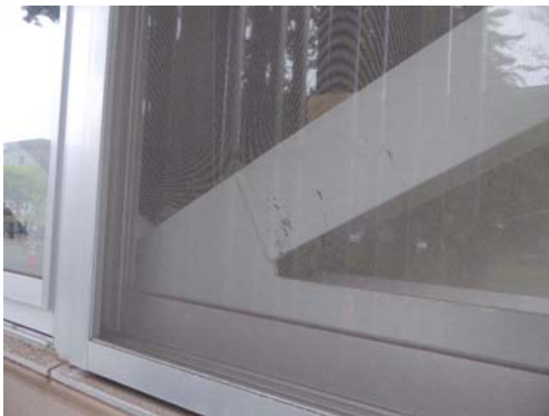
耐震補強ブレースの塗料剥がれ
