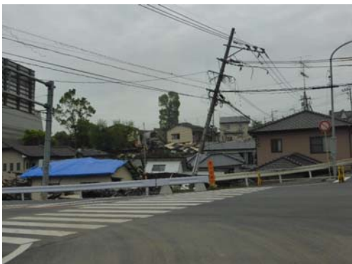
益城町 電柱の傾斜
