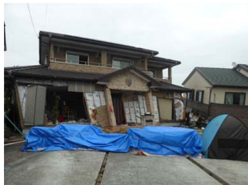
益城町 住宅の傾斜
