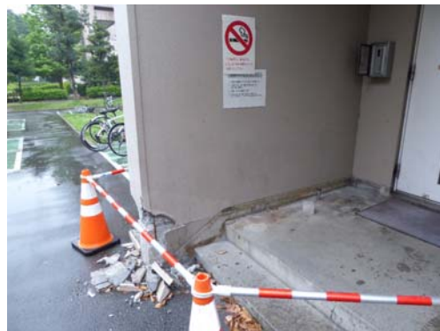
構面外壁の損傷
