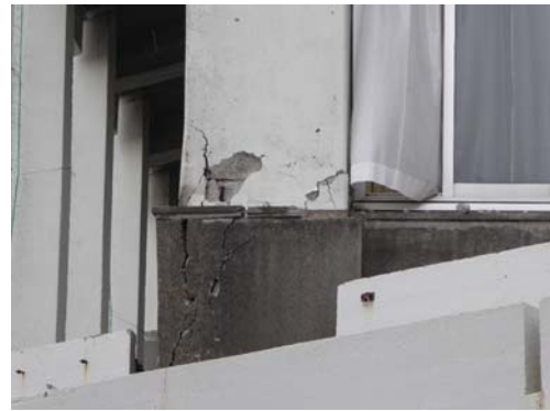
2 階柱脚部分の損傷
