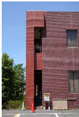
既存部との接合部に損傷は確認されず
