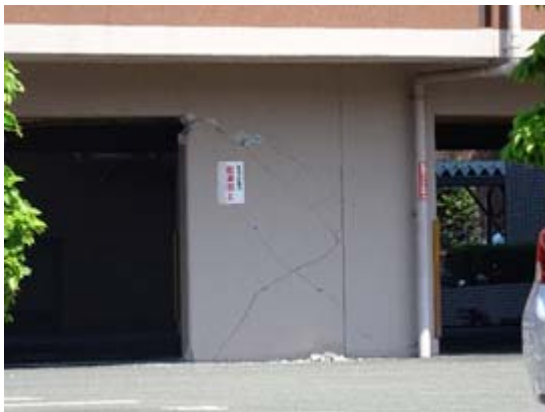
北棟 1 階袖壁付き柱
