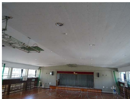
内観（アリーナ部の天井材の変形）
