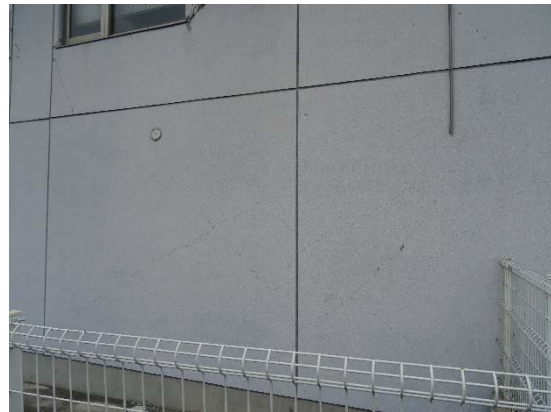
1 階壁せん断ひび割れ
