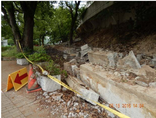
スタンド周辺盛土の崩落
