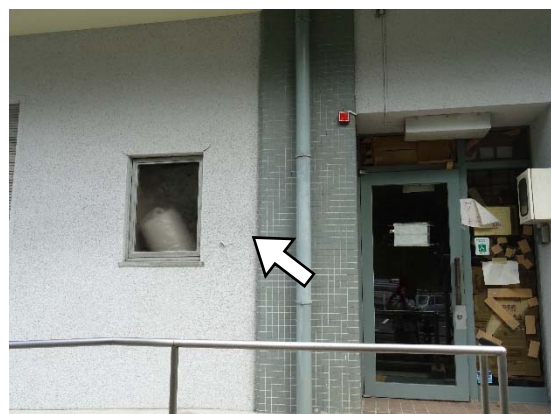
袖壁付き柱のひび割れ
