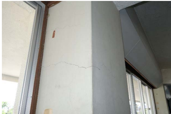
2階柱の曲げひび割れ
