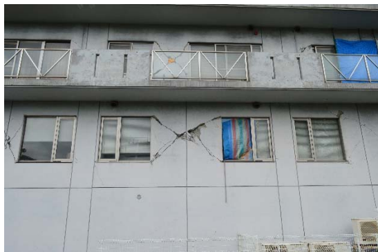
桁行方向の損傷
