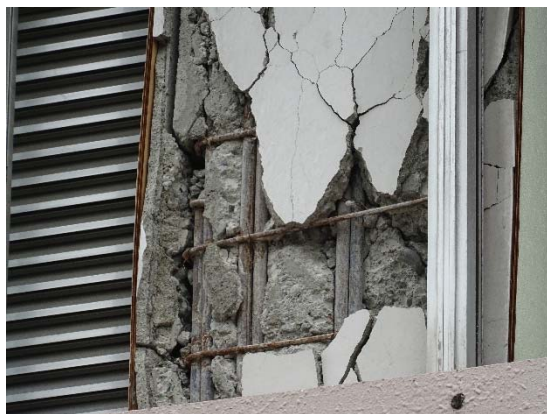
2 階柱のせん断破壊 (主筋丸鋼, 重ね継手が確認できる)
