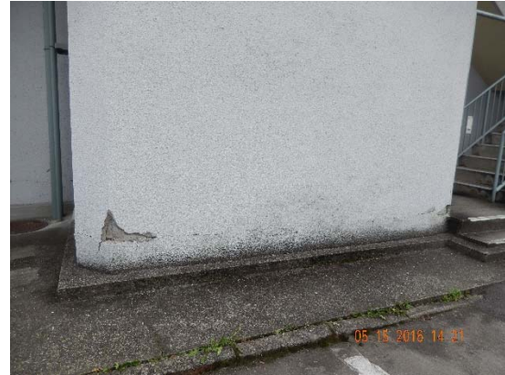
脚部水平ひび割れ，仕上げモルタルの剥離
