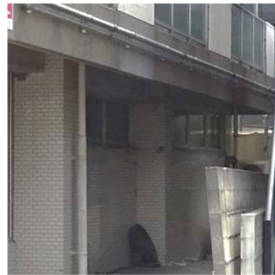
1 階極短柱の損傷
