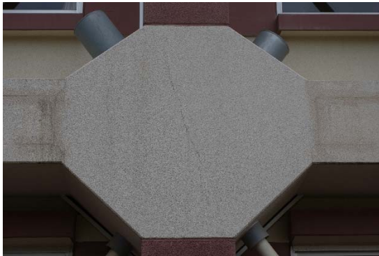
パラレルフレーム柱梁接合部のひび割れ
