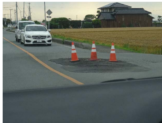
マンホールの浮き (熊本市東区)
