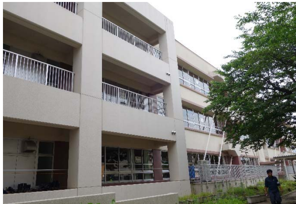
PCaPC外フレームによる補強
