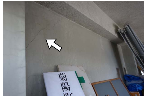
2階耐震壁のせん断ひび割れ
