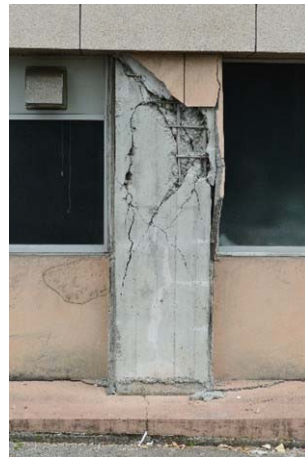
1 階柱せん断破壊
