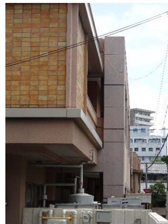
補強フレーム側
