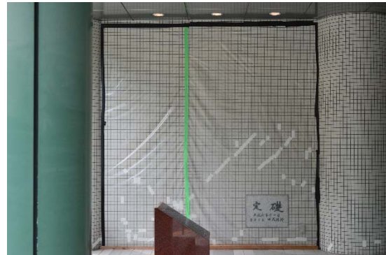
エントランス周辺耐震壁のせん断ひび割れ
