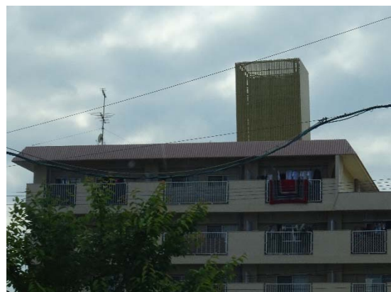
屋上給水タンクの傾き（熊本市東区）
