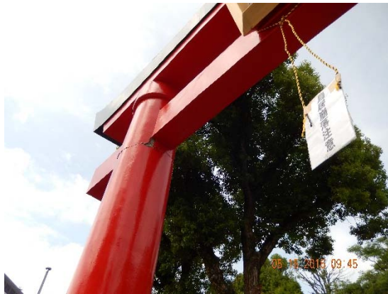
RC 造鳥居の柱頭（熊本市中央区）
