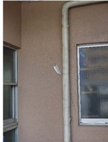
1階雑壁のせん断ひび割れ
