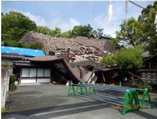
崩落した神社 (熊本市中心区)
