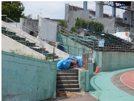
スタンドの崩落
