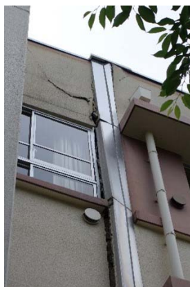
Exp.J部の損傷
