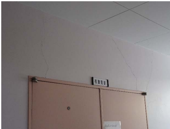
雑壁のひび割れ
