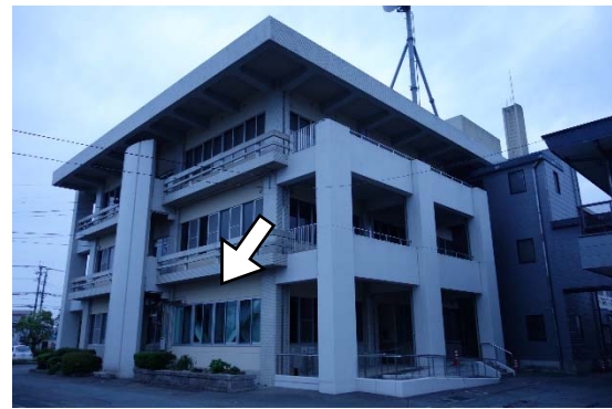
鉄骨ブレースによる補強
