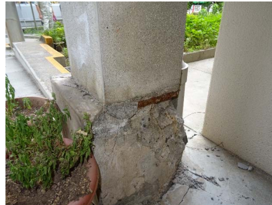
渡り廊下柱脚部
