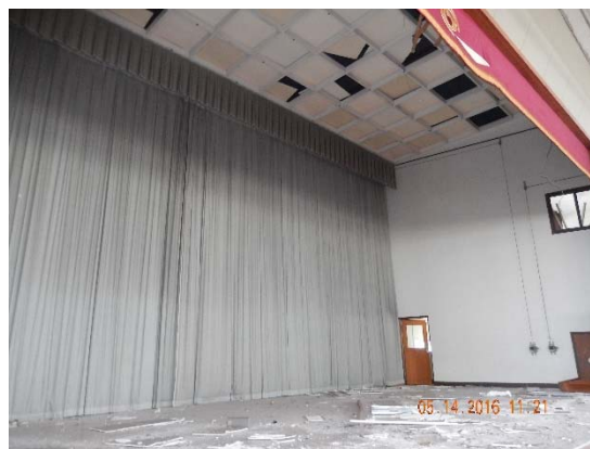
舞台上部ぶどう棚からの天井材落下
