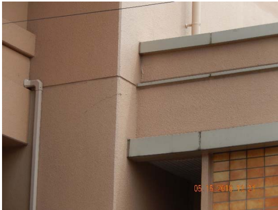
柱梁接合部のひび割れ
