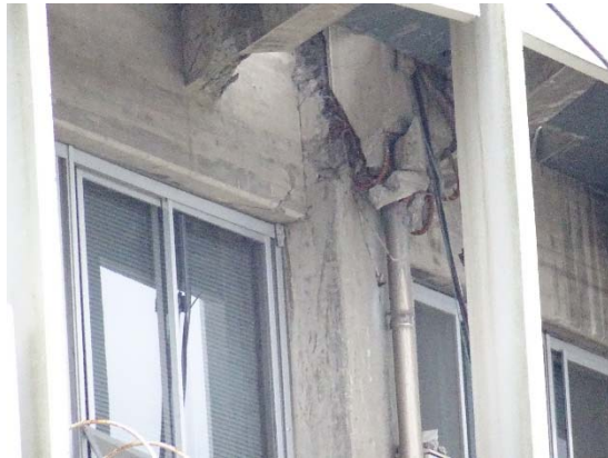
3階柱－4階梁接合部
