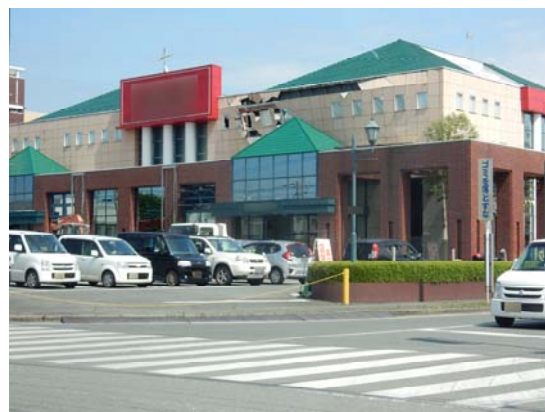
外装パネル, ガラスの脱落 (熊本市東区)
