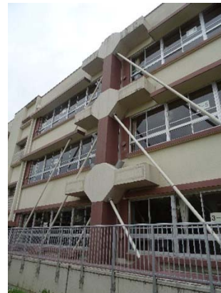
平行フレーム工法による補強
