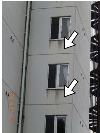
窓開口間の外壁の損傷
