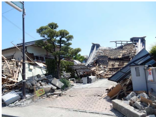
寺院の倒壊 (上益城郡益城町)
