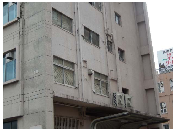
大通り反対側の方立壁せん断破壊
