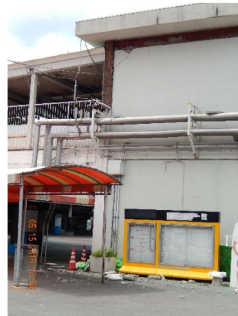
S造仕上げモルタル剥落，外壁のひび割れ
