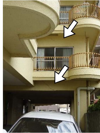
2, 3 階梁のひび割れ
