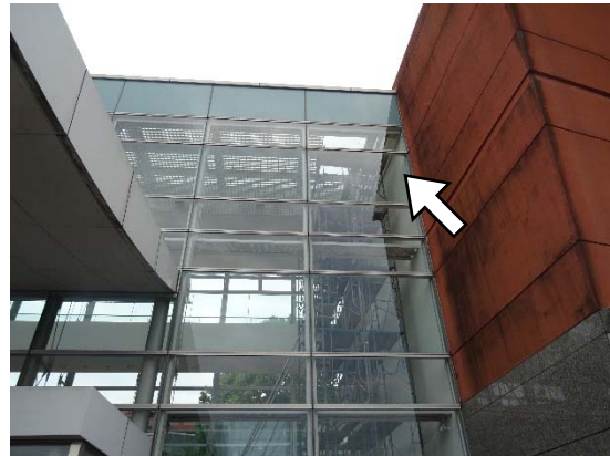
天井材の落下
