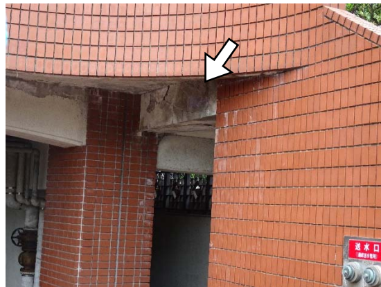
入り口への通路下の小梁のせん断破壊
