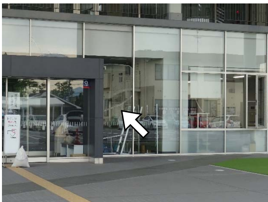
エントランス横のガラス破損
