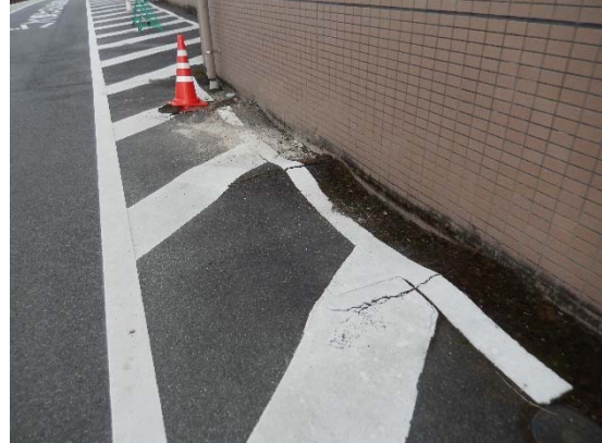
周辺地盤沈下
