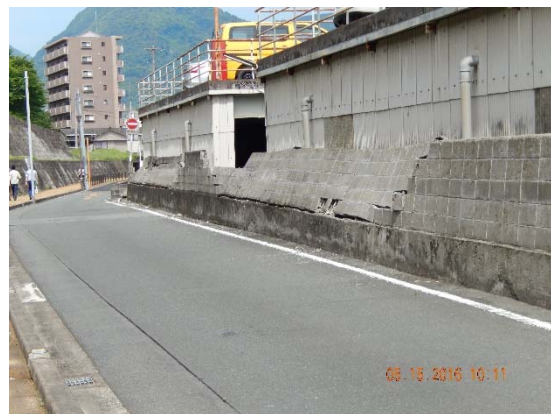
ブロック塀の倒壊（熊本市中央区）
