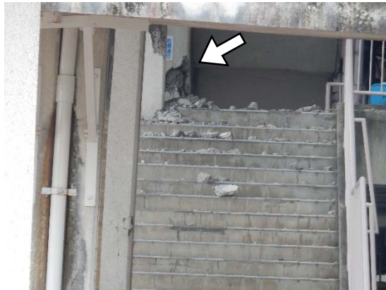
柱の曲げ圧壊
