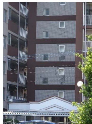
階段室雑壁の損傷
