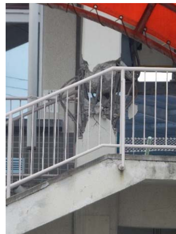
柱のせん断破壊
