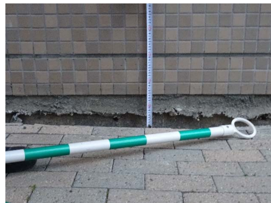
約 30cm の地盤沈下
