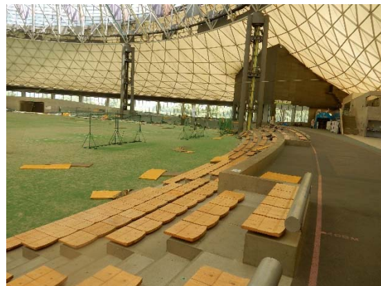
落下し散乱する天井材
