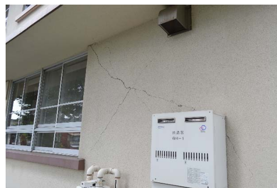
補強と直交方向の外壁せん断ひび割れ
