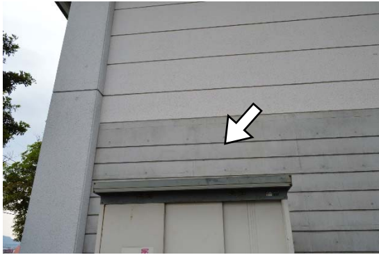
梁間方向耐震壁のひび割れ
