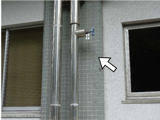
柱のせん断ひび割れ
