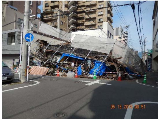
道路側に倒壊した木造住宅 (熊本市中央区)
