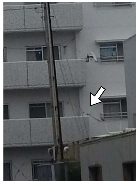
柱を貫通しているとみられるせん断ひび割れ
