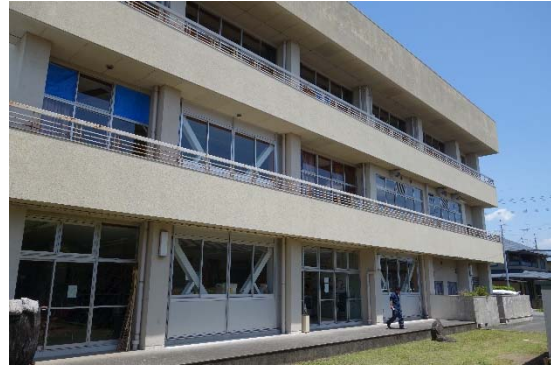
鉄骨ブレース補強した構面
