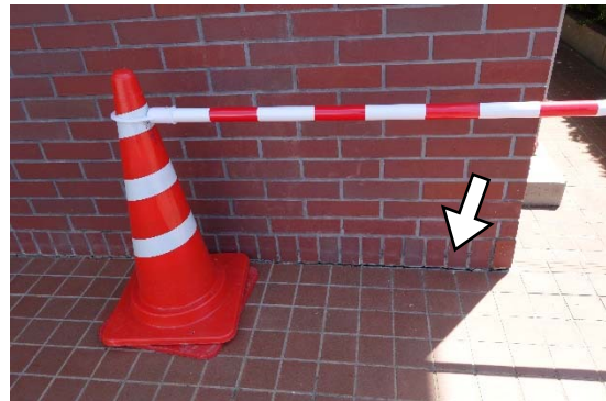
建物西端構面の壁脚部に開き (約 1.0cm)
