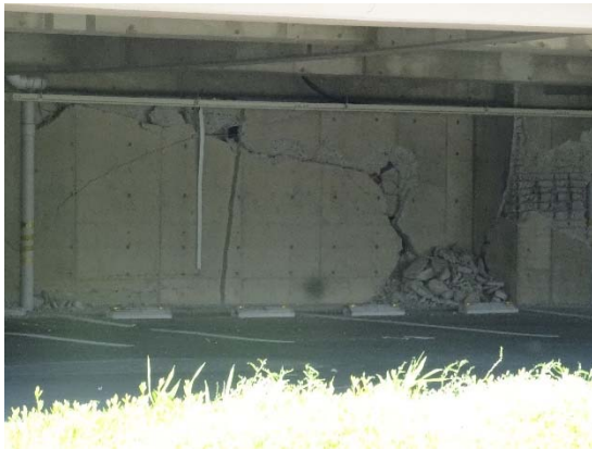
南棟 1 階桁行方向の連スパン壁
