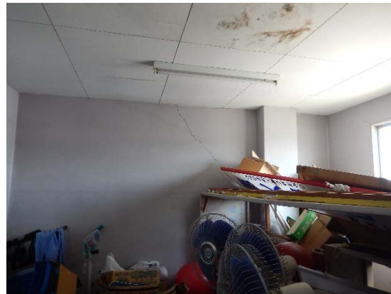
3階桁行方向耐震壁のひび割れ
