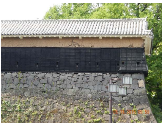
土壁の剥落 (熊本市中心区)
