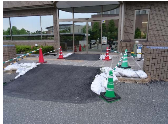
地盤沈下の被害
