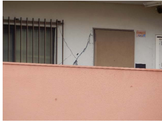
方立壁せん断破壊
