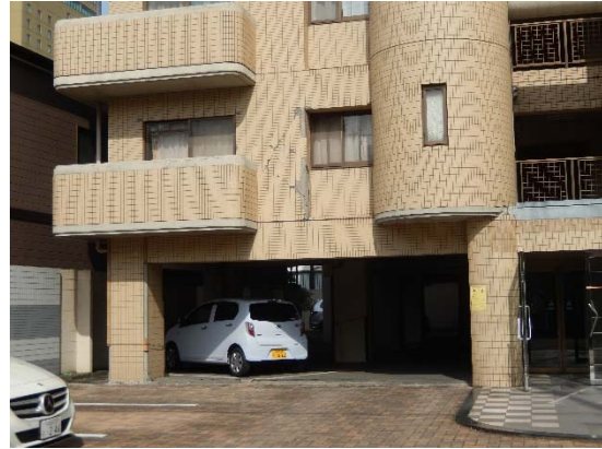
2階 方立壁 (熊本市中央区)
