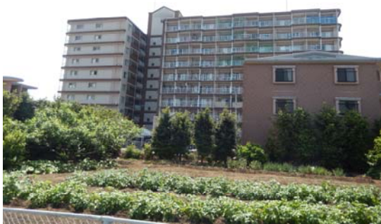
外観 (左：南棟，右：北棟)
