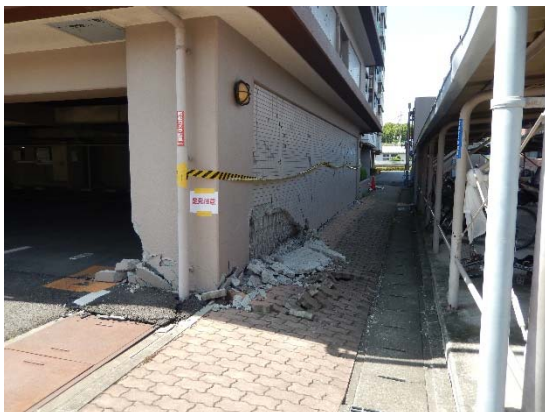
南棟 1 階妻壁の損傷
