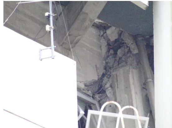
4階柱－5階梁接合部
