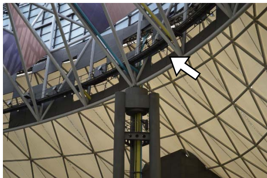
天井材の脱落
