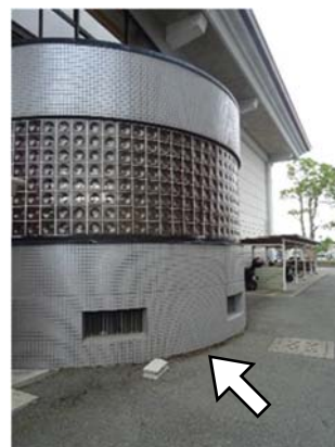
周辺地盤沈下
