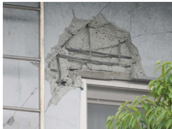
3 階梁間方向垂れ壁の圧壊
