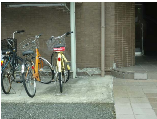
耐震壁? 脚部の損傷 (熊本市東区)
