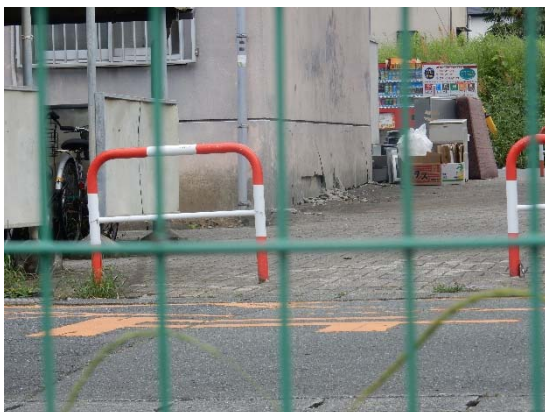
1 階脚部の損傷
