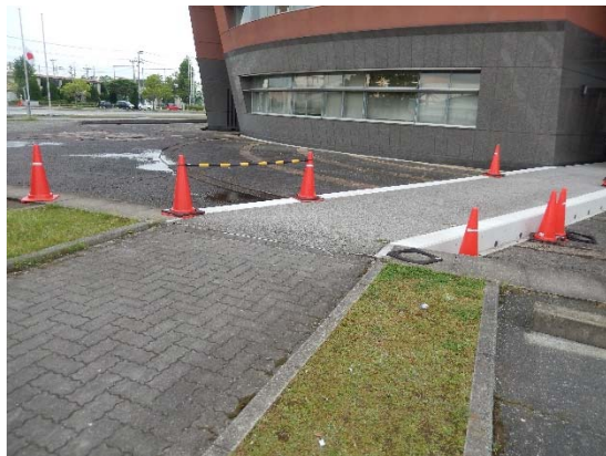
周辺地盤の変状
