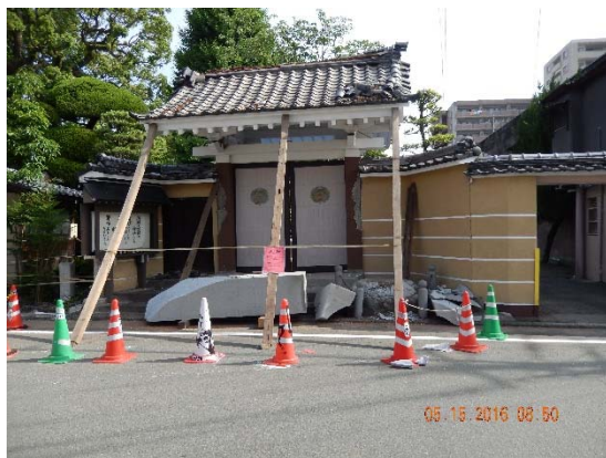
山門の損傷（熊本市中央区）
