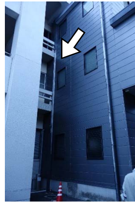
別棟との接続箇所で Exp.J カバーの脱落
