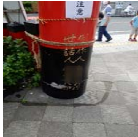
RC 造鳥居の柱脚（熊本市中央区）
