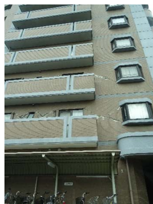
方立壁 (熊本市東区)
