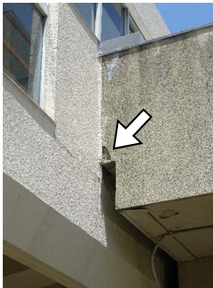
連絡通路端部の損傷
