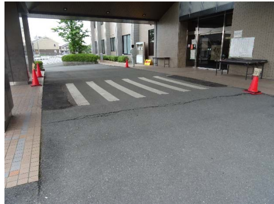
正面玄関の地盤変状
