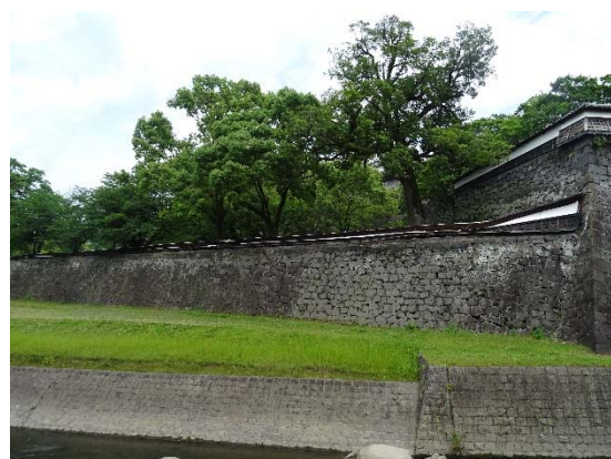
長塀の倒壊 (熊本市中心区)
