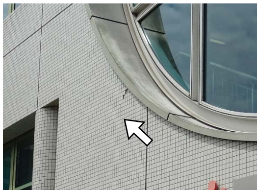
雑壁のひび割れ
