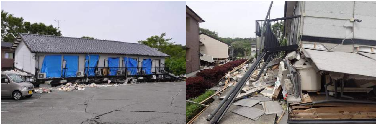
木造、2階建て（外階段・2階廊下・ベランダは、軽量鉄骨） 応急危険度判定：危険、1階層崩壊、建物周辺に地盤破壊有り
