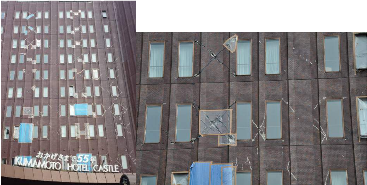
鉄骨鉄筋コンクリート造、11階建て、1975年竣工 外壁に多数のせん断ひび割れを確認
