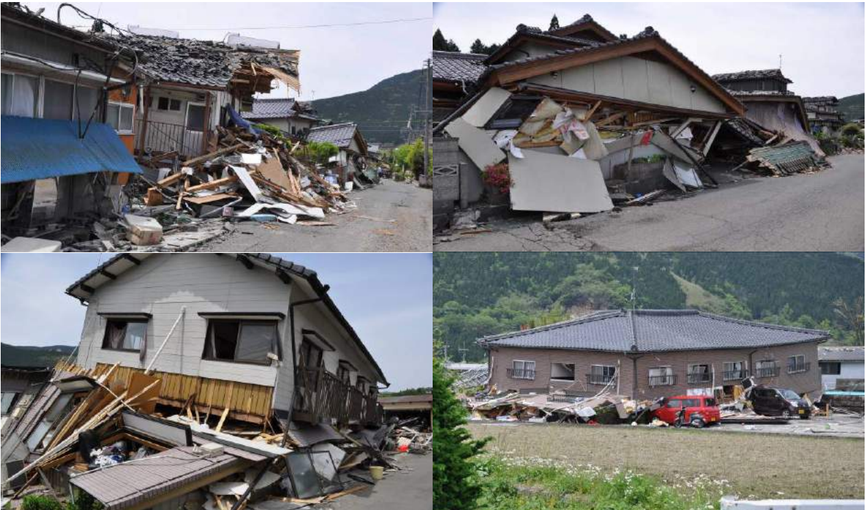
木造、平屋・2階建て 応急危険度判定：危険、いずれも1階層崩壊しており、建物の支持地盤に亀裂や変形が見られた
