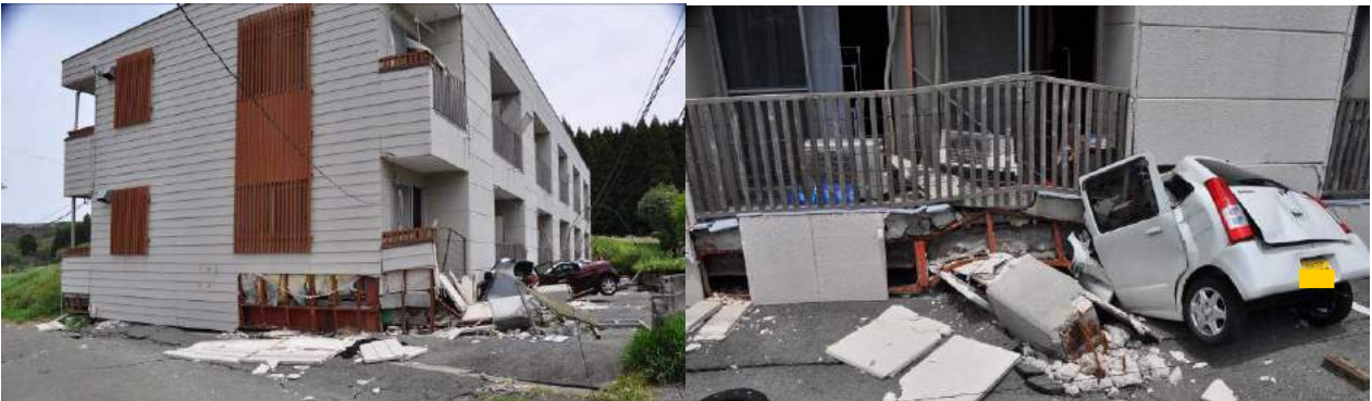
鉄骨造、3階建て 応急危険度判定：危険、1階（ピロティ形式の駐車場）層崩壊
