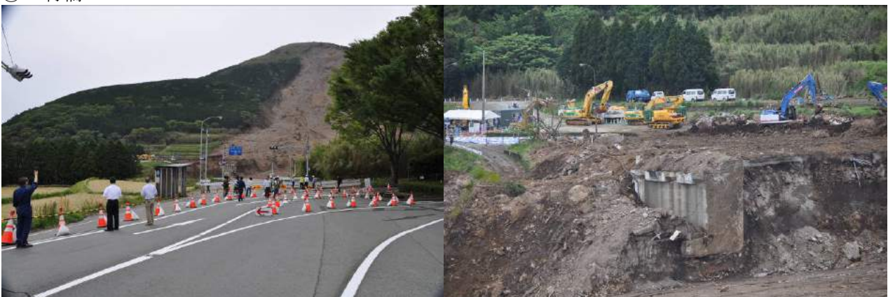
大規模土砂崩れにより崩落した橋跡
