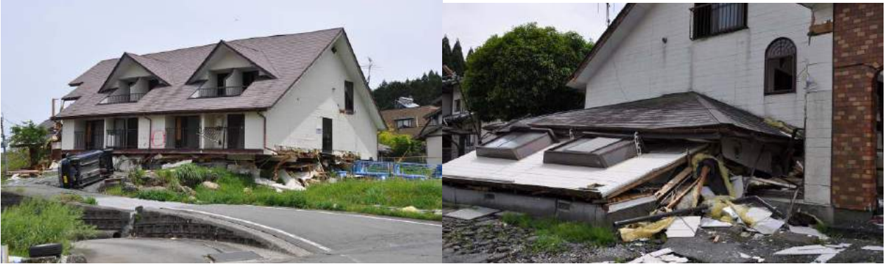
木造、3階建て 応急危険度判定：危険、1階層崩壊
