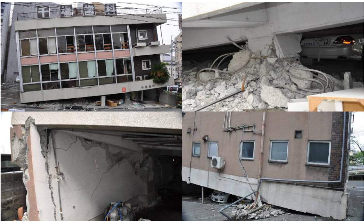
鉄筋コンクリート造、3階建て 応急危険度判定：危険、1階の駐車場ピロティ部分の柱が圧壊し層崩壊に至る 1階は階段室側に壁が偏在しており、反対側の柱が圧壊したため建物は傾斜状態
