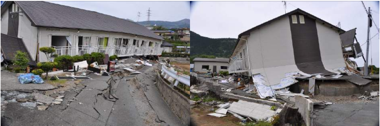
木造、2階建て（外階段・2階廊下・ベランダは、軽量鉄骨） 応急危険度判定：危険、建物裏側の地盤が破壊、建物は地盤変形に追従できず1階層崩壊
