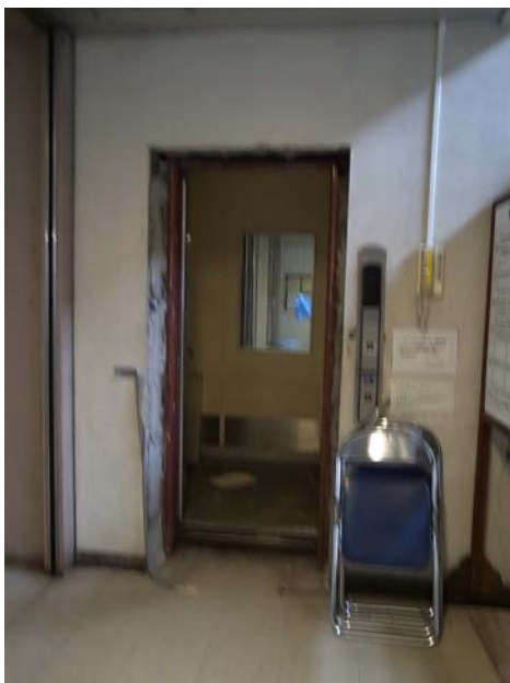
医学部臨床研究棟 入口湿式貼り石材脱落（整理清掃後）
