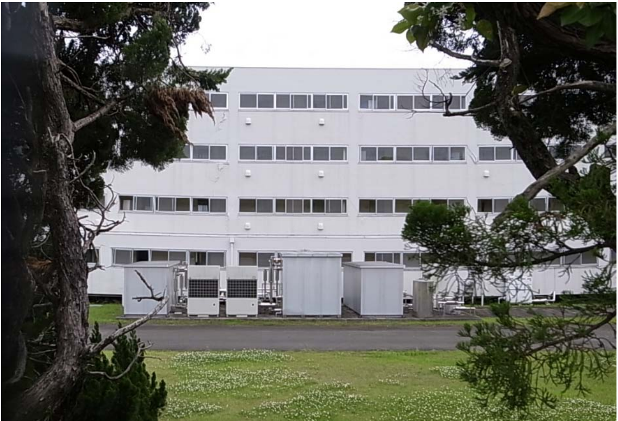
たるみ中央部 左右の柱の斜め亀裂の方向は逆。周辺地盤に陥没などは見られない。
