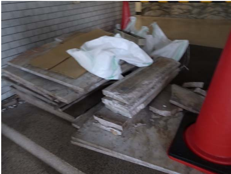
医学部臨床研究棟 入口湿式貼り石材脱落（整理清掃後）
