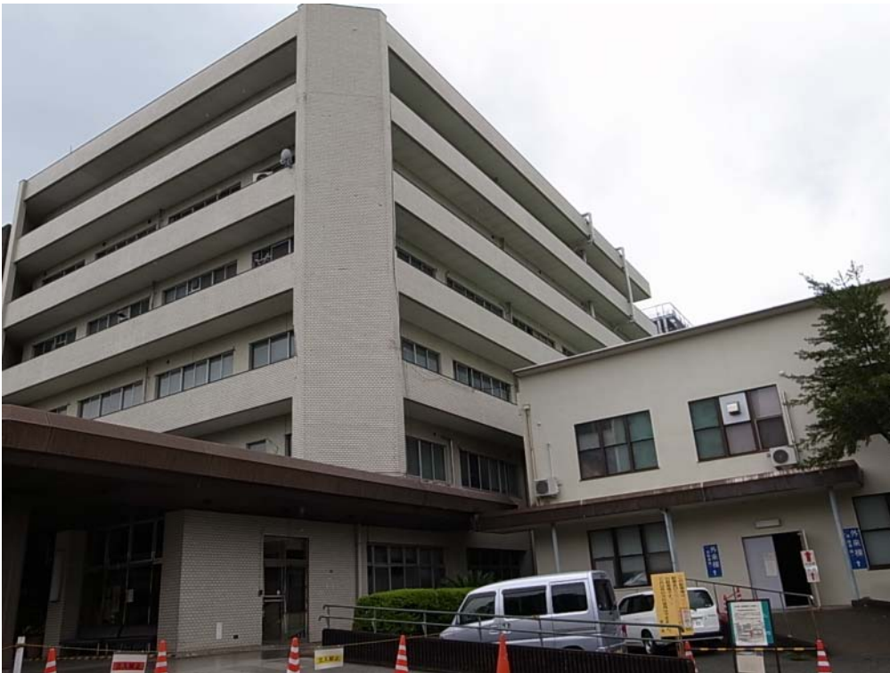
外来臨床研究棟：2階雑壁亀裂など
