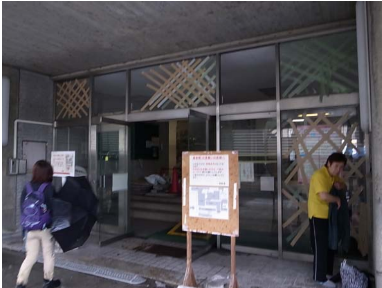
医学部臨床研究棟 入口ガラスひび割れ／応急補修
