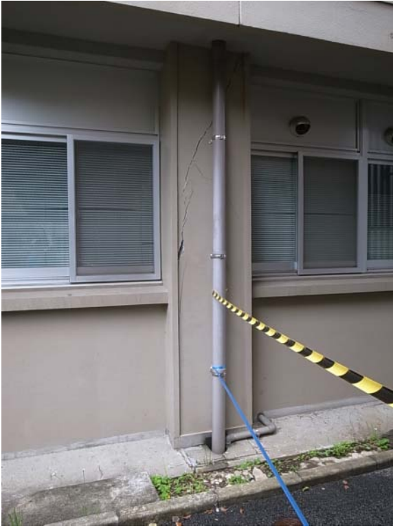
1 階柱の亀裂
