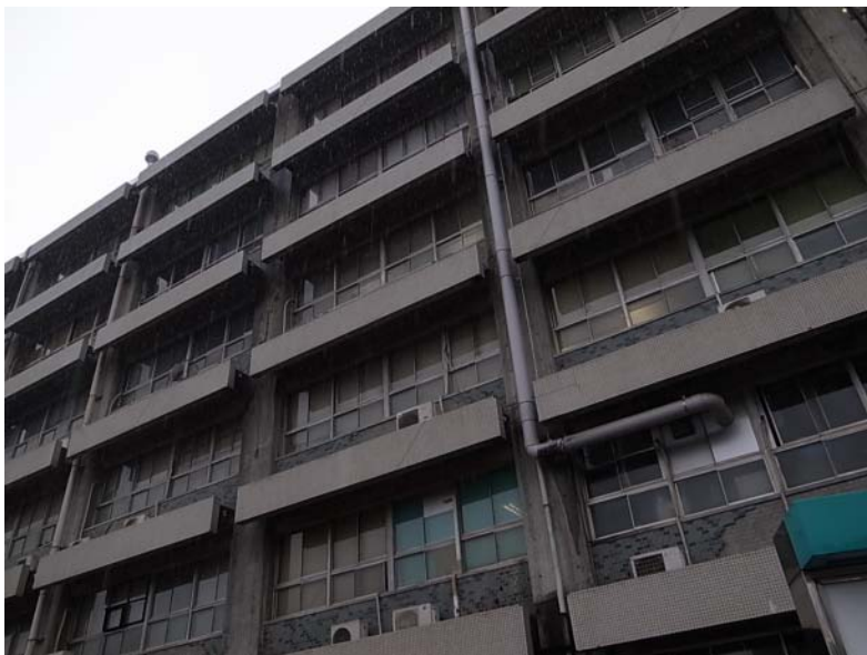
医学部臨床研究棟 外壁タイル剥離（？）も庇で受け止め
