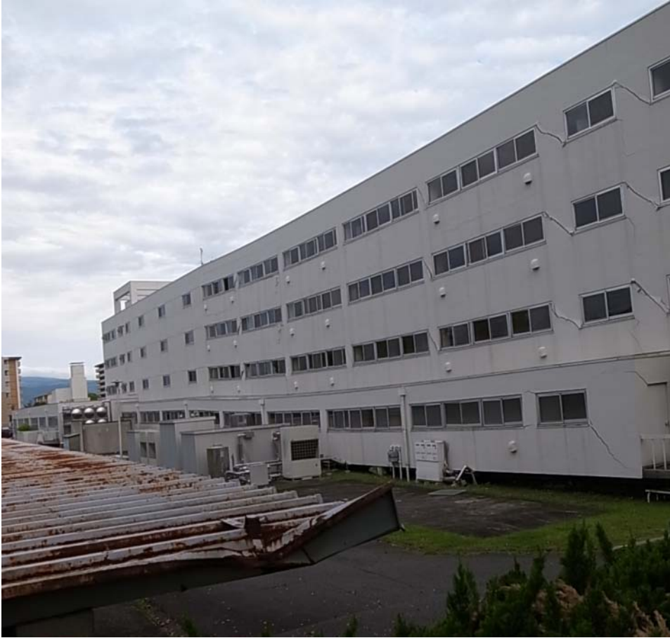
背面側から 柱に1方向の斜め亀裂 全体的にたるみが生じていることが分かる。
