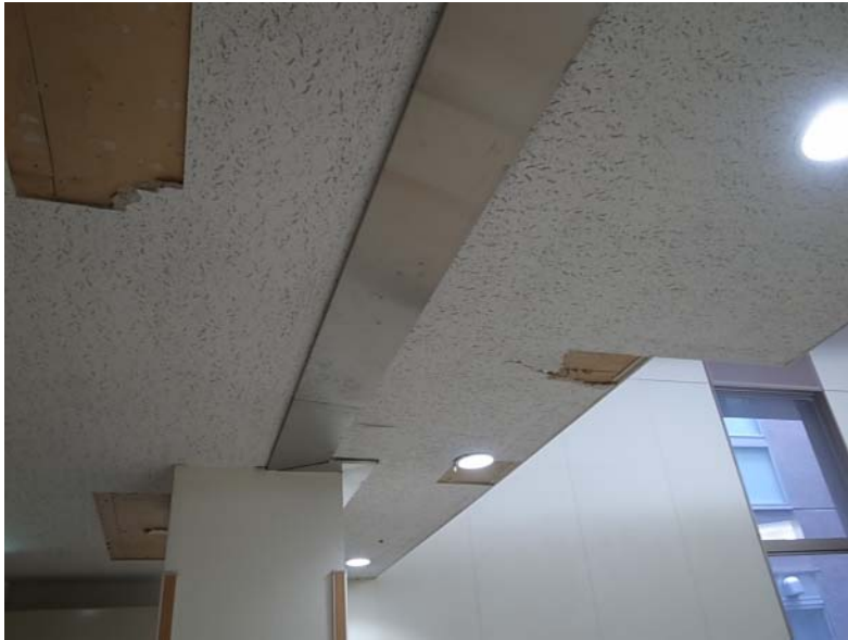
新外来診療棟内：岩綿吸音板捨張り工法の表面板剥離
