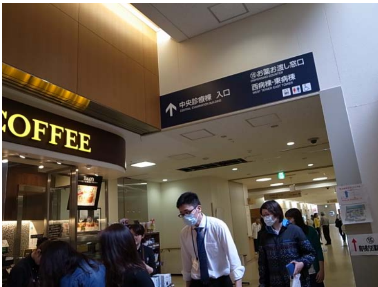
中央診療棟エキスパンションジョイント近傍の天井落下
