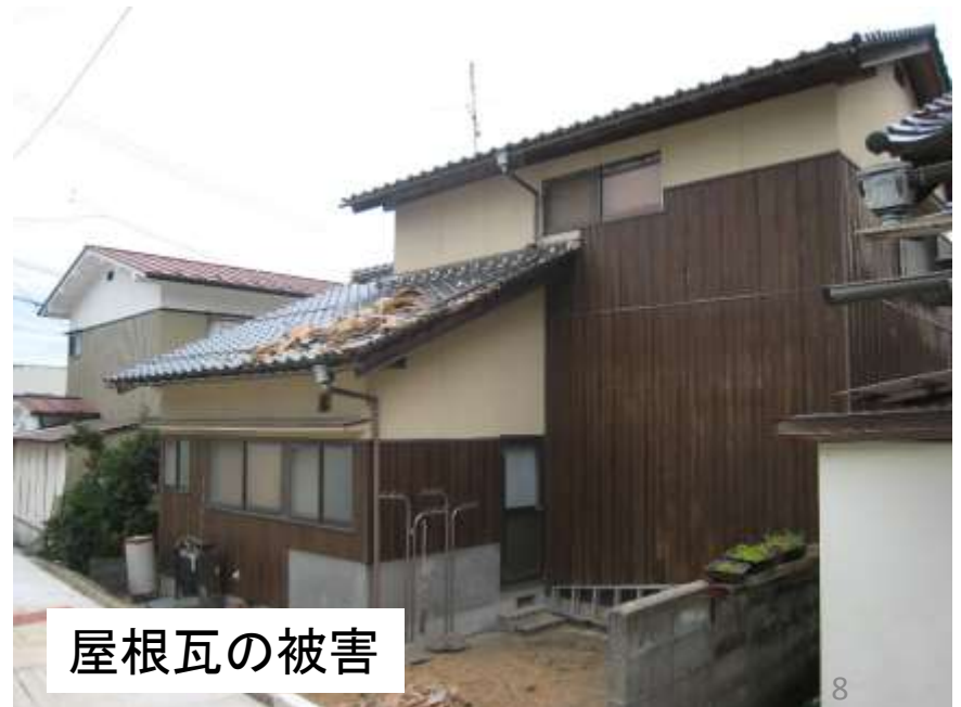
屋根瓦の被害
