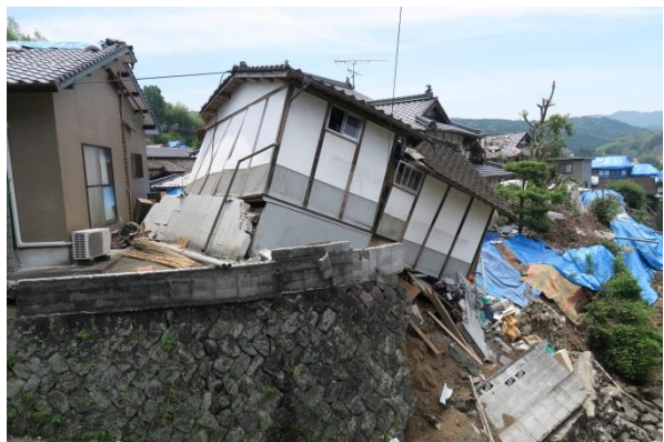
写真 2.10 擁壁の崩壊による被害例
