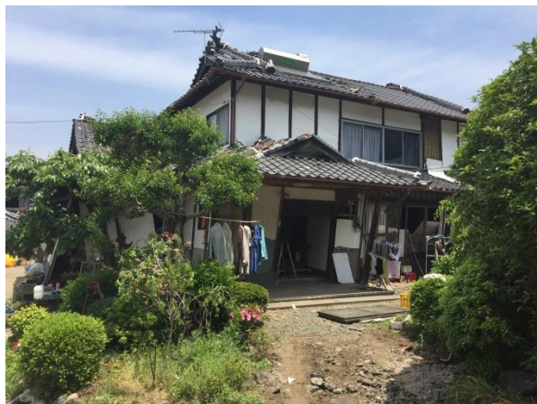
写真 2.16 専用住宅の被害例 (大破)
