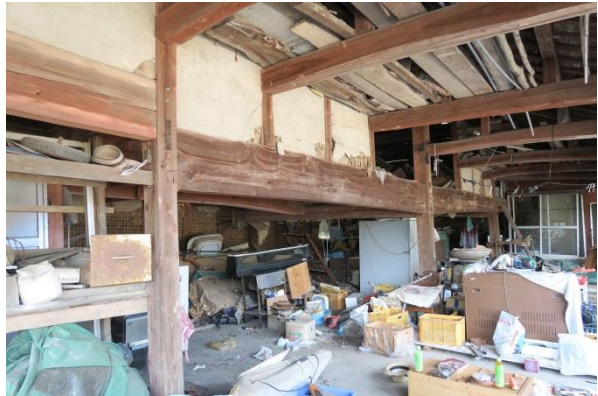
写真 2.4 倉庫・納屋の例 2
