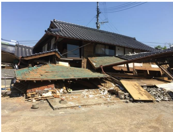
写真 2.15 専用住宅の被害例 (倒壊)
