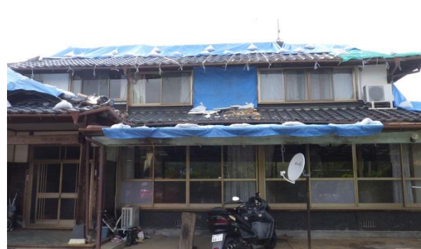
写真 2.6 専用住宅の被害例 (中破)
