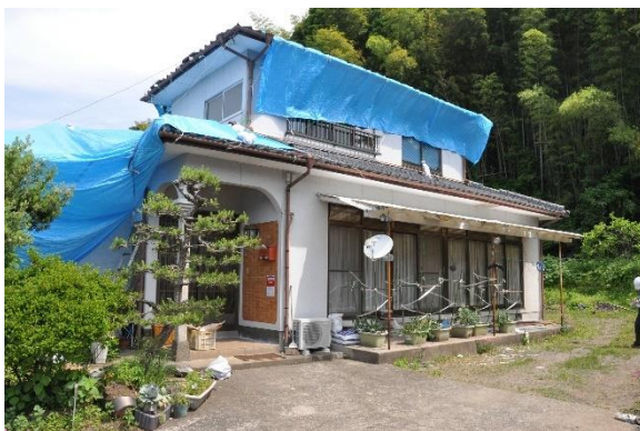
写真 1.1 屋根の損傷 (小谷)
