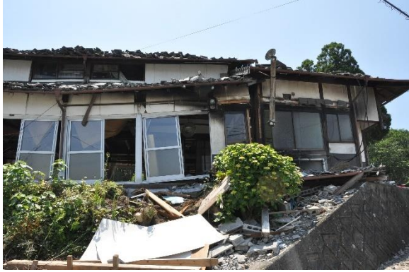
写真 1.3 地盤の崩壊と建物の損傷 (布田)
