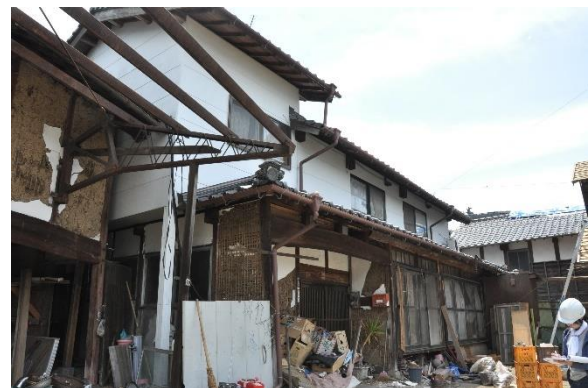
写真 1.2 外壁の損傷 (小谷)
