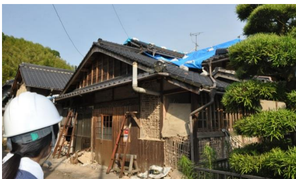
写真 2.5 専用住宅の被害例 (大破)
