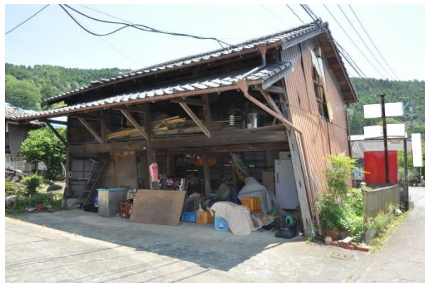
写真 2.13 倉庫・納屋の例 1
