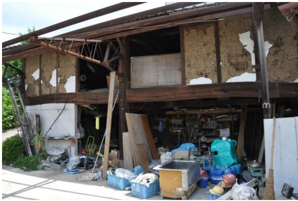
写真 2.7 倉庫・納屋の被害例（大破）
