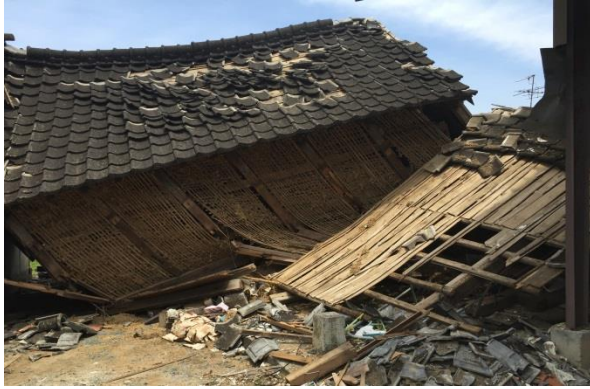
写真 2.17 倉庫・納屋の被害例（倒壊）
