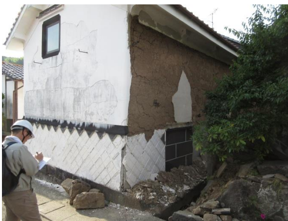
写真 2.9 土蔵の柱脚の移動（約 20cm）
