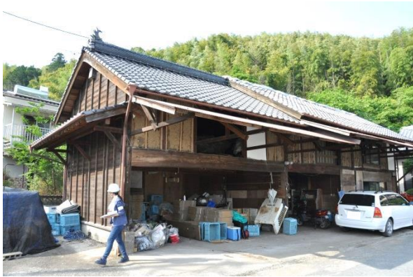
写真 2.3 倉庫・納屋の例 1
