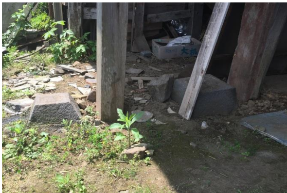
写真 2.19 倉庫の柱脚の移動（約 30cm）
