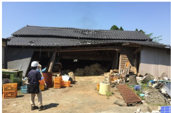
写真 2.14 倉庫・納屋の例 2
