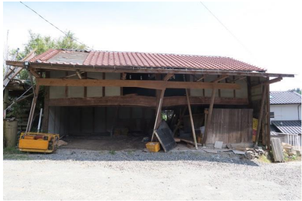
写真 2.8 倉庫・納屋の被害例（大破）
