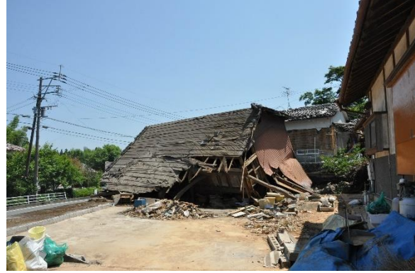
写真 1.4 崩壊した倉庫 (布田)
