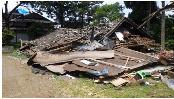
写真 2.18 倉庫・納屋の被害例（倒壊）
