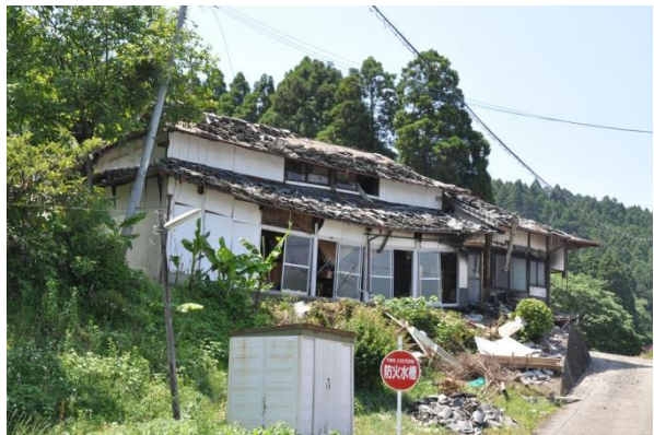
写真 2.20 擁壁の崩壊による被害例
