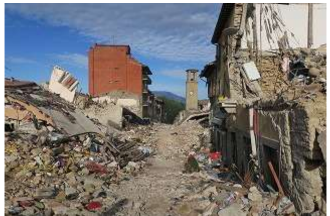
写真 6-4 組積造建物の被害
