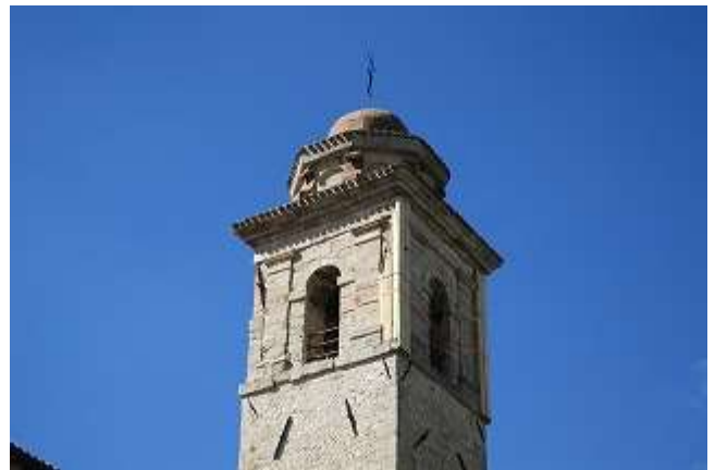
写真 5-10 修道院の鐘楼の応急処置
