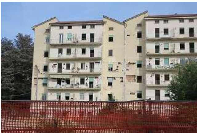
写真 6-31 手つかずの RC 造建物
