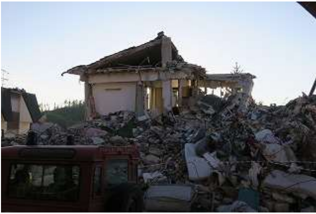
写真 5-17 RC 造建物の被害
