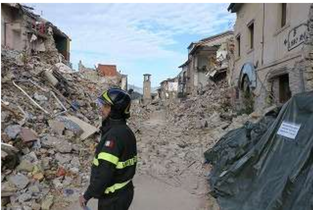
写真 6-3 組積造建物の被害
