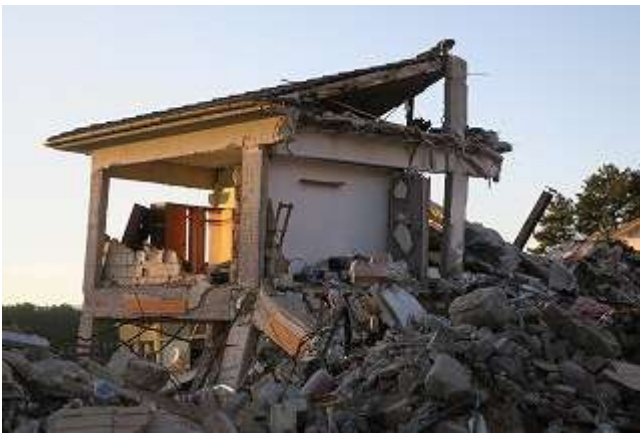
写真 5-29 RC 造建物の被害
