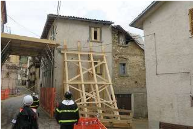
写真 7-17 応急復旧の状況
