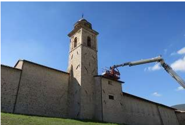
写真 5-9 修道院の鐘楼の応急処置
