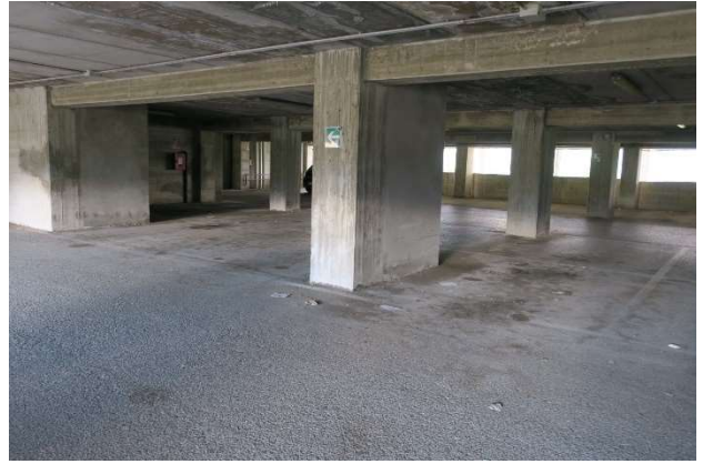
写真 7-58 1階駐車場（被害なし）
