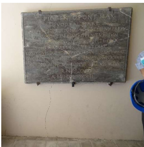
写真 8-9 回廊上階修道院の壁のひび割れ (外部)
