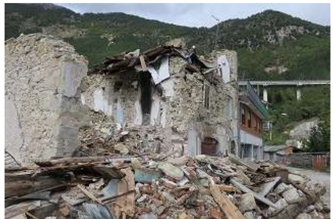
写真 7-32 組積造の被害
