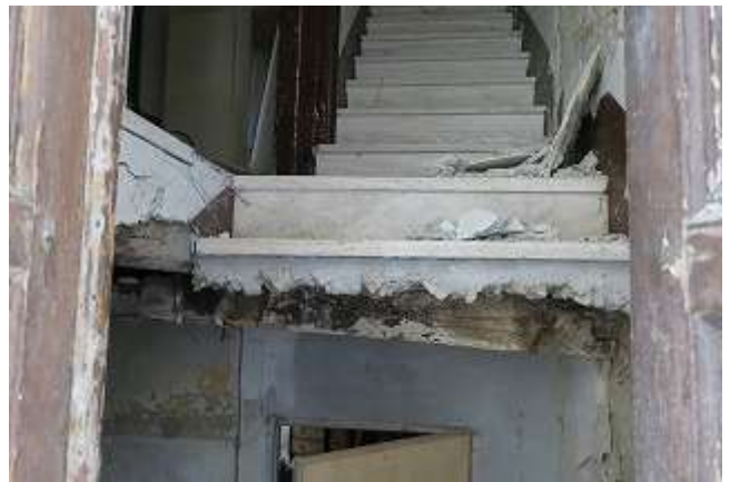
写真 7-10 木製階段の上にコンクリート打設
