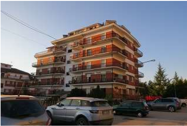
写真 5-27 RC 造建物の被害
