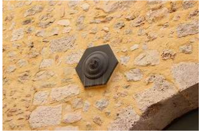
写真 6-42 外壁の面外方向の補強
