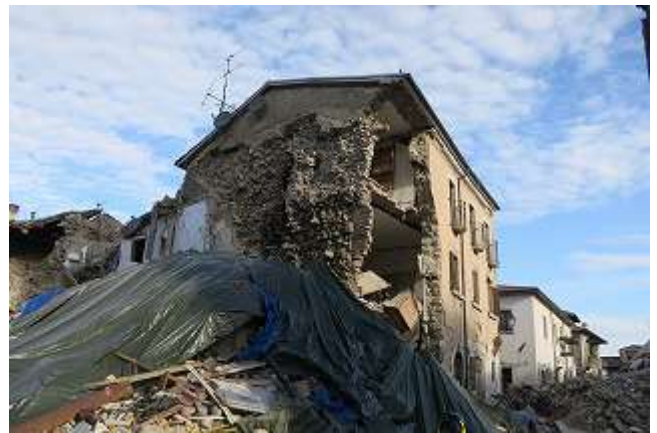
写真 6-10 組積造建物の被害
