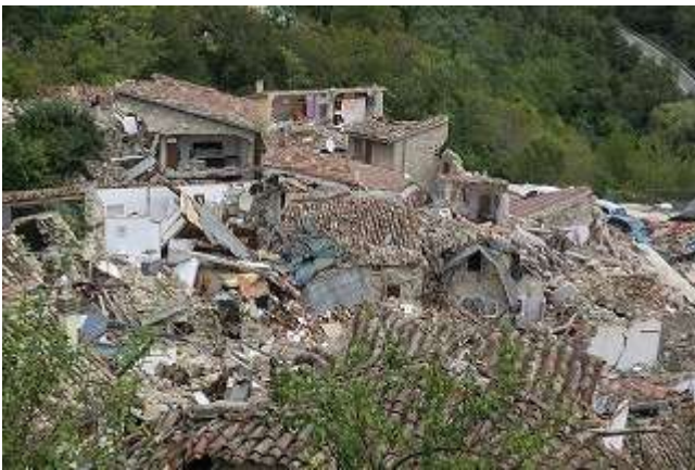
写真 7-29 組積造の被害
