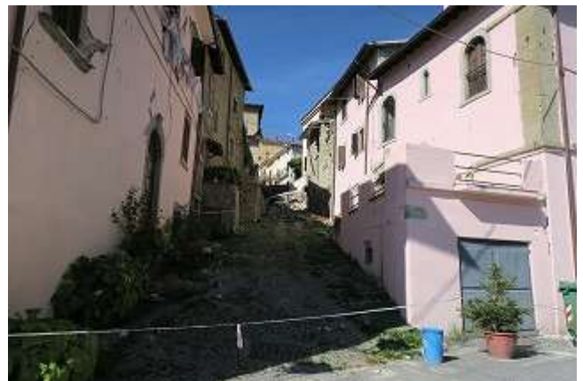
写真 6-24 組積造建物の被害
