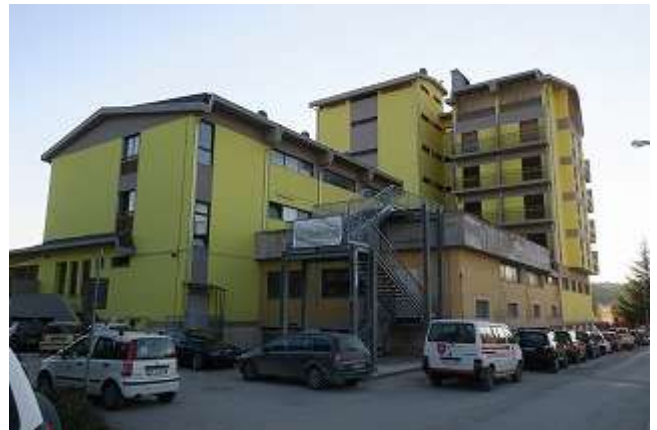
写真 5-14 RC 造建物の被害
