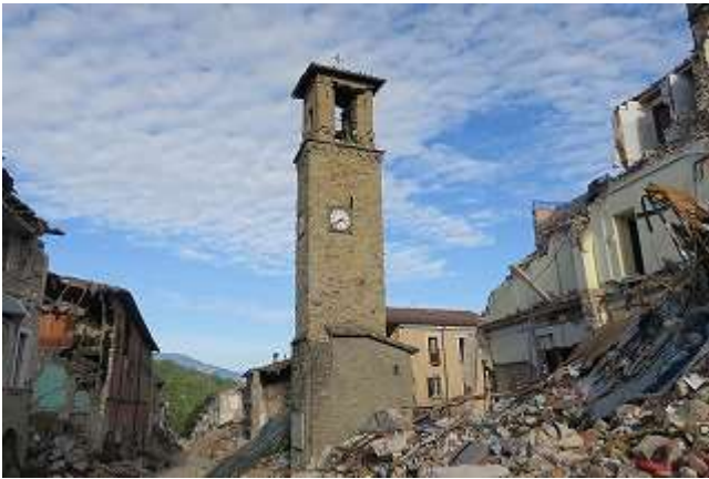
写真 6-7 市民の塔の被害
