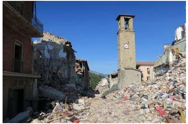
写真 6-14 組積造建物の被害
