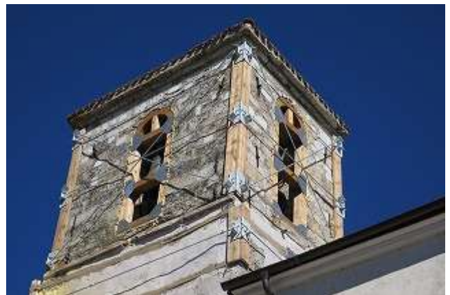
写真 5-2 教会の鐘楼の応急処置
