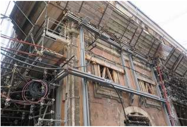
写真 6-33 補強工事中の RC 造建物
