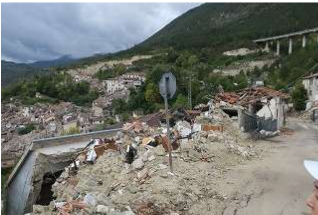
写真 7-21 RC 造屋根の落下
