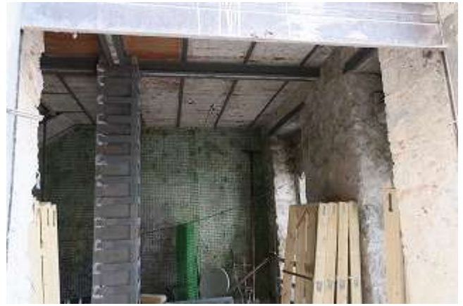
写真 6-34 補強工事中の RC 造建物
