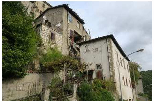
写真 7-4 組積造の被害
