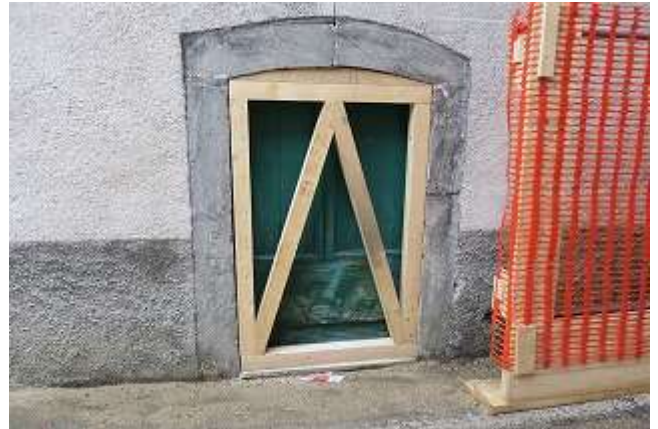
写真 7-18 応急復旧の状況
