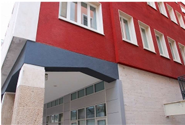
写真 6-43 せん断ひびわれが発生した梁の補修
