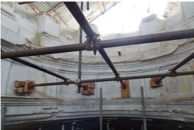
写真 6-45 サンタゴスティーの補強足場（頂部）
