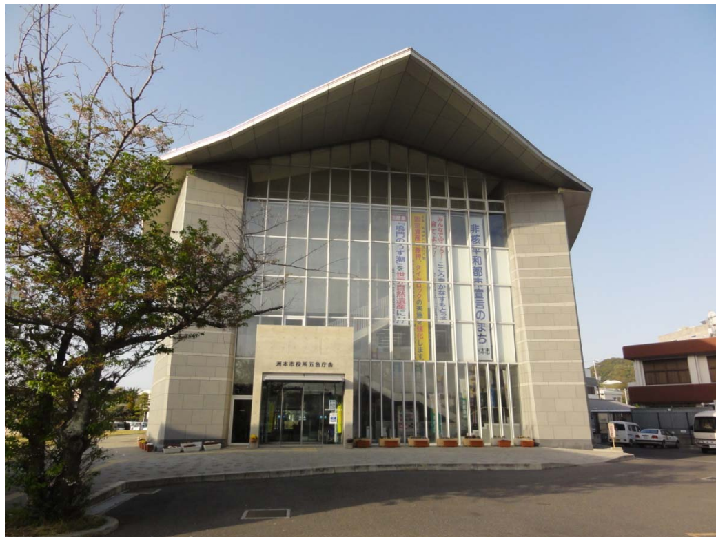
洲本市役所五色庁舎(地震計はみつからず)
