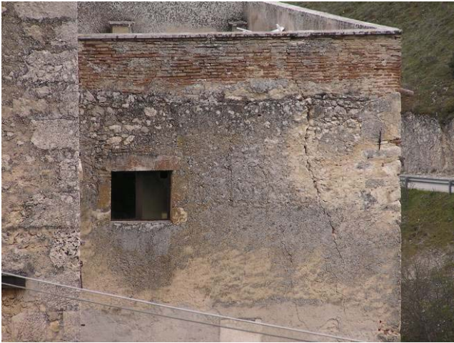
写真13 外壁のせん断ひび割れ
