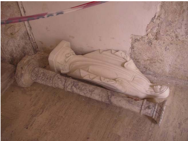
写真17 飾り柱, マリア像の落下
