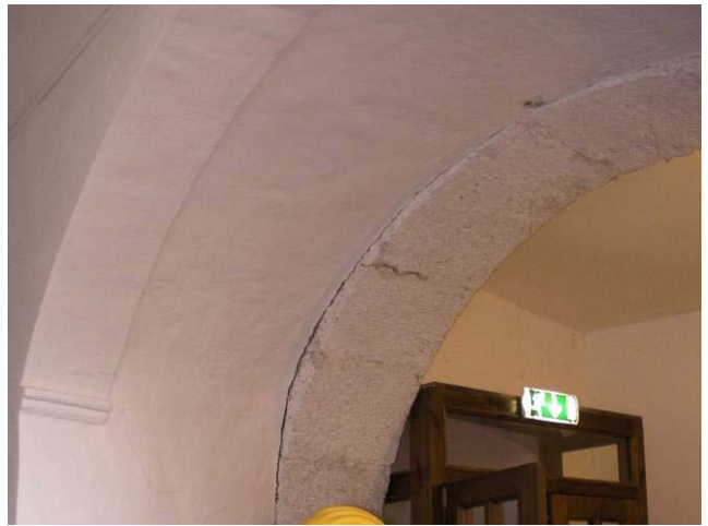
写真16 バルコニーのひび割れ
