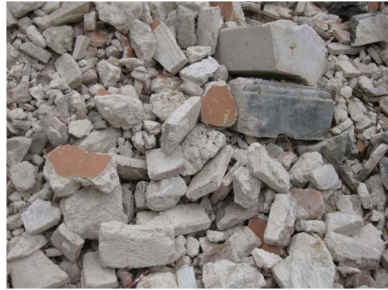
写真31 崩壊した組積材と仕上の残骸
