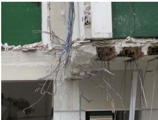
写真 36 2階梁とスラブ
