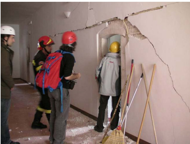
写真11 壁のせん断ひび割れ
