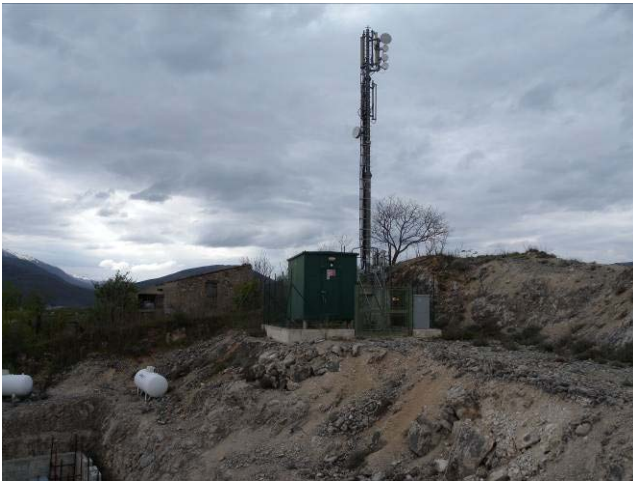
写真29 強震計 FA030 の設置状況
