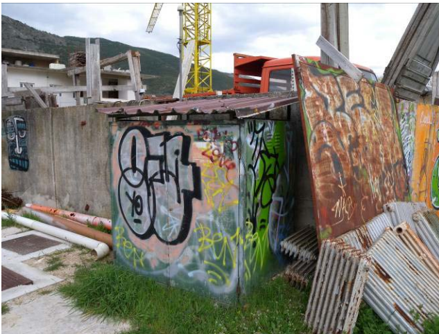
写真31 強震計 S05 の設置状況
