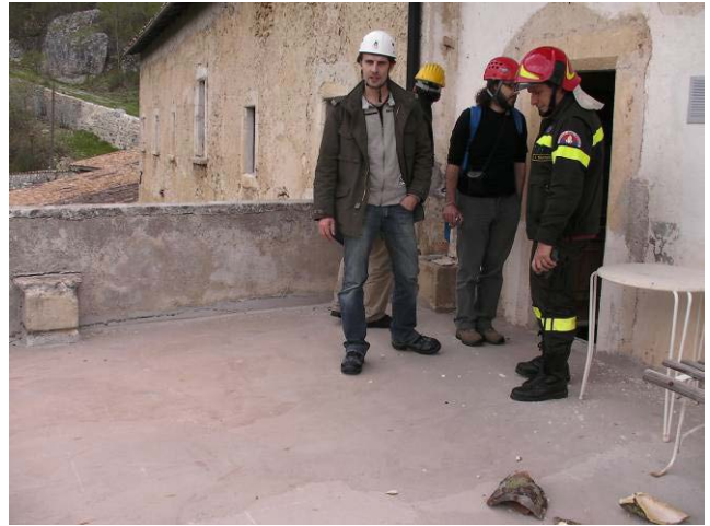
写真14 バルコニーのひび割れ
