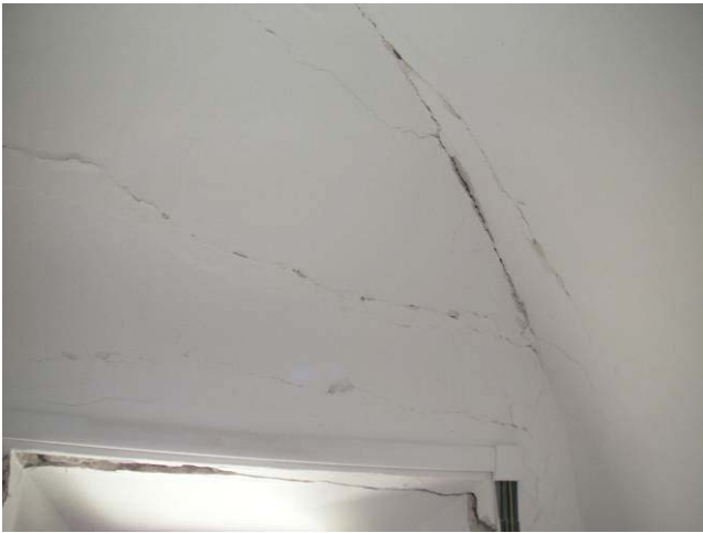
写真15 外壁のせん断ひび割れ
