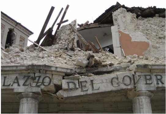
写真28 組積造 PLAZZO DEL GOVERNO の崩壊
