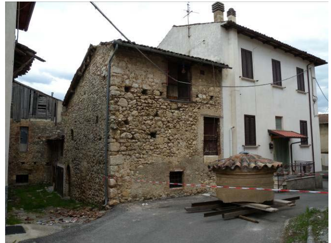
写真 28 自然石の組積壁が一部崩落したため、煙突を屋根から人為的に降ろした模様
