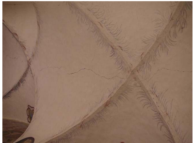
写真18 回廊ヴォールトのひび割れ
