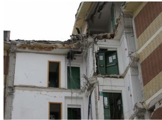
写真 35 増築部分の梁鉄筋が露出
