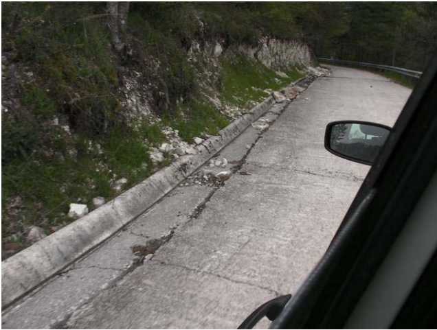
写真7 道路の亀裂と落石の状況
