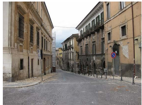
写真 15 南西角 Via dell'Arcivescovado 通り入口
