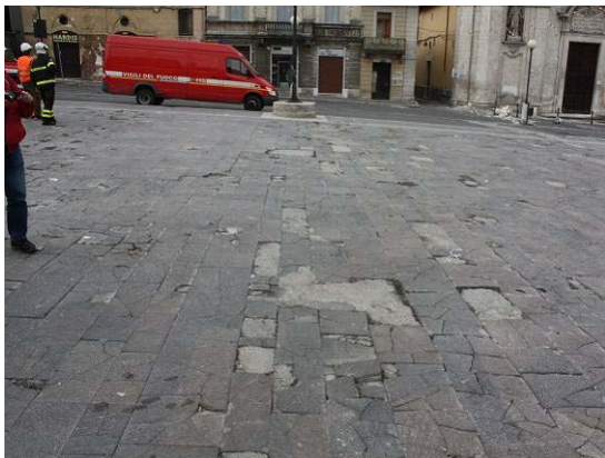
写真6 浮きや割れの生じた石畳
