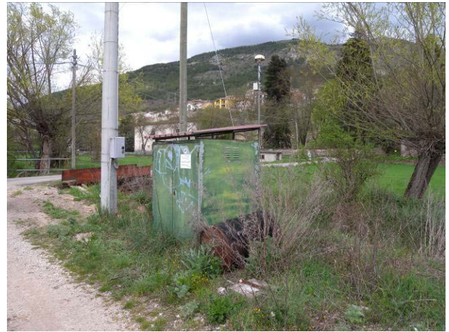
写真30 強震計 GX066 の設置状況
