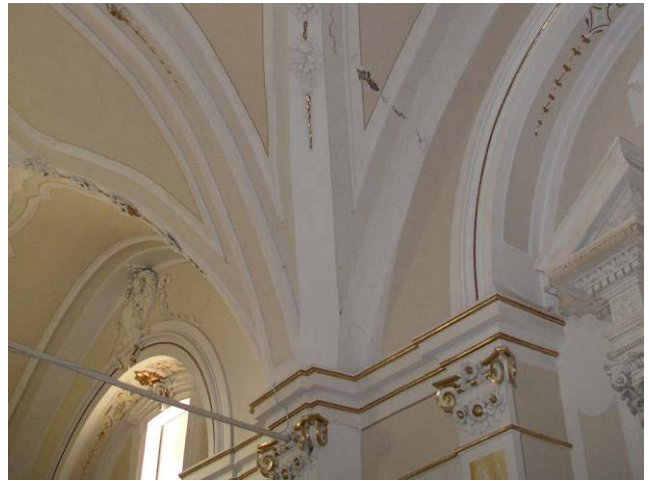
写真 20 ヴォールト天井のひび割れ
