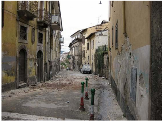
写真 23 Via Donadei 通りの仕上剥落
