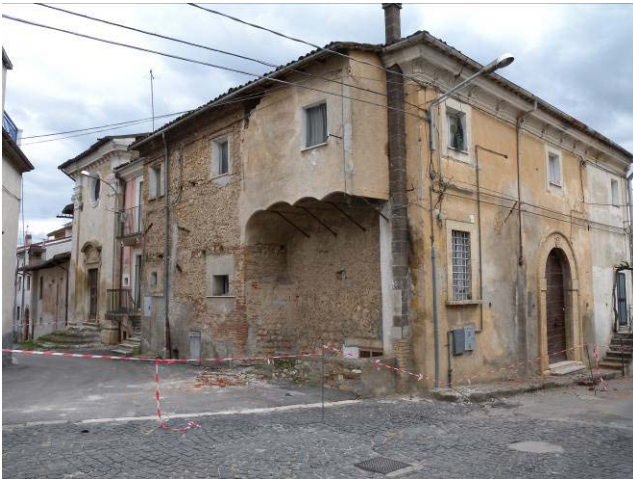
写真 27 自然石の石積み住宅
