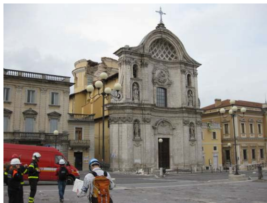
写真8 ドームが崩壊した教会
