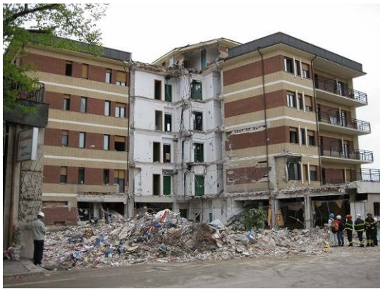
写真 34 学生寮の崩壊
