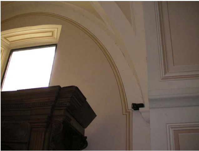
写真 21 アーチに沿うひび割れ
