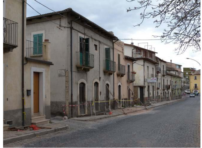
写真 26 歩道部分を封鎖している例
