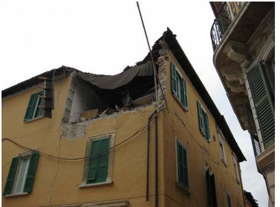
写真 25 組積造3階部分の外壁が崩落
