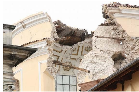
写真9 崩壊したドーム
