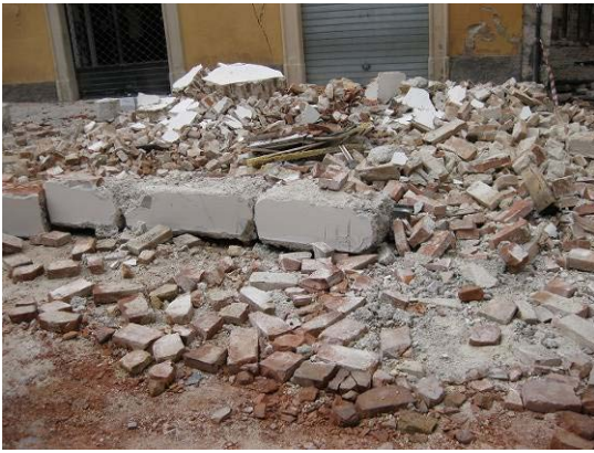
写真26 組積造3階の崩落した壁の残骸
