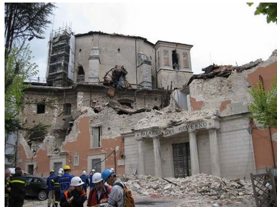
写真29 組積造の2階部分が崩壊
