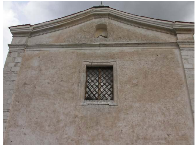
写真 22 ファサードのひび割れ
