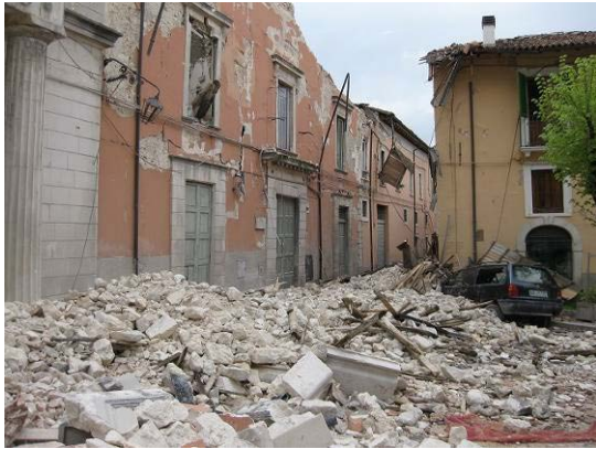
写真30 落下した外壁により車が下敷
