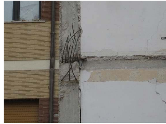
写真 37 4階連結梁主筋の露出と非連結の床
