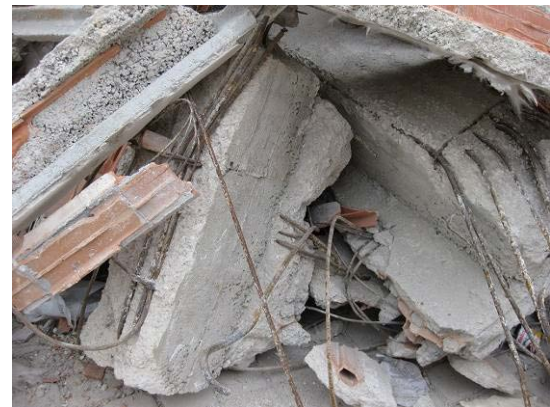
写真 39 寮崩壊付近のRC部材の残骸
