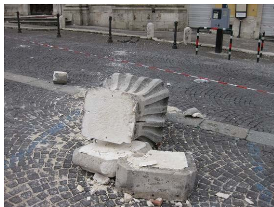
写真10 教会頂部から落下しバウンド
