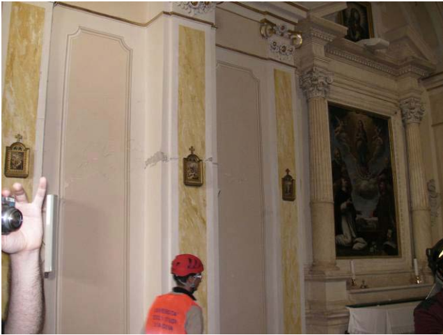
写真 19 柱・壁の水平ひび割れ
