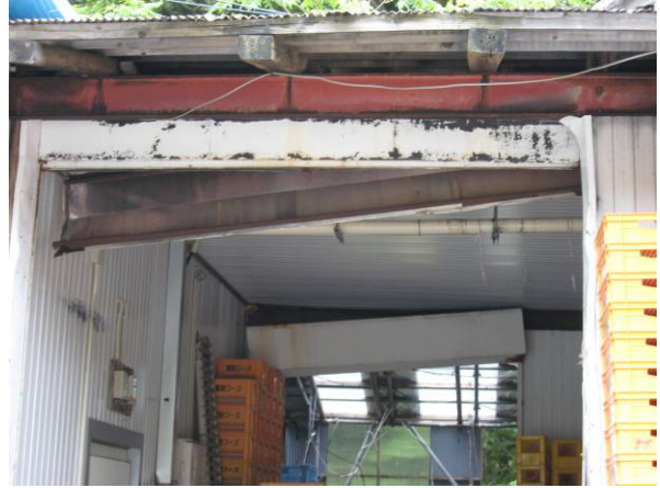
写真16 シャッターカバーの落下
