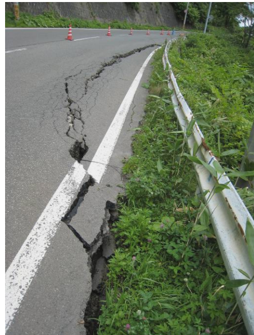
写真10 亀裂の様子
