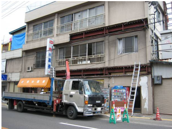
写真5 外壁の撤去作業（国道13号線沿い）
