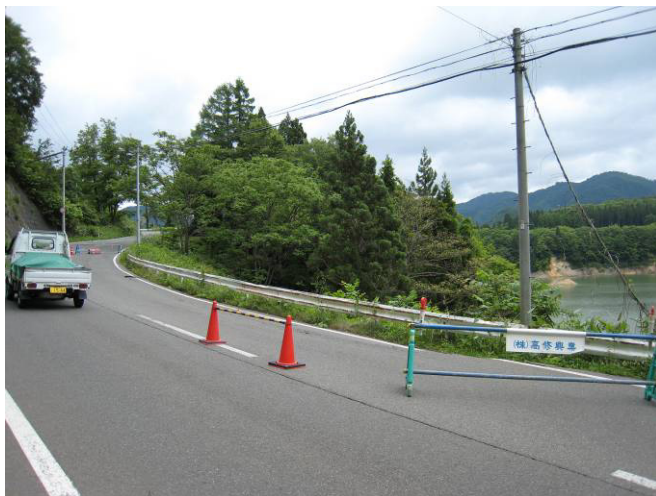
写真9 道路の崩れ(国道398号線)
