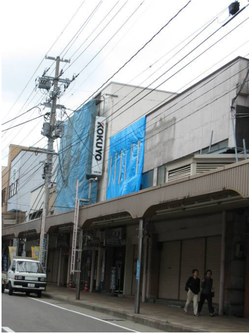
写真7 外壁仕上げの剥離跡
