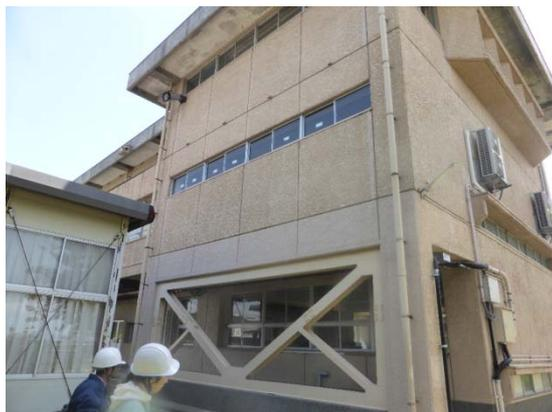
鉄骨ブレースによる耐震補強
