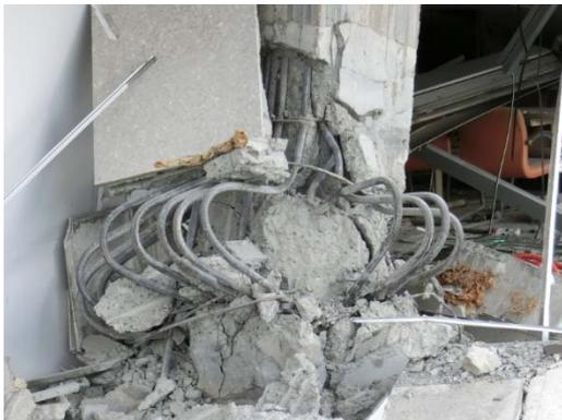
軸崩壊した柱
