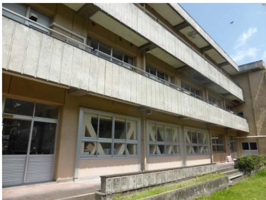
鉄骨ブレースによる耐震補強
