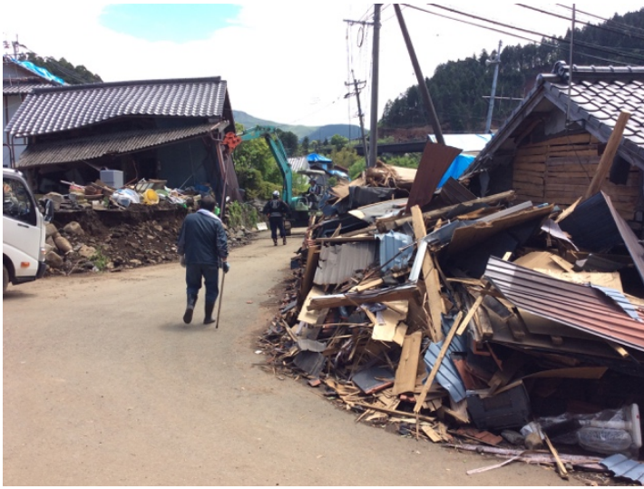
右手の倒壊建物は、生き埋め者が救出された家屋
