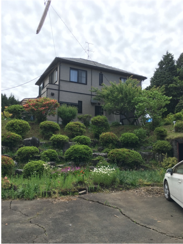
比較的新しく，ほぼ無被害な建物。
