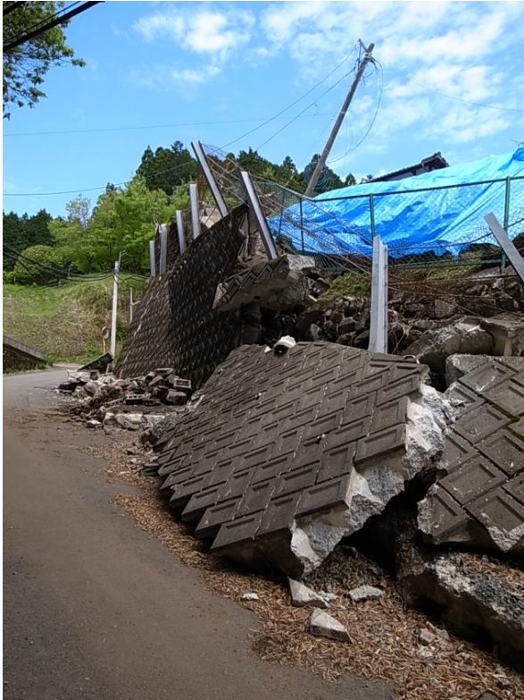
左) 擁壁の崩壊, 右) 石垣の崩壊
