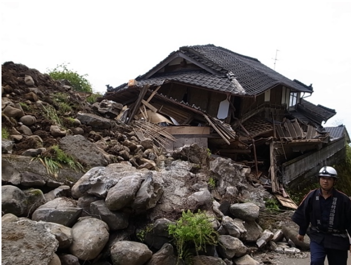
玉石積み擁壁の崩落に伴う上部建物の崩落。
