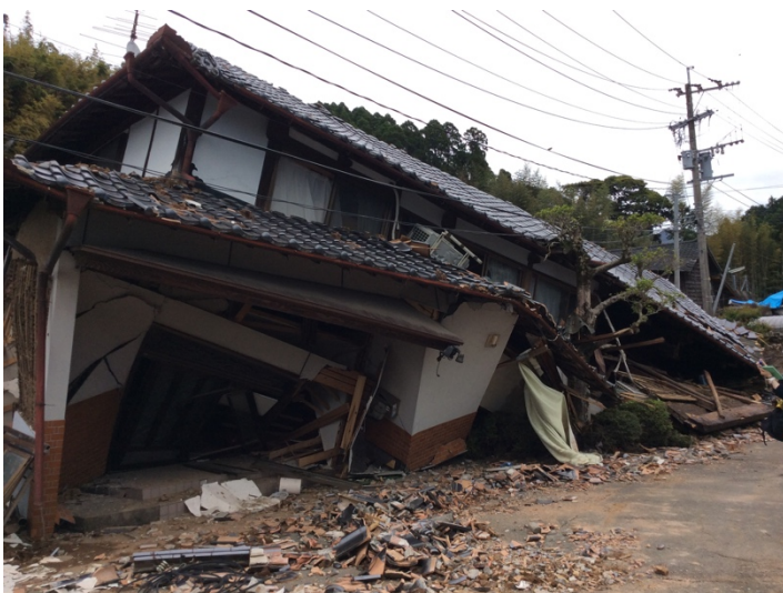
重い屋根の古い構法の木造家屋の倒壊。
