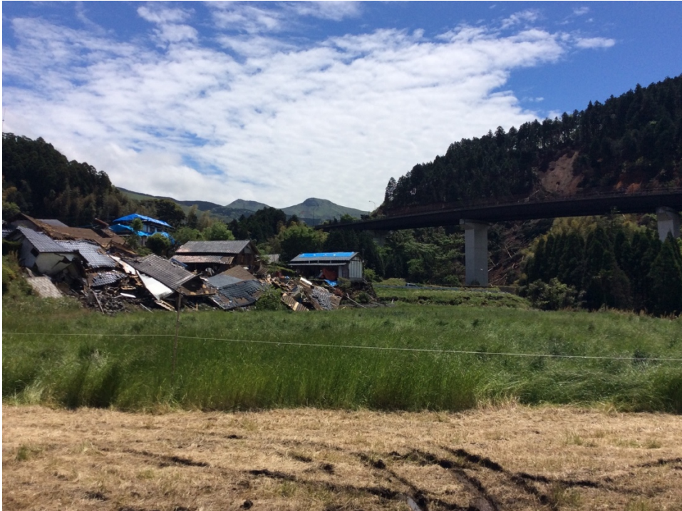
右手に県道 28 号船の高架橋（通行止め）左側が多切畑集落。
