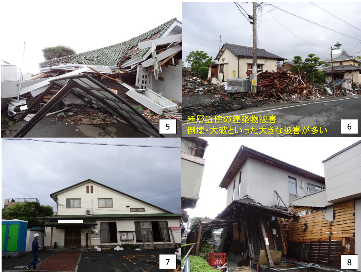
写真 5.2 断層近傍の様子 2 (益城町木山・宮園)
