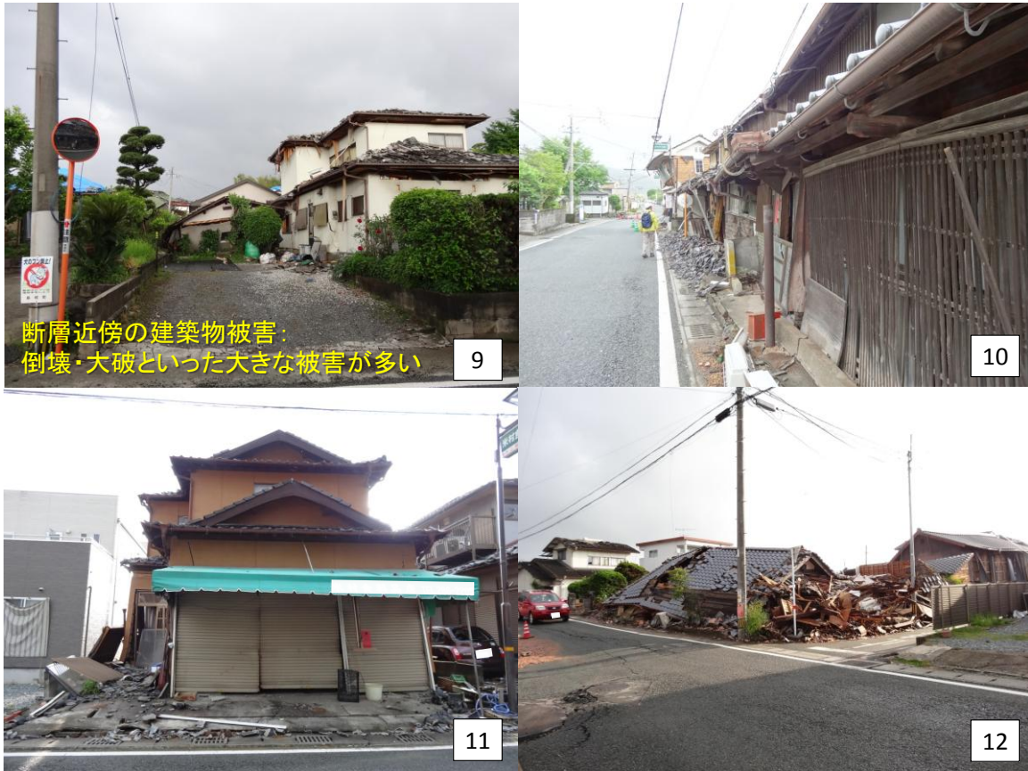
写真 5.3 断層近傍の様子 3 (益城町木山・宮園)
