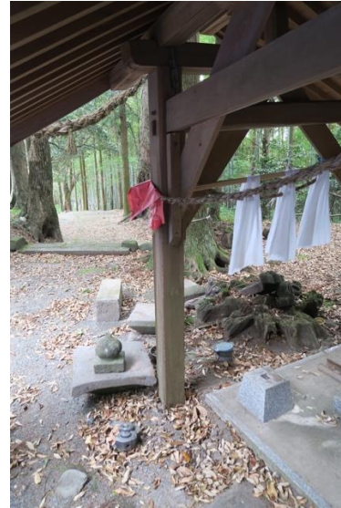
写真 4.10 束石から落ちた柱の様子
