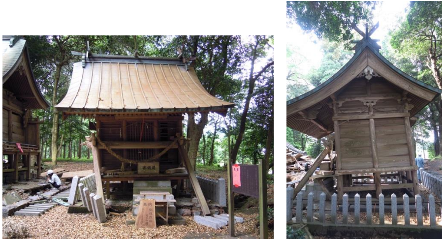
写真 4.6 本殿 2 の全体写真
