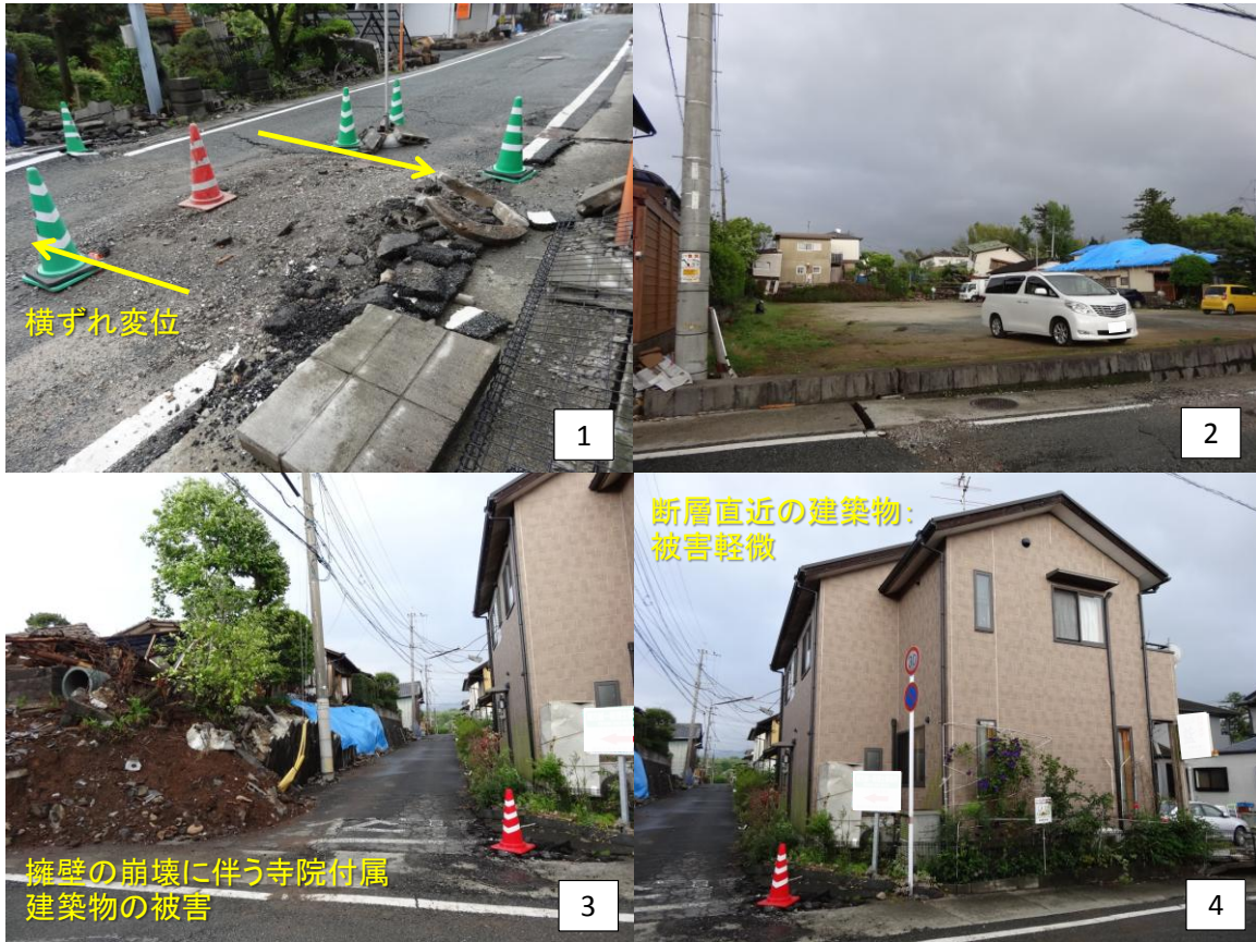
写真 5.1 断層近傍の様子 1 (益城町木山・宮園)
