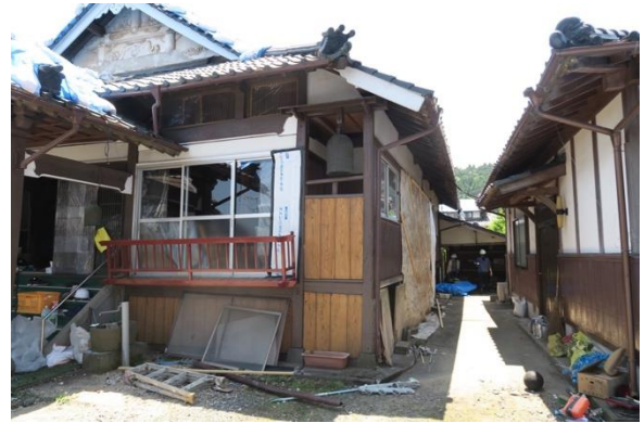
写真 4.26 外壁の損傷
