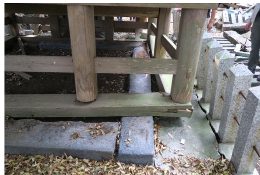
写真 4.8 柱脚部の滑動の様子
