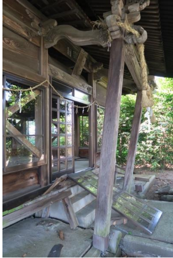
写真 4.16 向拝の柱の傾斜
