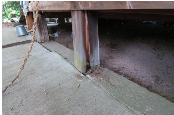
写真 4.15 柱脚部の割り裂け
