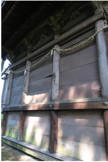
写真 4.21 背面の壁面の仕上げ用鋼板の歪み
