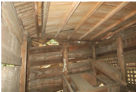
写真 4.3 本殿 1 の内部の様子
