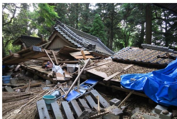
写真 4.1 倒壊した拝殿
