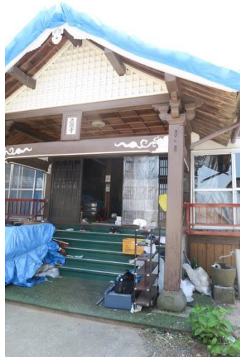
写真 4.27 向拝の柱の傾き
