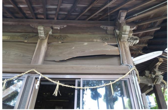
写真 4.13 板壁の面外座屈による割れ
