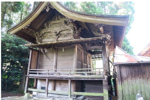
写真 4.19 本殿の全体写真
