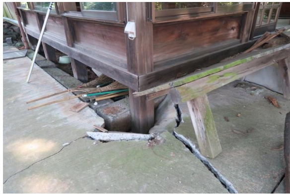
写真 4.14 柱脚の滑動
