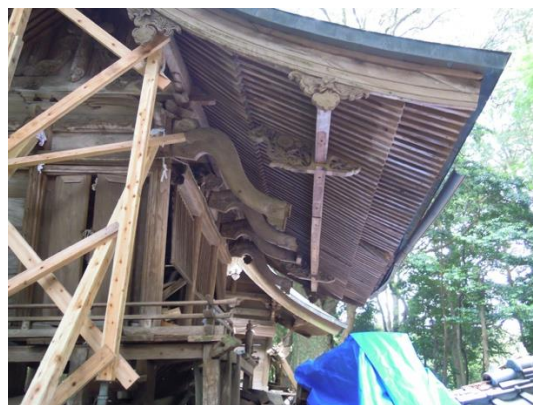
写真 4.5 向拝部分の様子
