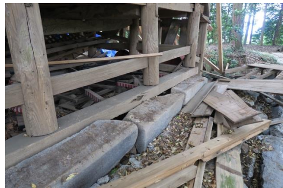
写真 4.4 本殿 1 の柱脚部および礎石の様子
