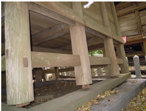
写真 4.7 ロッキングによる柱脚ほぞの引き抜け
