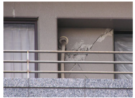
マンション⑤にも類似の被害
