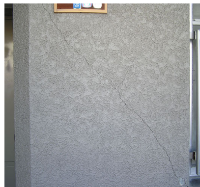
玄関側壁に見られるせん断亀裂
