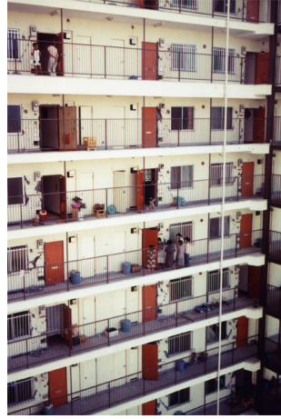
1978年宮城県沖地震で今回と同様の被害を受けた仙台市内のマンション
