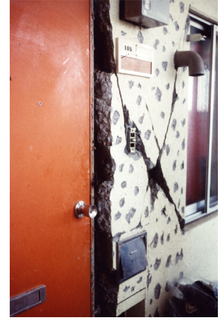
1978年宮城県沖地震で今回と同様の被害を受けた仙台市内のマンション
