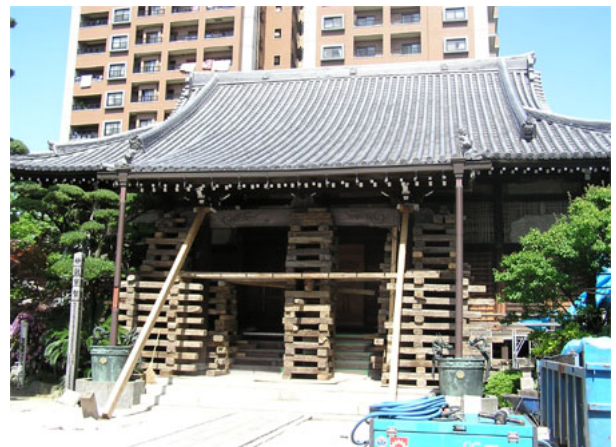
長円寺の本堂も被害を受け修復中
