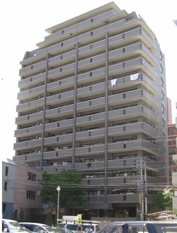
←マンション③の外観
