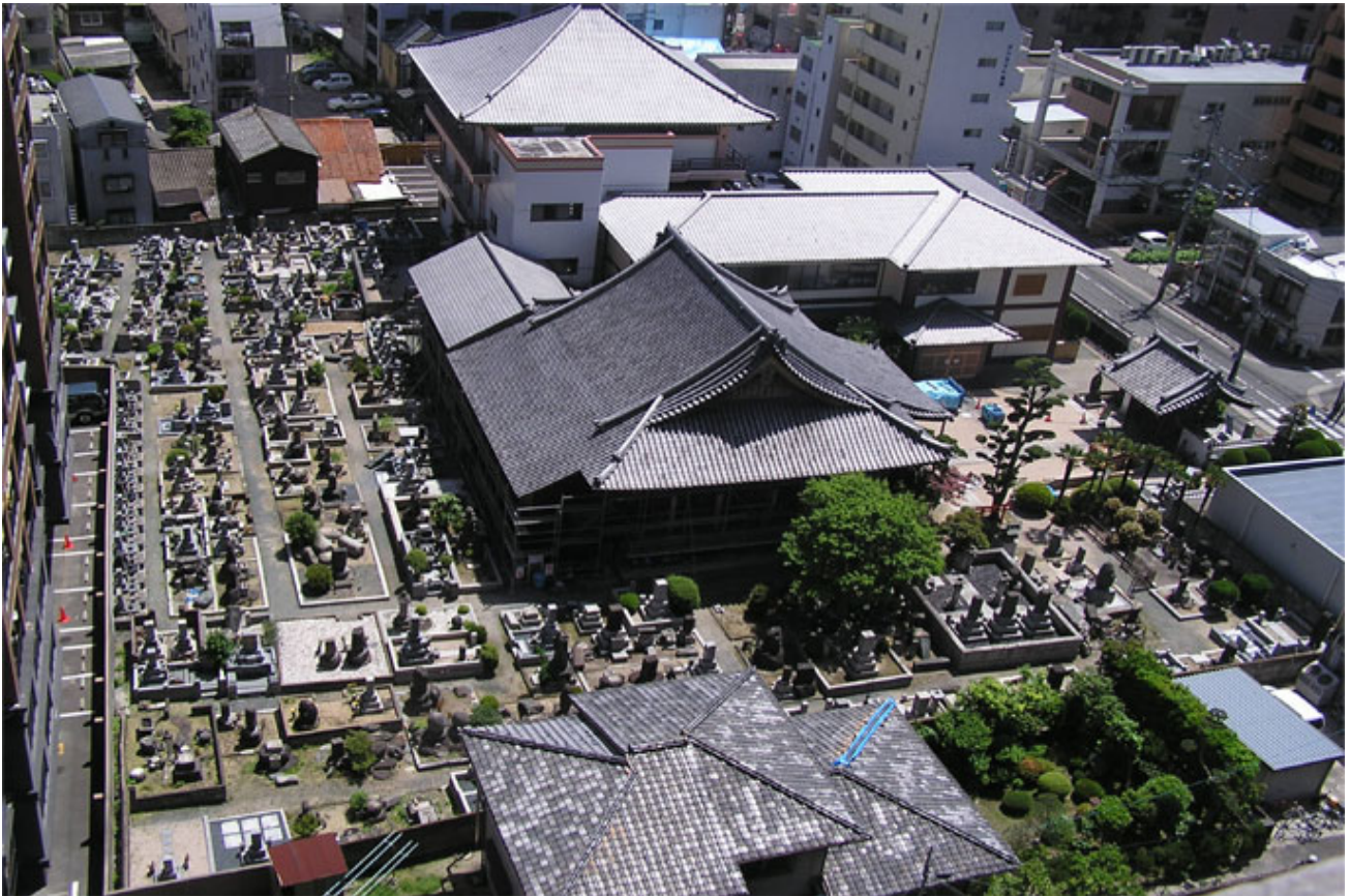
マンション③の上階から見た長円寺と墓石の転倒状況
