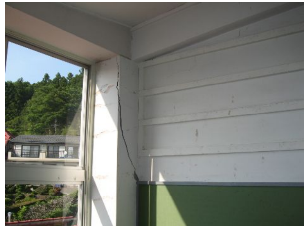
写真 15-5. 2 階柱の亀裂
