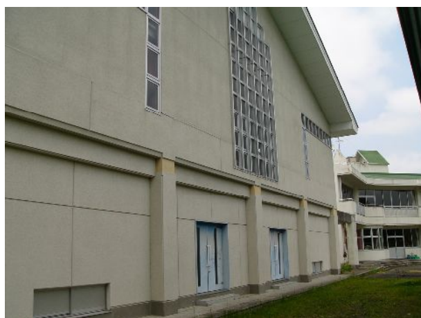
写真 7-4 損傷のない東面
