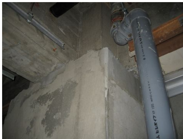
写真 4-14. 補強柱の柱頭
