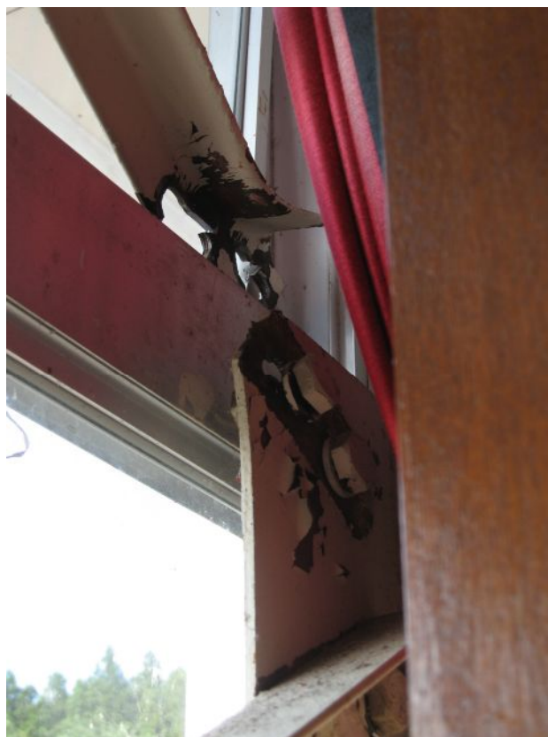
写真 15-16. 鉄骨ブレースの破断
