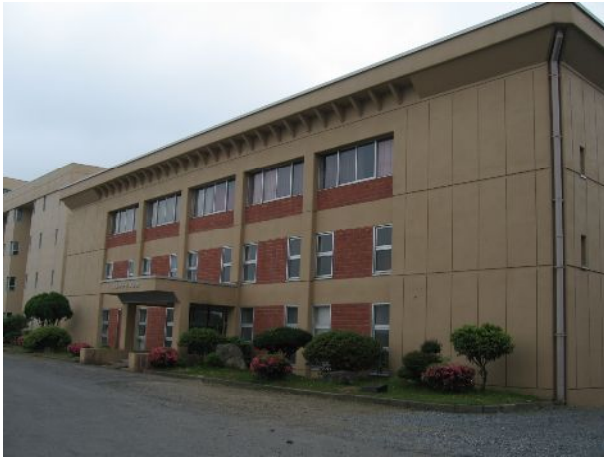
写真 4-17. 栗駒中体育館の全景
