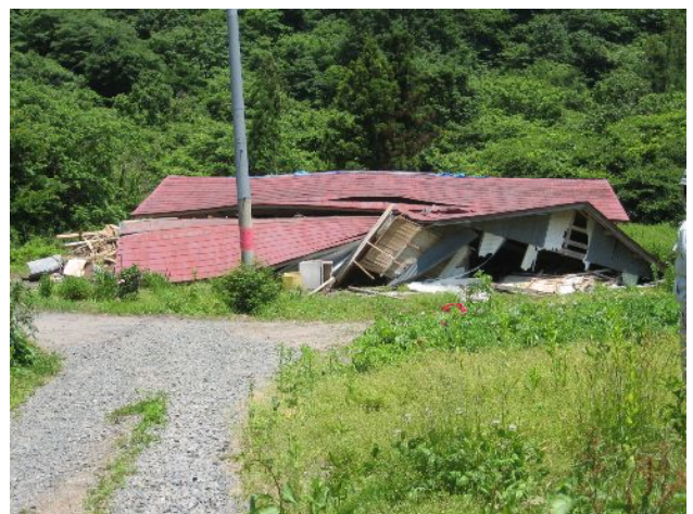
写真9 倒壊家屋(花山)
