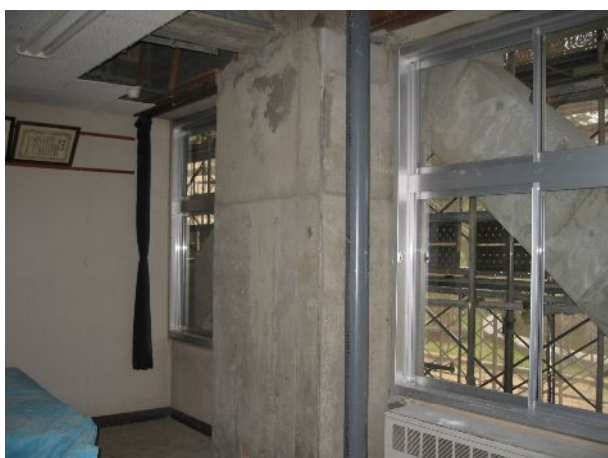
写真 4-13. 補強柱室内側(被害なし)
