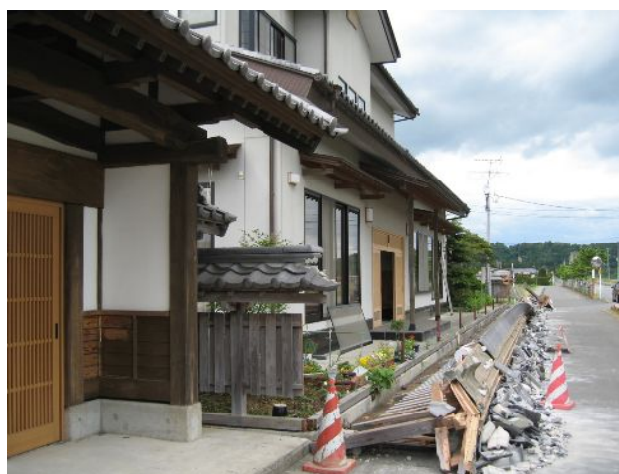
写真 1 倒壊した板塀(一迫)
