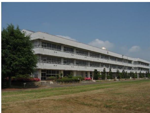
写真 8-1 被害のない校舎
