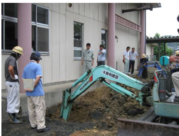
写真 14-8 基礎杭調査の掘削
