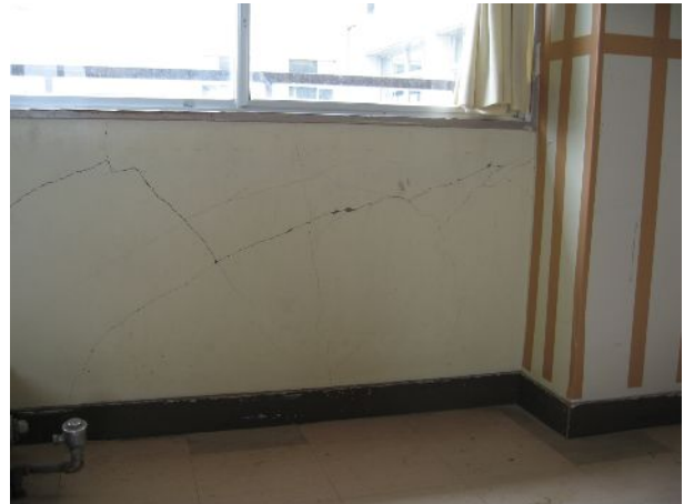
写真 3-5. 腰壁の亀裂
