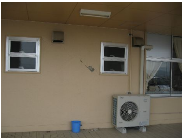
写真 4-2. 雑壁のせん断亀裂
