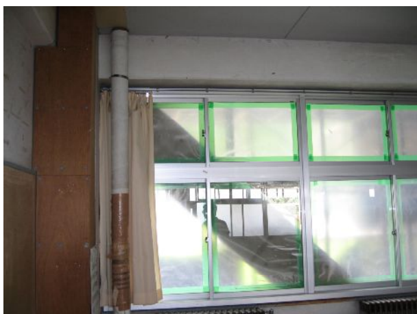
写真 4-12. 補強箇所室内側
