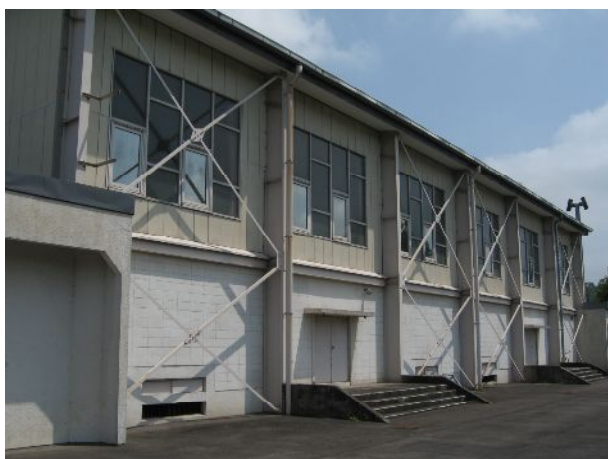
写真 8-2 体育館の全景
