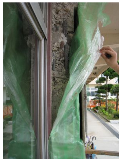
写真 15-10 1 階柱のコンクリート
