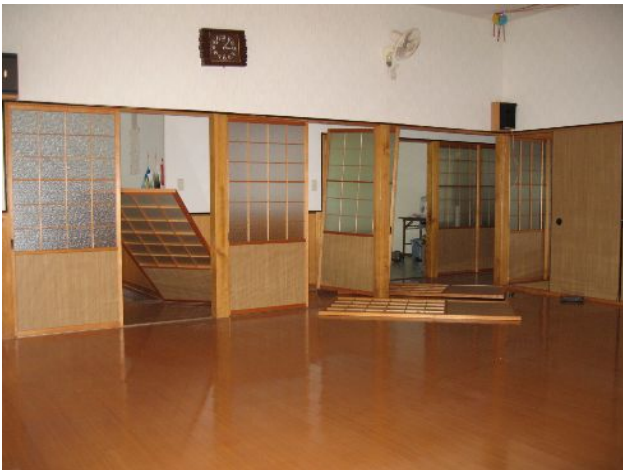
写真5 室内建具の散乱
