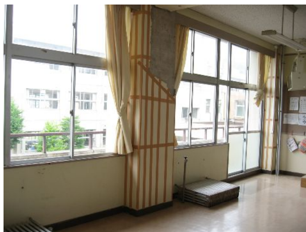
写真 3-10. 2階柱のモルタル剥落防止応急措置
