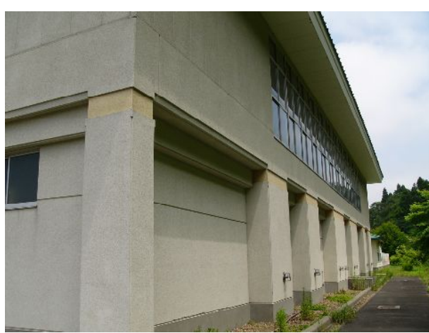
写真 7-5 損傷のない南面
