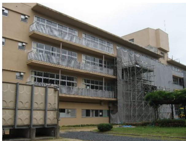
写真 4-15. B棟北面補強施工中の様子
