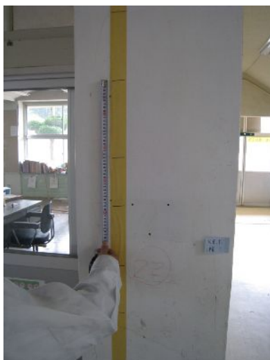
写真 15-9 廊下側柱の帯筋間隔計測
