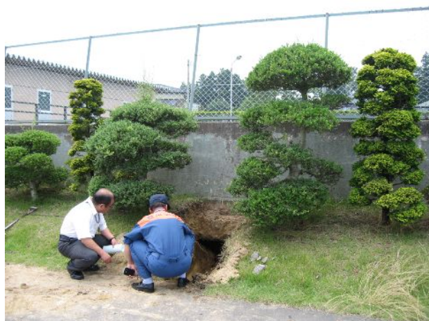
写真 14-14 擁壁支持杭の掘削調査
