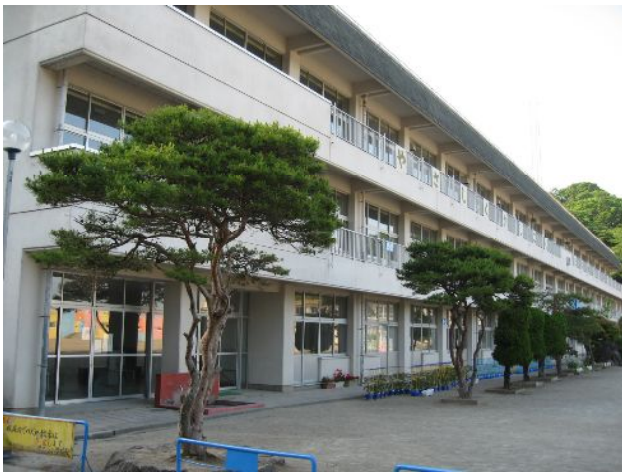
写真 16-1 新校舎の全景
