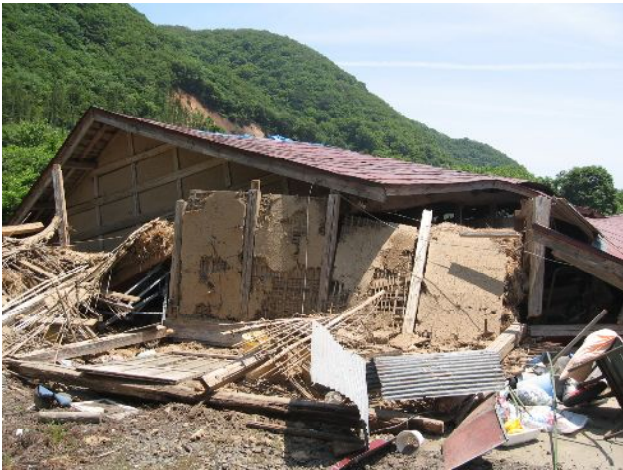
写真10 倒壊家屋(花山)
