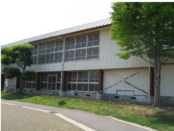
写真 9-2 鉄骨ブレース
