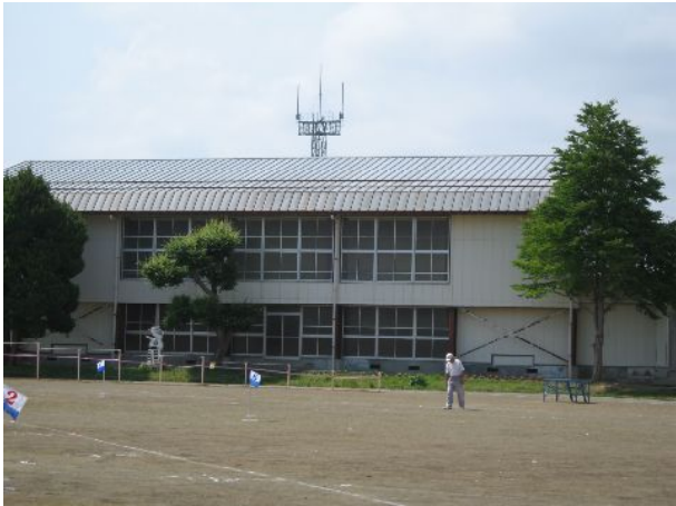
写真 9-1 体育館の全景
