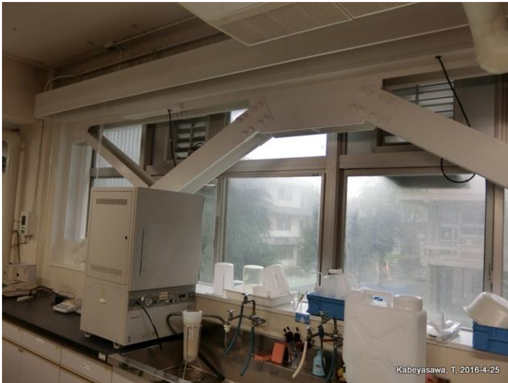
共用棟黒髪3（補強ブレース）
