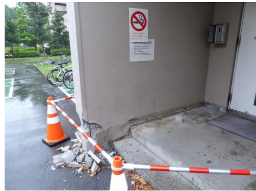
構面外壁の損傷
