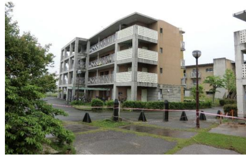
敷地内のほかの集合住宅 2
