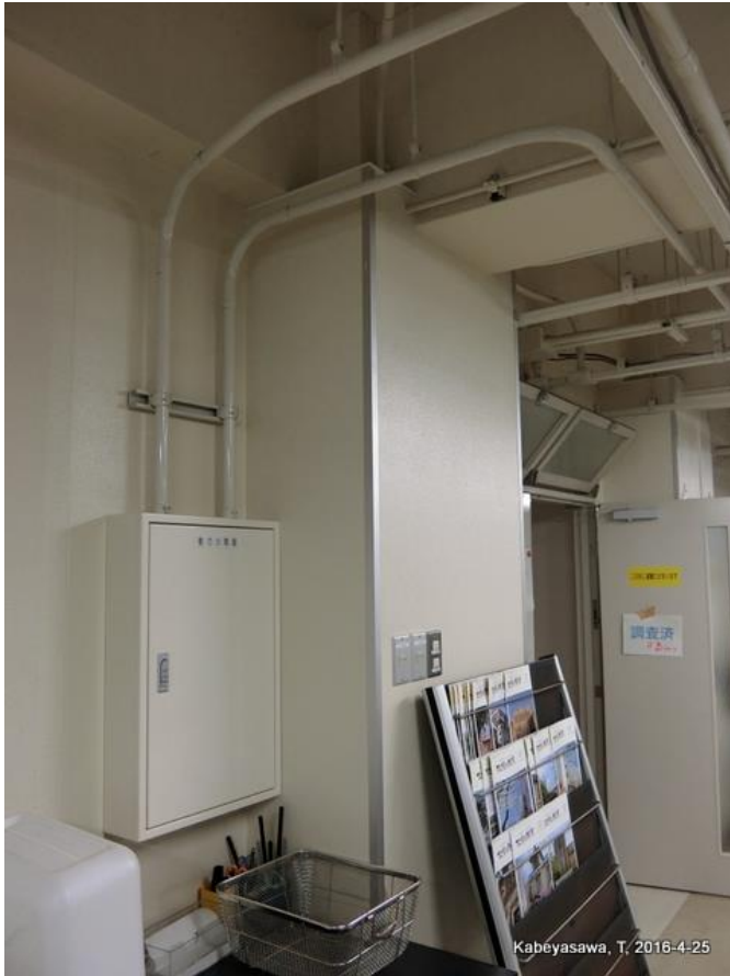
共用棟黒髪3（ポリエステル繊維補強柱） Column strengthened with polyester sheet without damages
