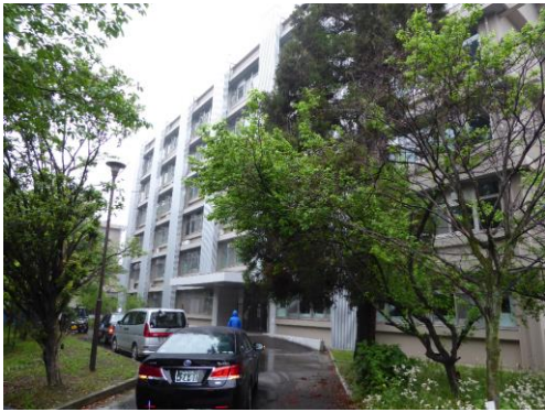
校舎外観（共用棟）
