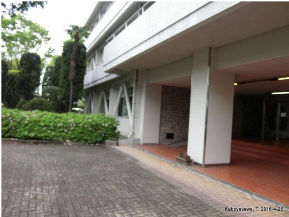
本館（ポリエステル補強の下階壁抜け柱）
