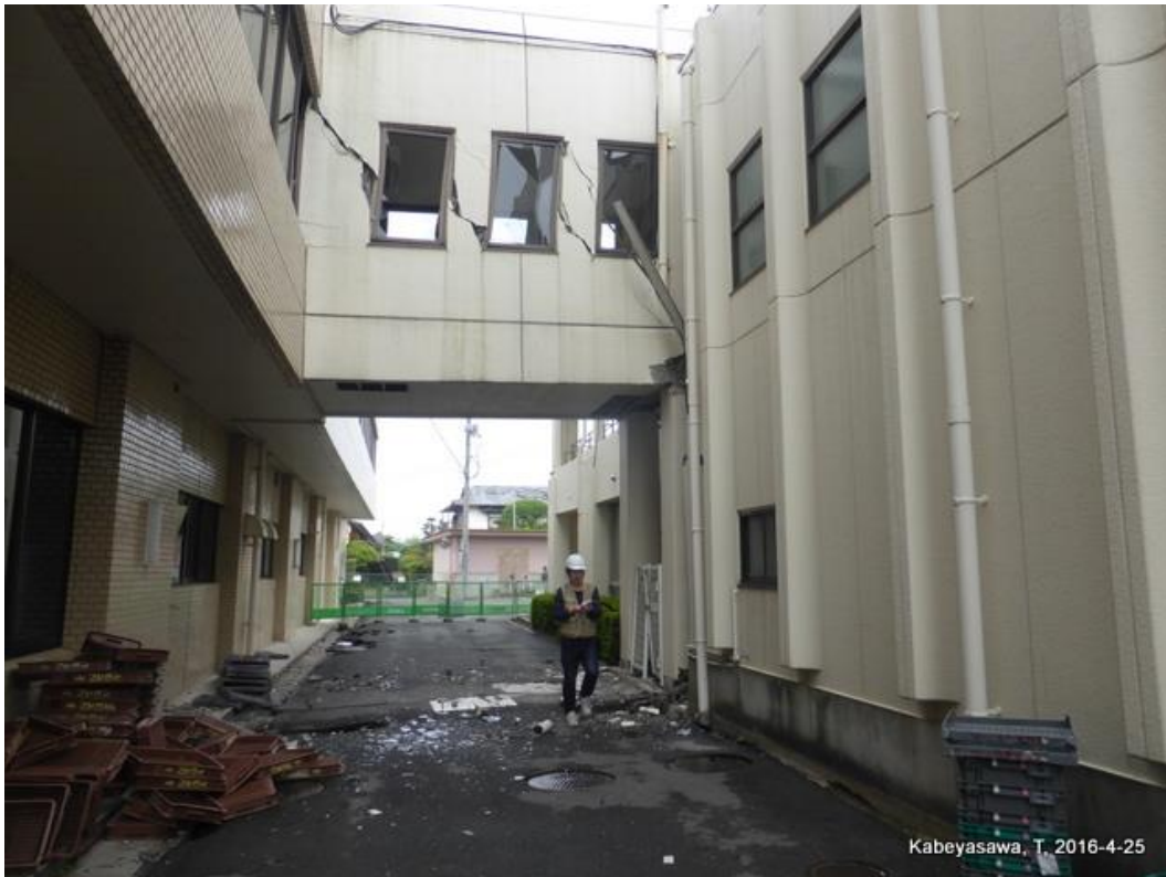
益城町役場（渡り廊下の（鉛直）せん断破壊） Shear failure of corridor
