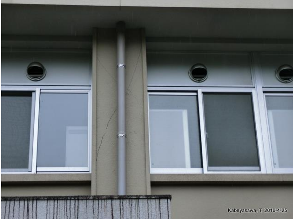
工学部 1 号館（柱のせん断ひびわれ）
