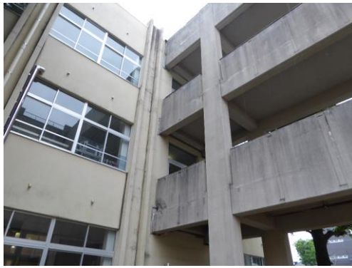
EXPJの被災状況
