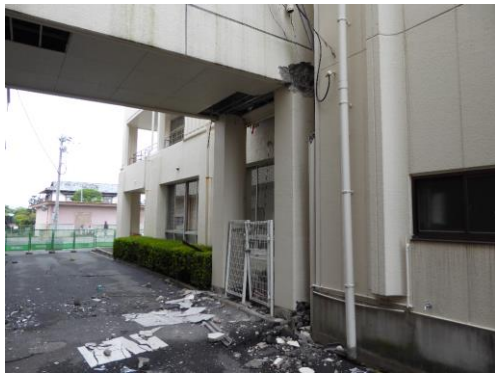
渡り廊下の損傷状況 Damages of support columns
