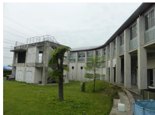
本体建物 2 Main building 2
