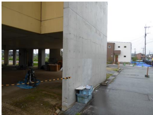
直交壁の面外ひび割れ Cracking
