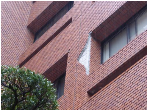
3階間柱のせん断ひび割れ
