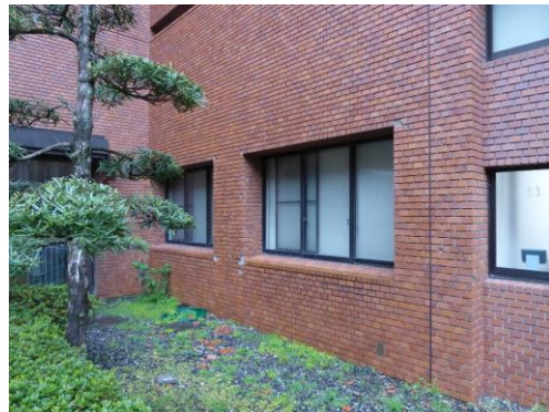
1階間柱のせん断ひび割れ
