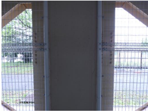
耐震補強ブレース接合部のひび割れ Cracking around braces
