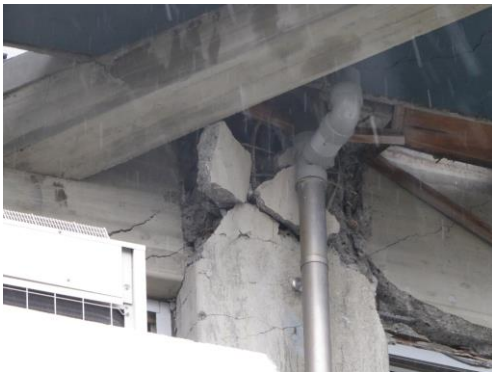
損傷した接合部の拡大写真 Joint failure
