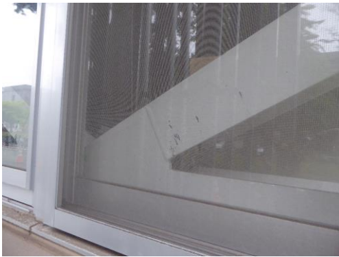
耐震補強ブレースの塗料剥がれ
