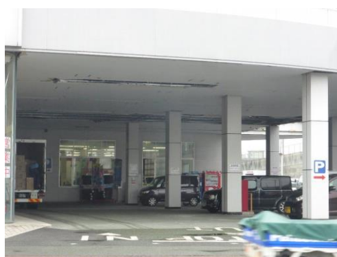
熊本市 天井の脱落被害
