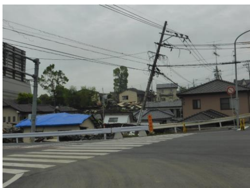
益城町 電柱の傾斜
