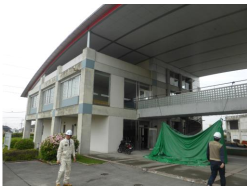
本体建物 1 Main building 1
