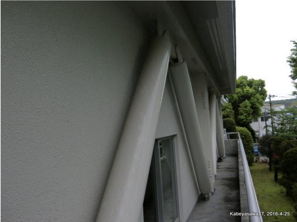
本館（張間補強ブレース） Steel braces in span direction
