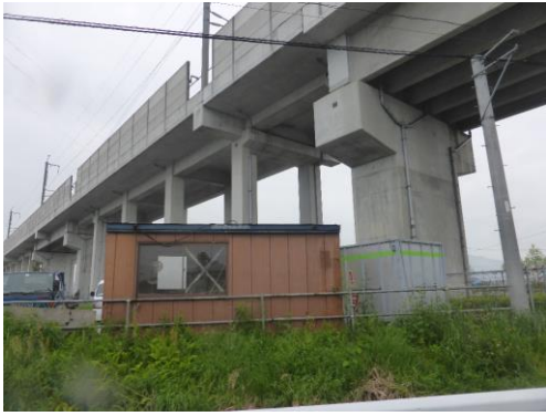
宇土市 RC造橋脚 (無被害)
