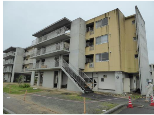
建物外観 Overview
