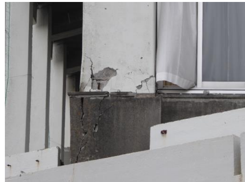
2階柱脚部分の損傷 Second story column base
