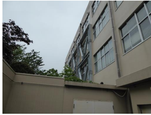
校舎外観 (校舎2)
