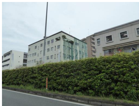
熊本市 病院の外壁（方立壁）の損傷
