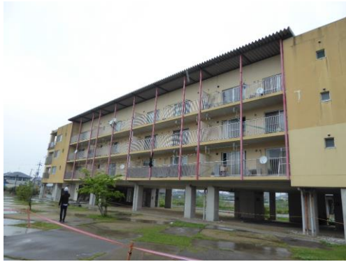
建物外観 Overview
