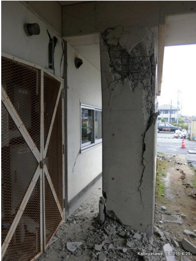
宇土市営団地（柱の付着破壊） Bond failure
