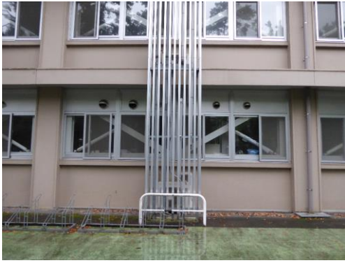
耐震補強ブレース
