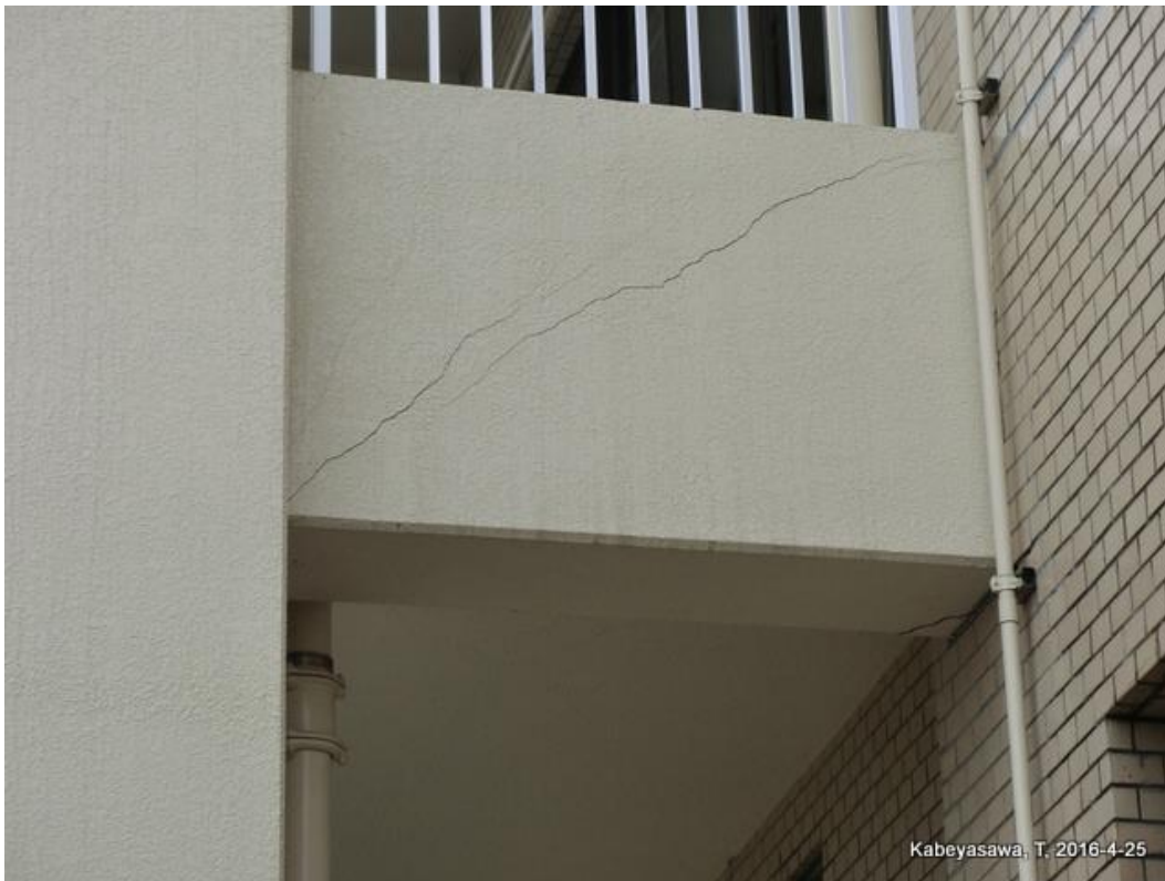
M 役場（補強フレームつなぎ梁のせん断ひびわれ） Shear cracking of connecting beams
