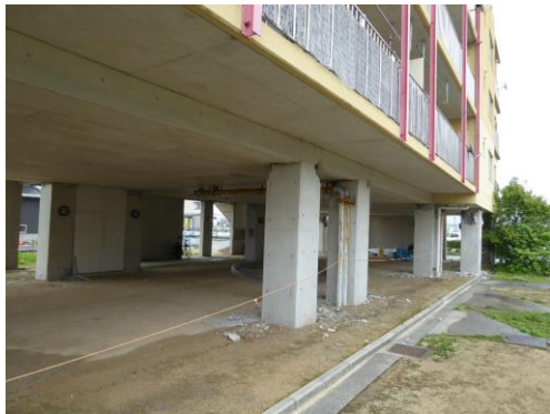
純ピロティ構面の被害 Damages
