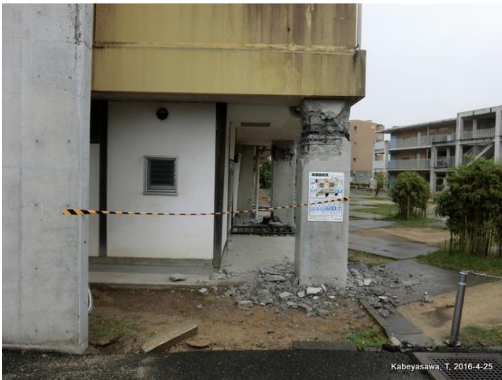
宇土市営団地（ピロティ柱頭の破壊） Colum top failure
