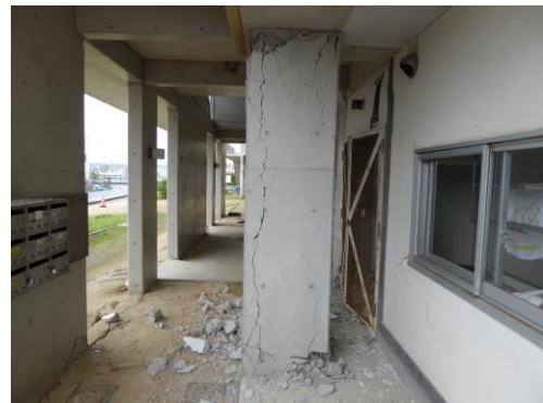
付着破壊した柱 Bond failure
