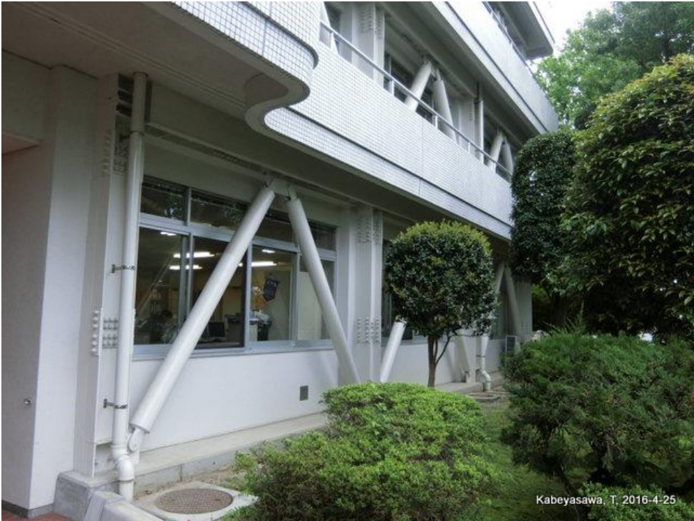
本館（桁行補強ブレース） Steel braces in longitudinal direction
