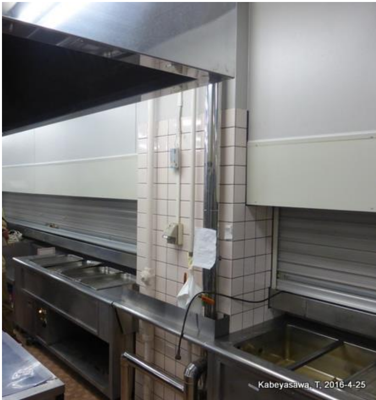
食堂棟（ポリエステル繊維で補強された短柱） No damaged short columns retrofitted with polyester sheet
