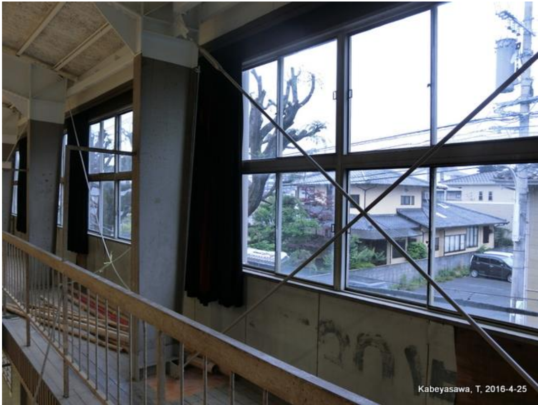
体育館（既存ブレースと補強ブレース） Old and retrofitted vertical braces
