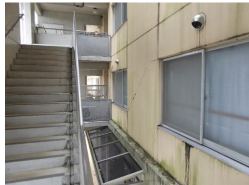
2階方立壁の損傷 Shear cracking
