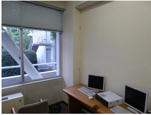
壁収縮目地でのひび割れ
