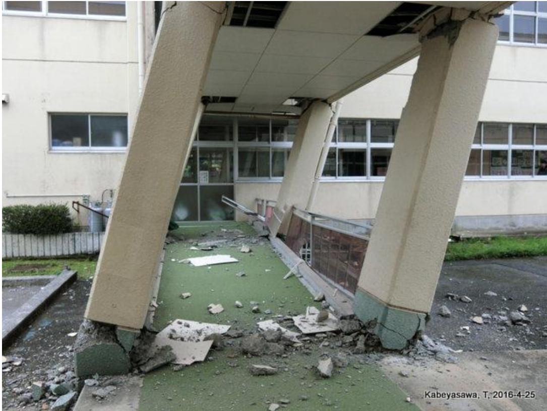
K 中学校（渡り廊下 1） Damages to Corridor 1
