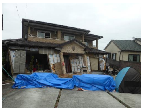
益城町 住宅の傾斜
