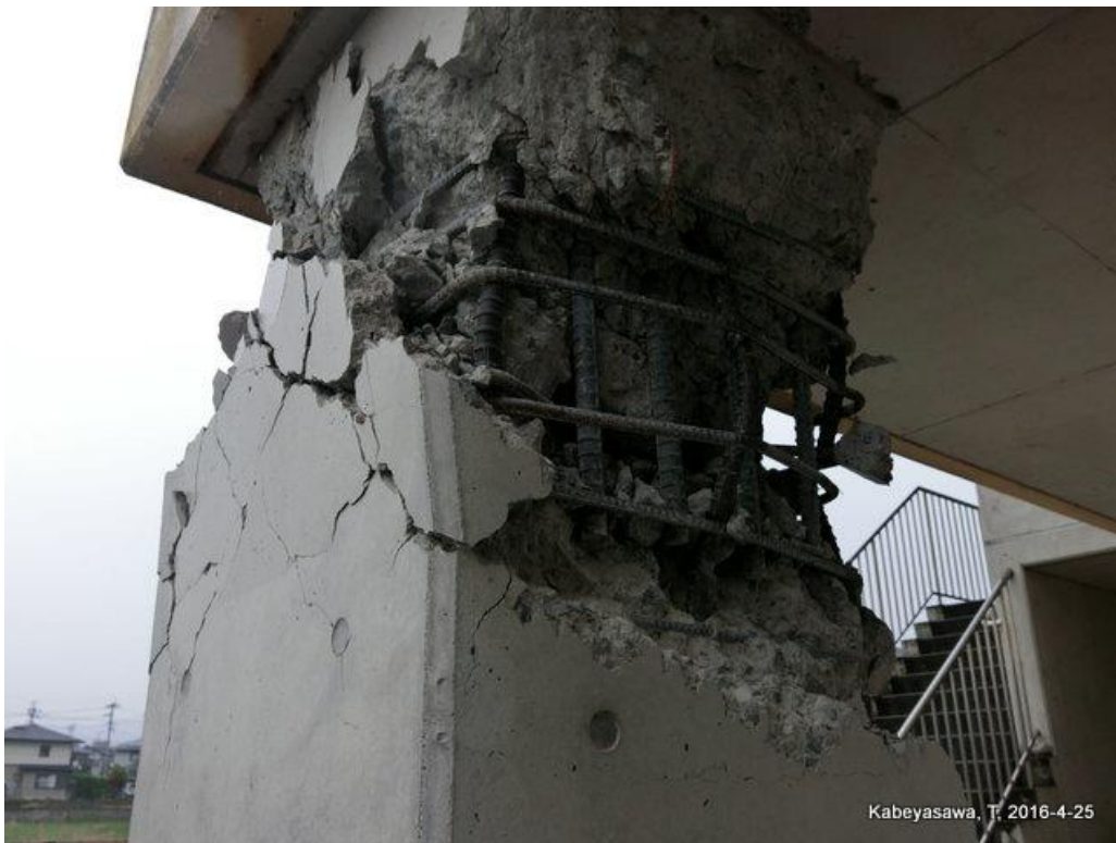
宇土市営団地（柱頭の破壊） Close-up to column top failure
