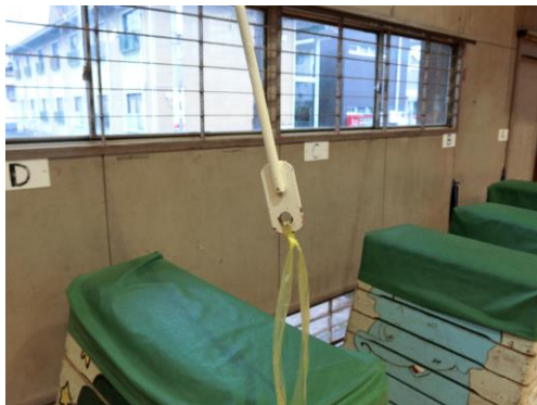
ボルト破断した既存屋根ブレース
