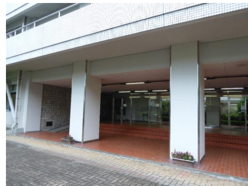
SRF シートによる補強
