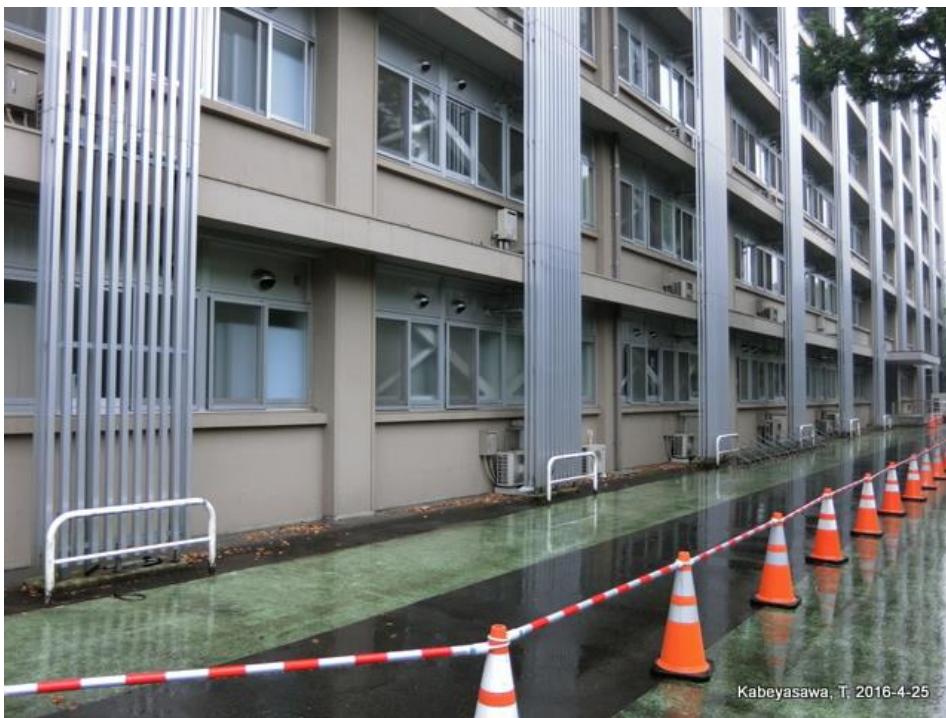
工学部1号館（ブレース+炭素繊維補強） No. 1 building with steel braces and carbon fiber sheet
