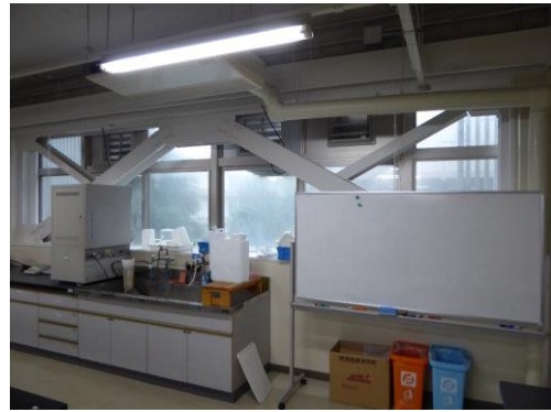
耐震補強ブレース
