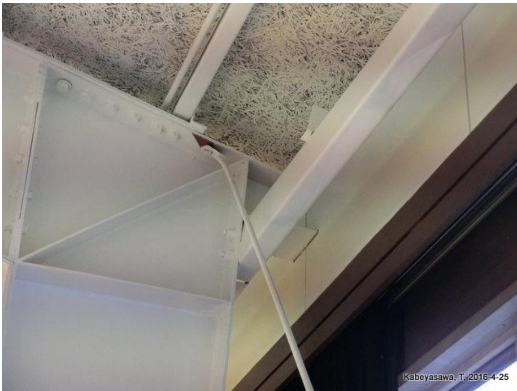
体育館（屋根ブレース端部、他端接合部ボルト破断） Break of roof braces
