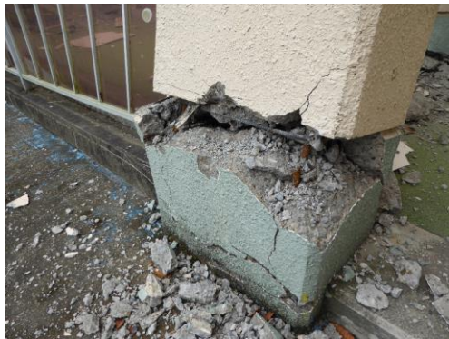
渡り廊下 主筋破断 Break of main bars
