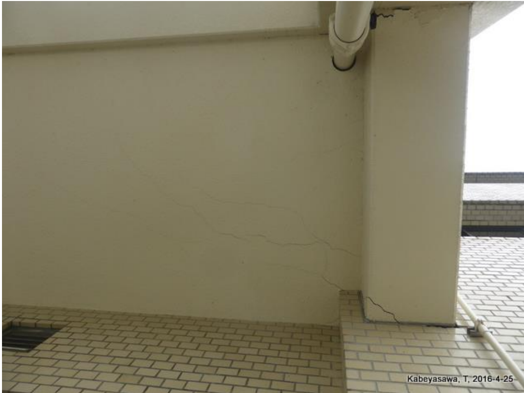
M 役場（耐震壁のせん断ひびわれ） Shear cracking of wall
