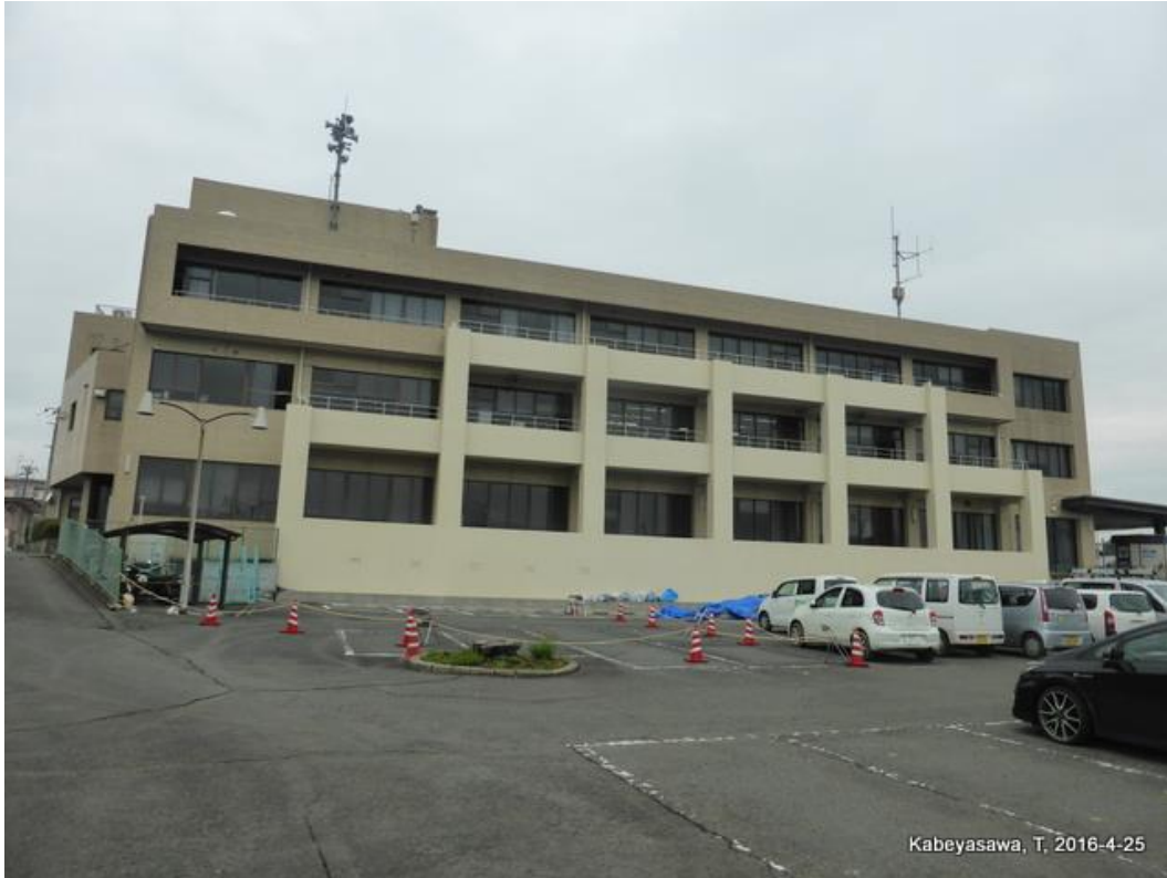
益城町役場（外付け補強フレーム） Overview with added external frames
