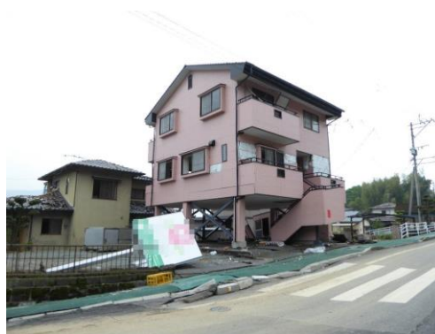
益城町 軽量鉄骨住宅（危険）
