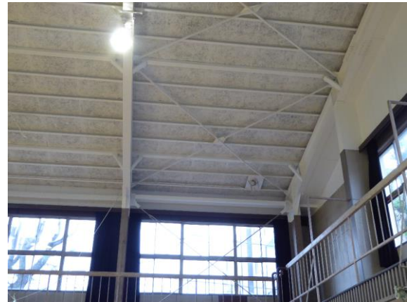
座屈したアングル屋根ブレース
