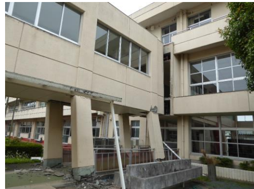
渡り廊下 EXP.J のずれ Large displacement
