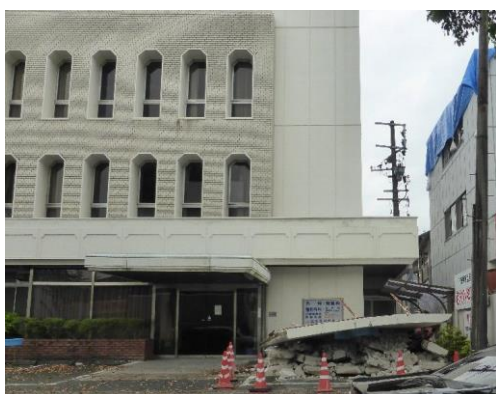
熊本市 外壁材の脱落
