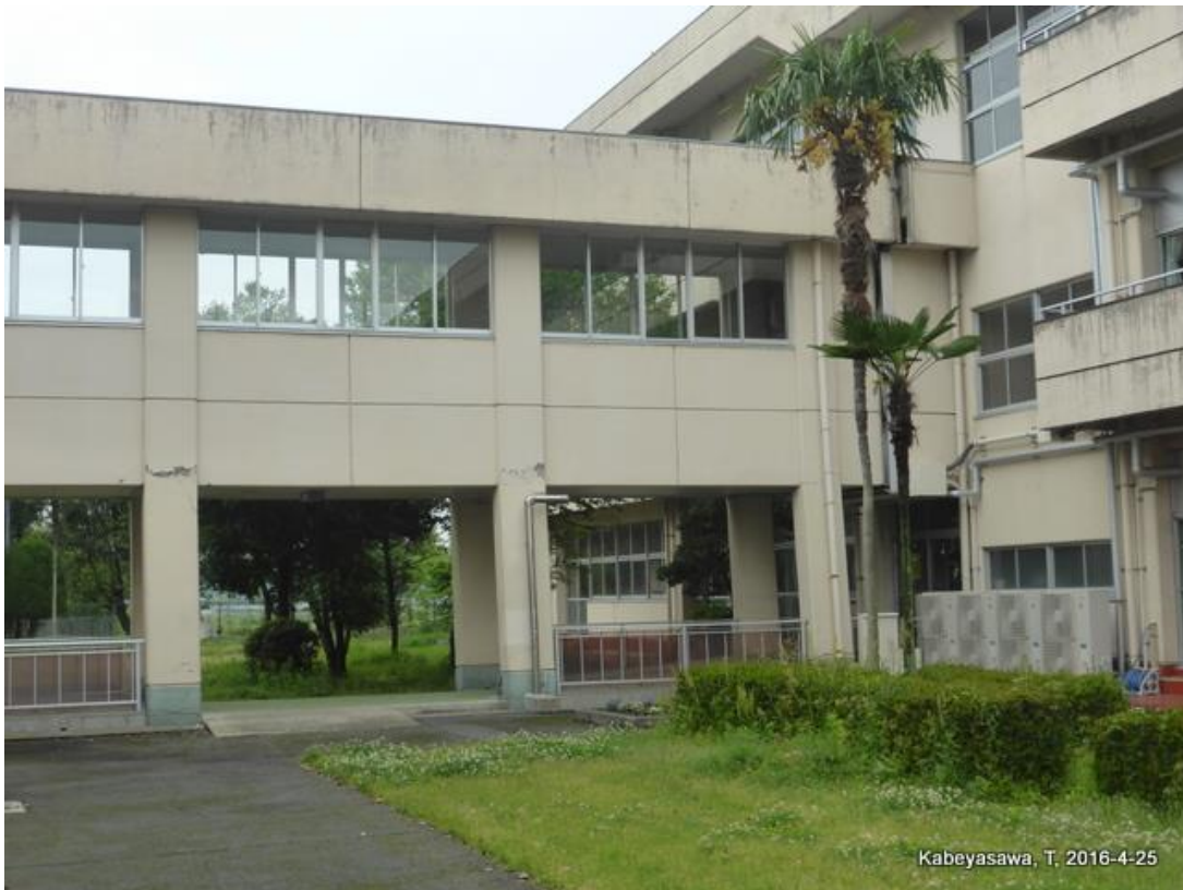
K 中学校（渡り廊下 2） Damages to Corridor 2
