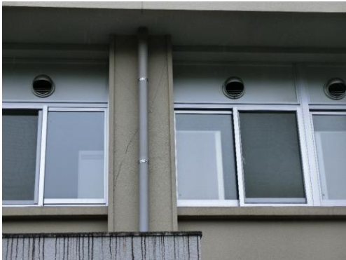
2階柱のせん断ひび割れ
