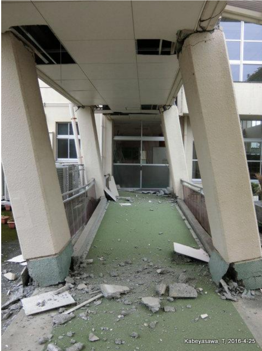
K 中学校（渡り廊下1） Damages to Corridor 1
