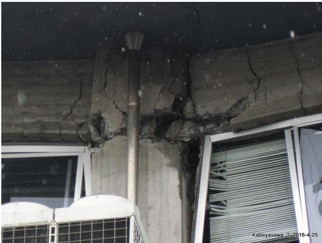
宇土市役所（柱梁接合部の破壊） Joint failure
