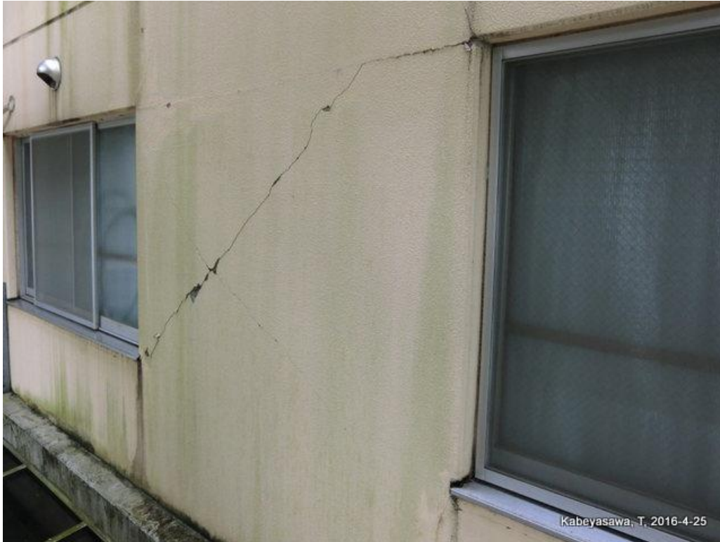
宇土市営団地（2階非構造壁のせん断ひびわれ） Shear cracking at non-structural wall in the second story
