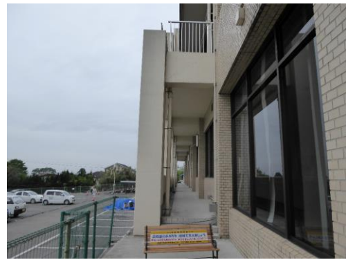
外付けフレームのせん断ひび割れ Shaer cracking of added external frames
