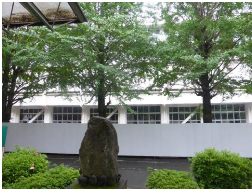
耐震補強された体育館
