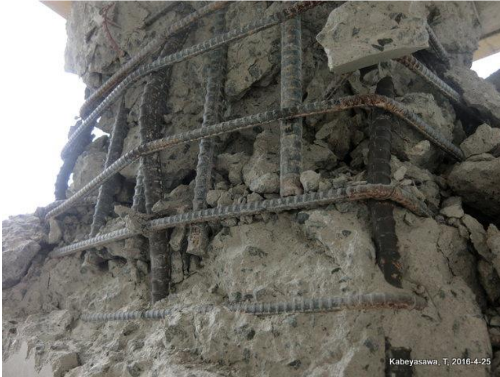
宇土市営団地（柱頭の破壊） Close-up to column top failure
