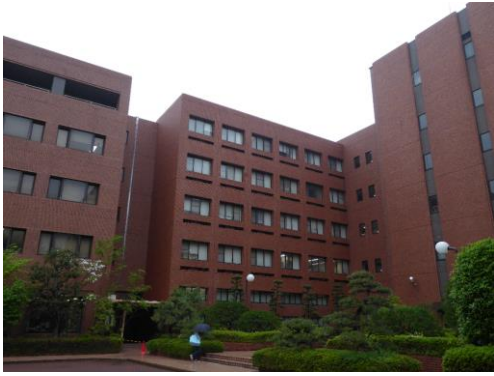
校舎外観 (校舎1)
