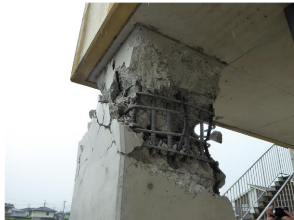
柱頭の損傷 (主筋破断) Break of main bars
