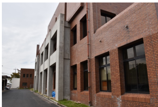
後面：外付け RC 造フレーム
