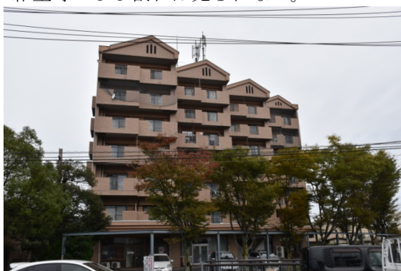
集合住宅（倉吉市東町） 雑壁等のひび割れは見られない。
