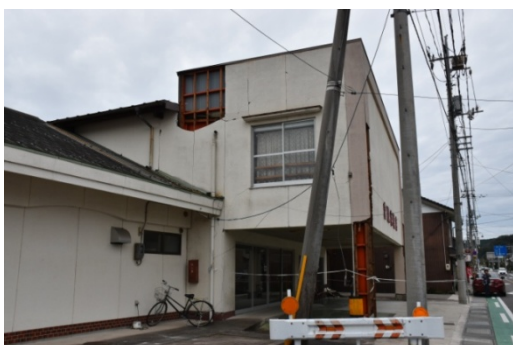
【鉄骨建物】 建物 (倉吉市福吉町) 外壁モルタルの破損
