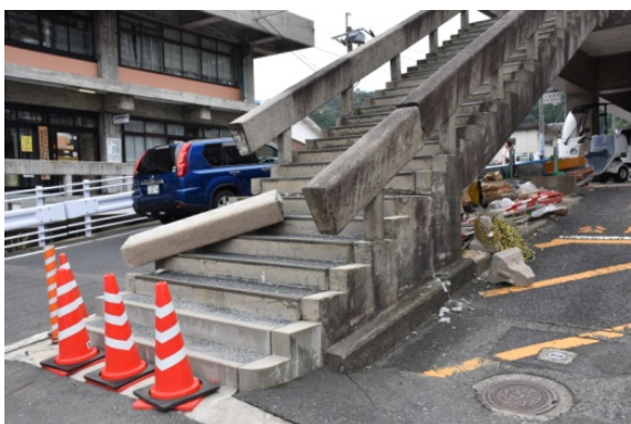
階段手摺破損
