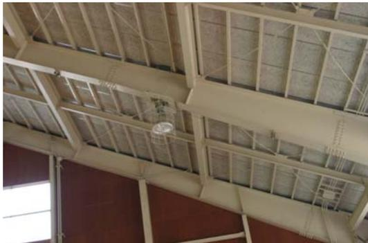
写真115 屋根面ブレースの弛緩（曲がり）
