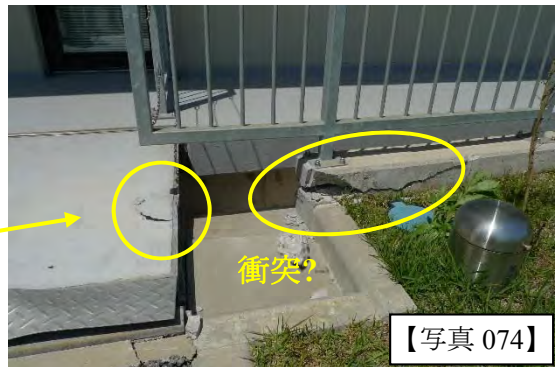
南側エキスパンションジョイントカバーの損傷に比べ北側のカバーでは少ない
