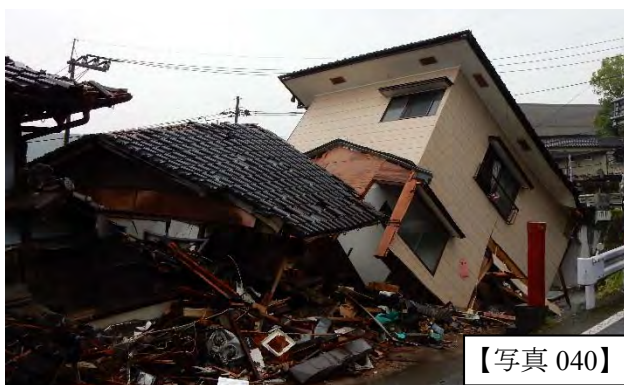
1層が層崩壊した木造住宅（手前）と建物ごと転倒した木造住宅（奥）
