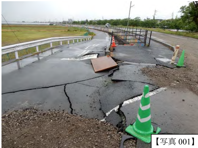
秋津川沿いの道路が沈下、川に架かる橋にも被害があったと見られる
