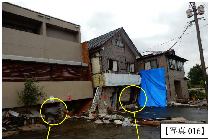
鉄骨 4 階建住宅の 2 層部分の崩壊、柱頭及び柱脚の溶接部の破壊
