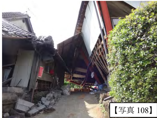
木造住宅（左）と一部 S 造倉庫？（右）の倒壊
