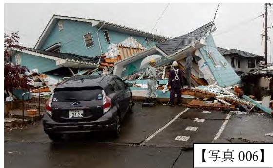
瓦・外壁が崩落した平屋
