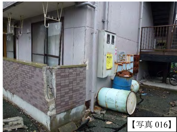
鉄骨造3階建集合住宅の1階に見られる外壁のクラック、応急危険度判定「要注意」
