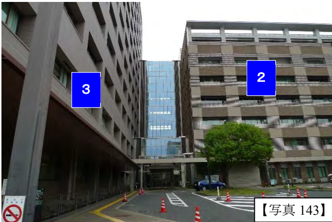
2棟の免震建築物。以降、建物②，建物③と略記。（右写真は建物配置図）
