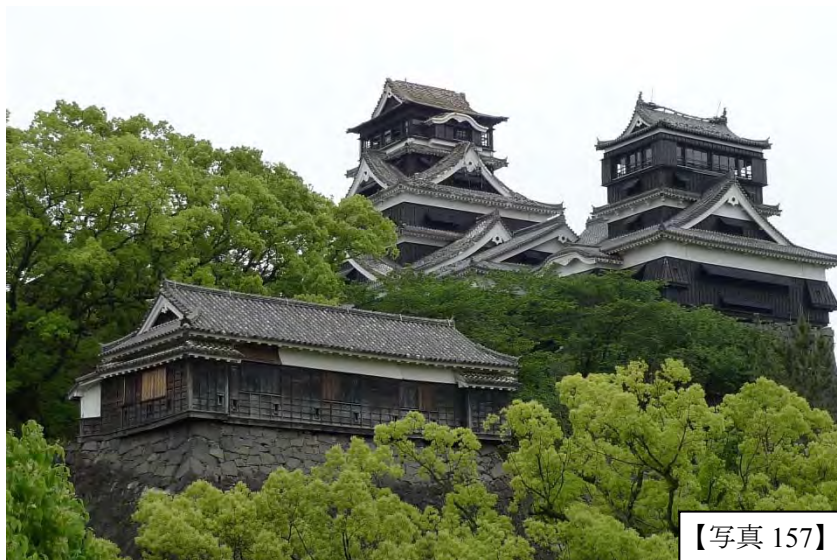
天守の瓦被害
