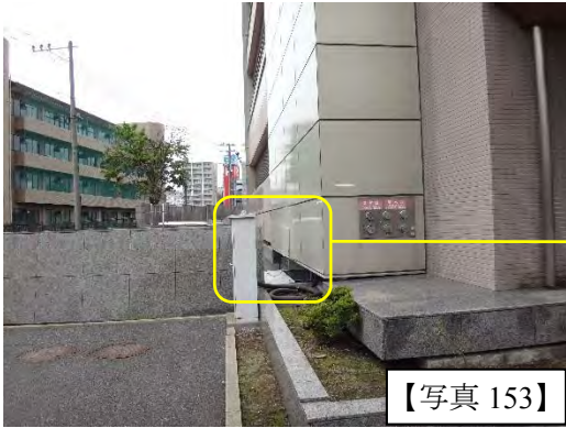
建物③のクリアランス部のチェーンの損傷。10～15cm 変形したと思われる。
