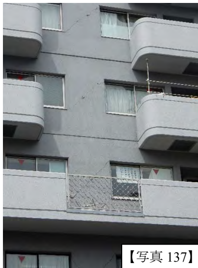
10 層建築物の 1 層柱のコンクリート表面の亀裂
