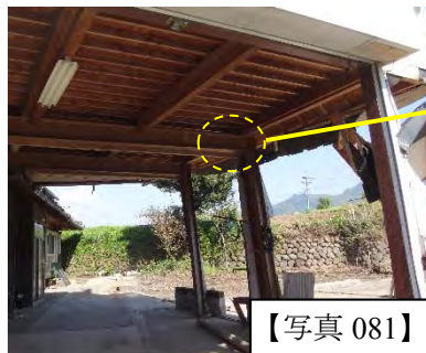
ピロティ部分に大きな変形
