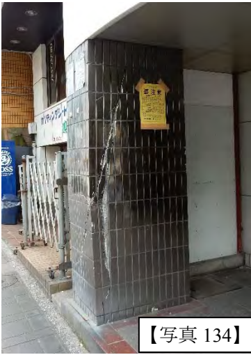
10 層建築物の 1 層柱のコンクリート表面の亀裂
