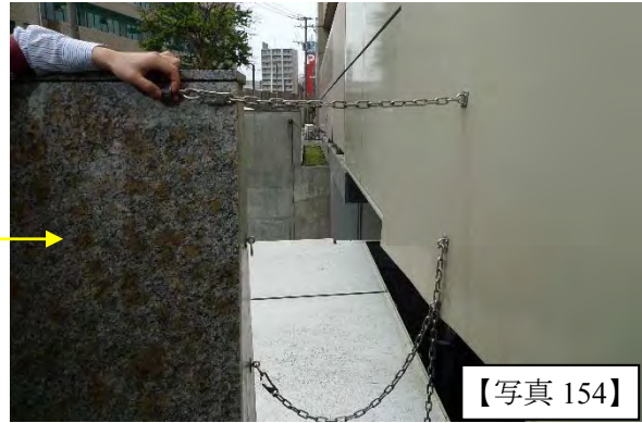
建物③のクリアランス部のチェーンの損傷。10～15cm 変形したと思われる。
