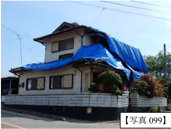
瓦被害，ブロック塀の被害（赤紙判定）
