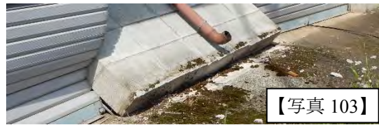
コンクリートブロック造倉庫の壁の転倒（鉄筋は入っていないように見える）
