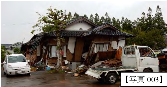
大きな残留変形が残る平屋
