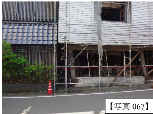
阿蘇神社周辺建物(木造・1層の層崩壊、1層の前面は全面開口)
