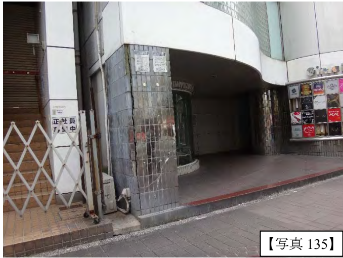
10 層建築物の 1 層柱のコンクリート表面の亀裂
