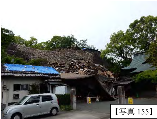
石垣の崩壊と建物の崩落
