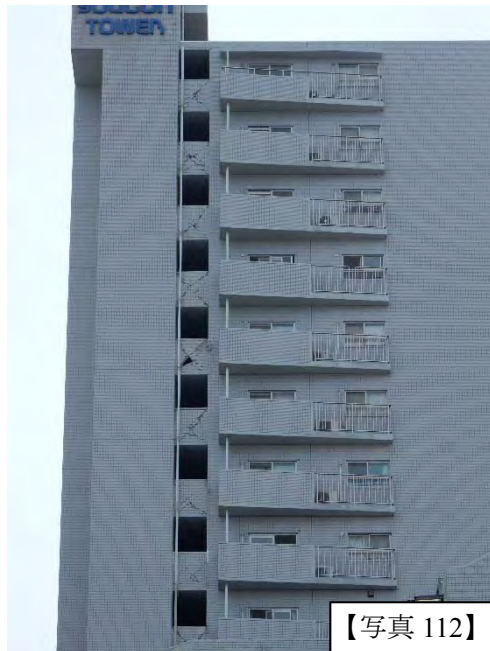
20 層のマンションの共用廊下部分のせん断クラック
