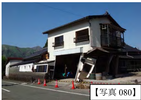
ピロティ部分に大きな変形
