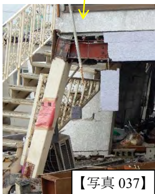
ピロティ階に損傷の集中が見られた鉄骨造建物。
