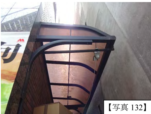
隣の建物とのクリアランス部分。上の底部分ではクリアランスが確保できていないようである（右写真）。底が隣の建物に接触した形跡はない（左下写真）。
