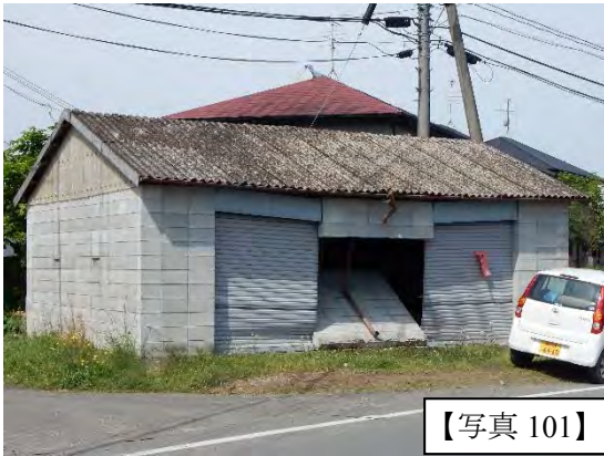
コンクリートブロック造倉庫の壁の転倒（鉄筋は入っていないように見える）
