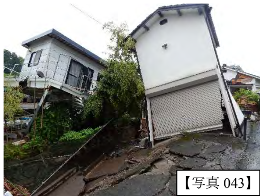
小川周辺の道路や地面が崩落し、上部の建物も崩壊している。
