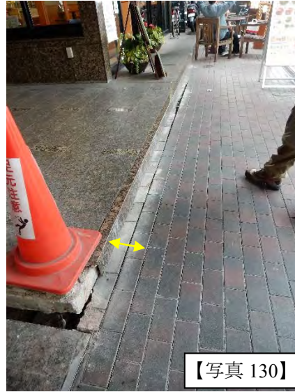
矢印方向に 10cm 程変位した形跡がある
