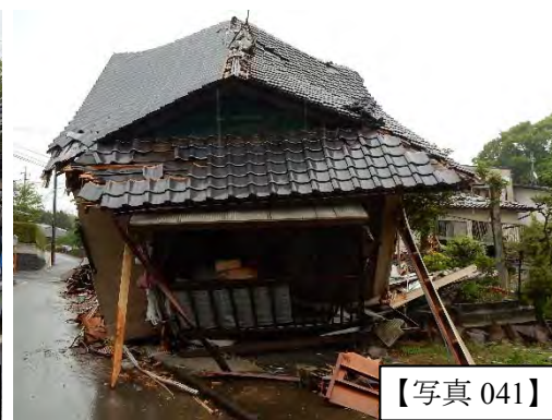
1層が層崩壊した木造住宅（手前）と建物ごと転倒した木造住宅（奥）
