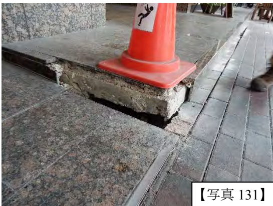
クリアランス部分での損傷
