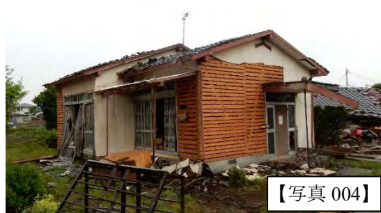
瓦・外壁が崩落した平屋
