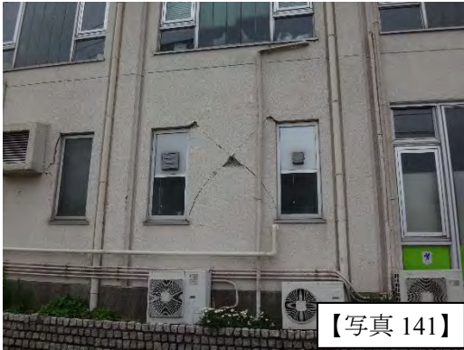
4層 RC 造の1層壁のせん断クラック
