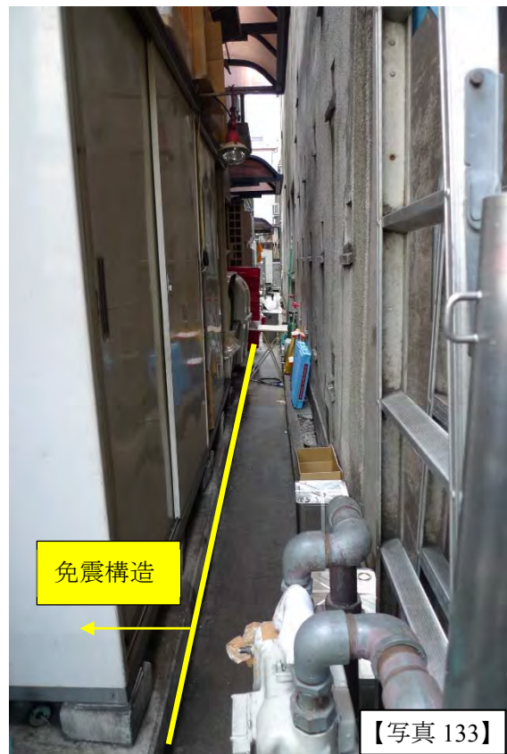
隣の建物とのクリアランス部分。上の底部分ではクリアランスが確保できていないようである（右写真）。底が隣の建物に接触した形跡はない（左下写真）。
