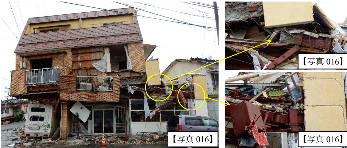
鉄骨 4 階建住宅の 2 層部分の崩壊、柱頭及び柱脚の溶接部の破壊
