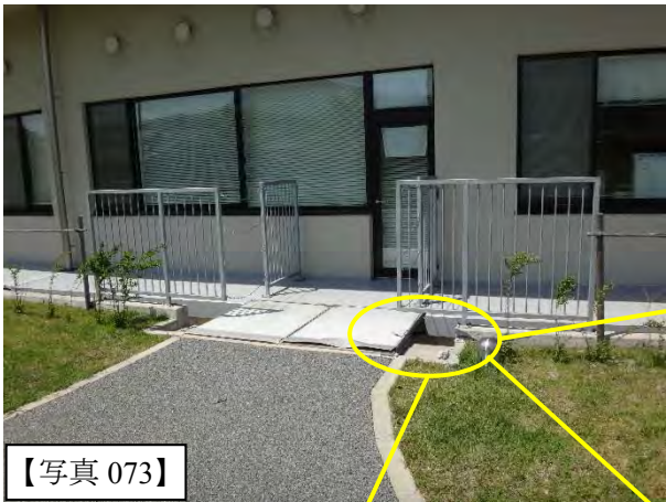
南側エキスパンションジョイントカバーの損傷に比べ北側のカバーでは少ない
