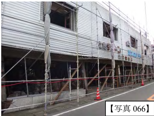
阿蘇神社周辺建物(木造・1層の層崩壊、1層の前面は全面開口)
