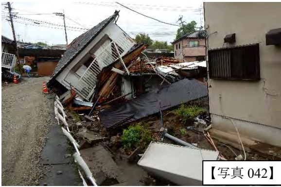
小川周辺の道路や地面が崩落し、上部の建物も崩壊している。
