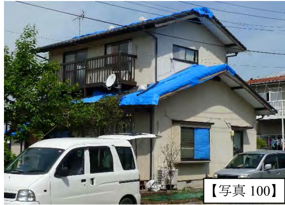
瓦被害，外造材の亀裂
