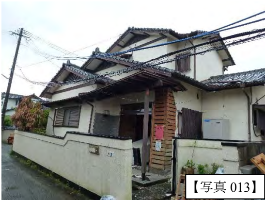
外壁の崩落・応急危険度判定「危険」(赤紙)
