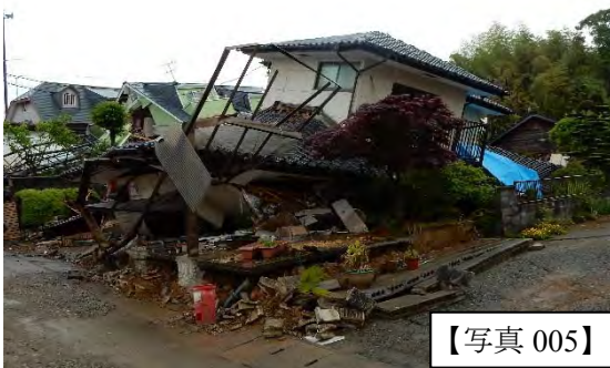
大きな残留変形が残る平屋
