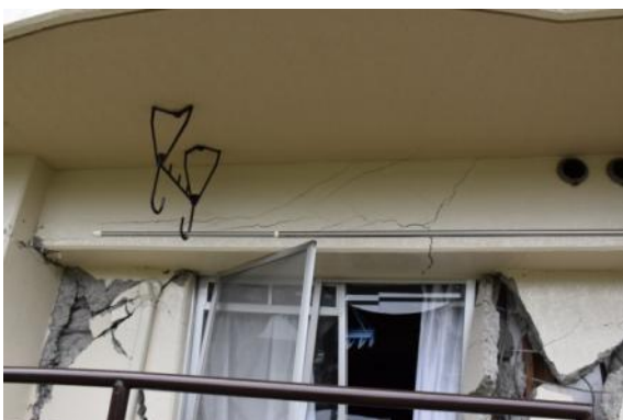
梁の付着割裂ひび割れ。
