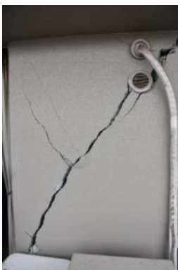
方立壁せん断ひび割れ
