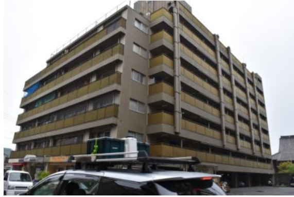
道路向かいに建つ同系列マンション（1973年竣工）
