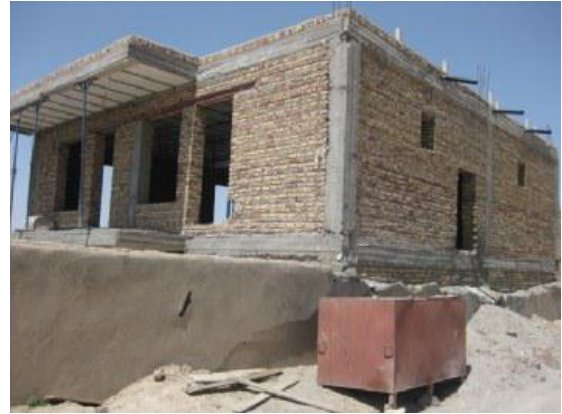
図 15 Mehtarloo 村の構造ディテールを遵守している建設中の住宅
