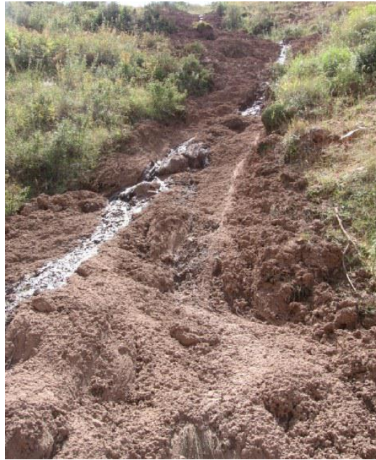
図 12 Bajebaj - Choopanlar 間の道路脇で発生した斜面崩壊
