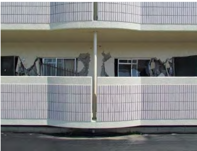
桁行方向西側非構造壁のせん断破壊。入り口ドアの開閉が困難となっている。
