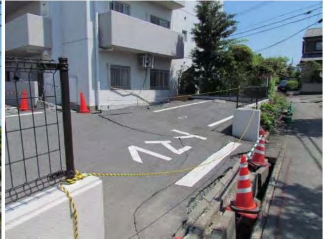
西側地盤沈下 30cm 程度
