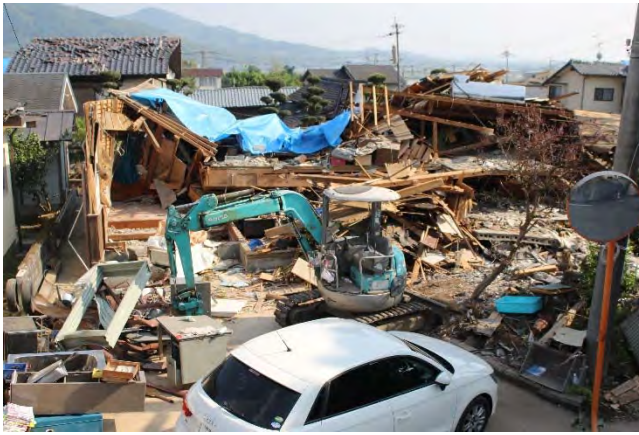
周辺部の地盤変状が悪く、一般木造住宅完全倒壊多数。
