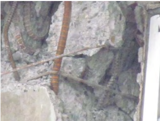
フープは丸鋼，主筋は異形鉄筋
