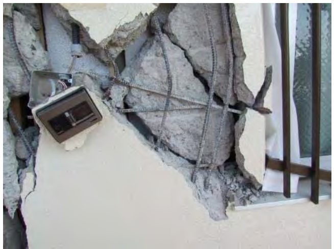
桁行方向東側方立壁のせん断破壊。
