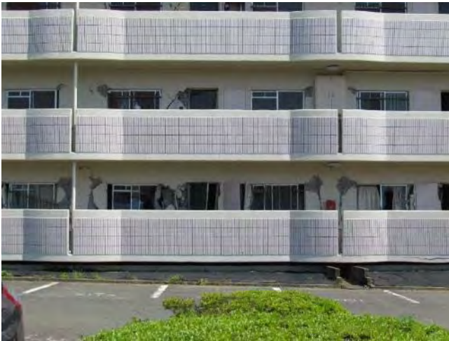
桁行方向西側非構造壁のせん断破壊。入り口ドアの開閉が困難となっている。
