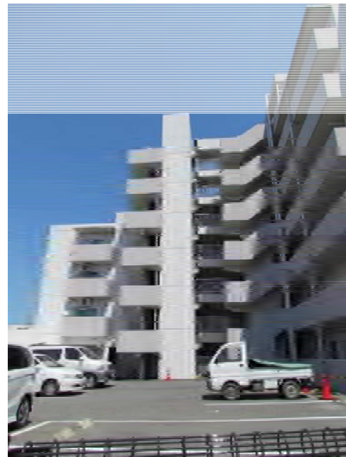
西側地盤沈下 30cm 程度
