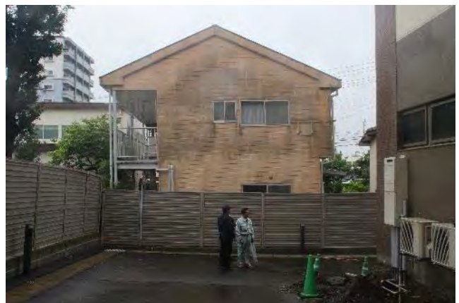
隣の軽量鉄骨造二階建てアパートも傾いていた。
