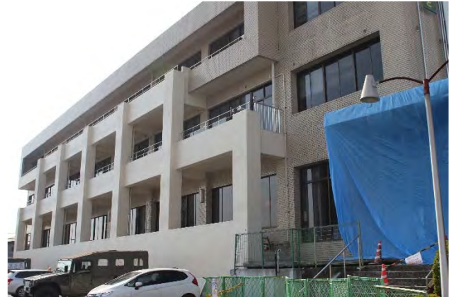
建物の南側に外付け耐震フレーム補強
