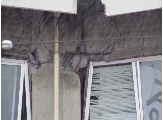
5 階柱柱頭付近
