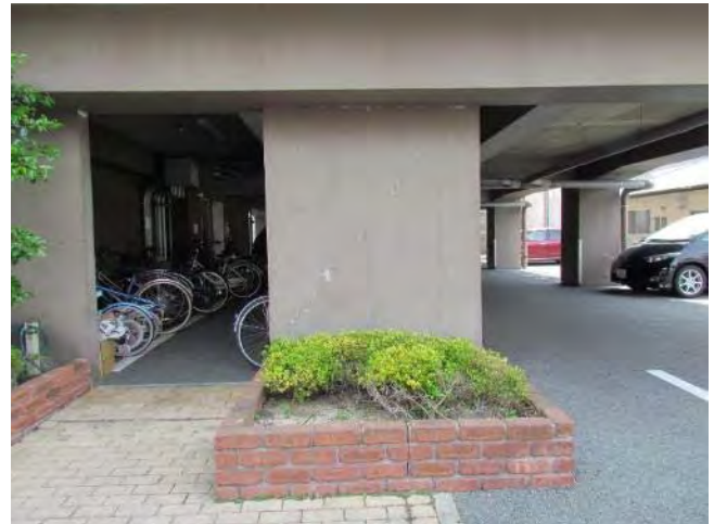
張間方向方立壁せん断ひび割れ (1F は損傷度 III、2階もあつたが見にくい)
