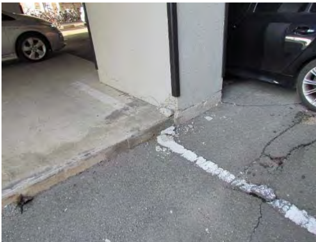
一階駐車場の地盤沈下。10cm～15cm 程度 1F 柱脚の軽微な圧壊。
