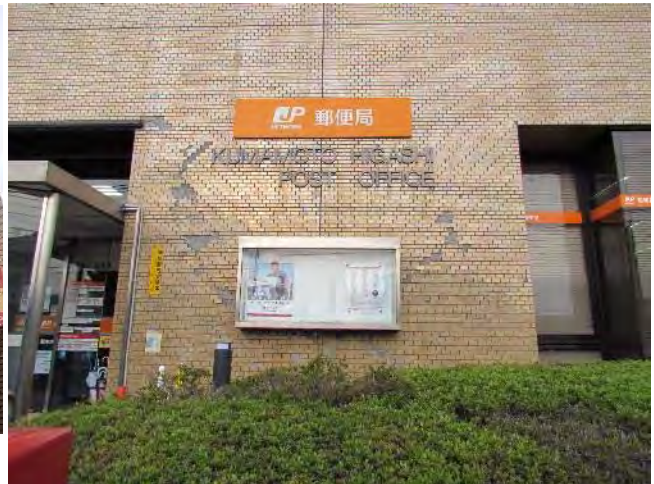
耐震壁(桁行方向、張間方向両方)にせん断ひび割れ(損傷度 I or II)
