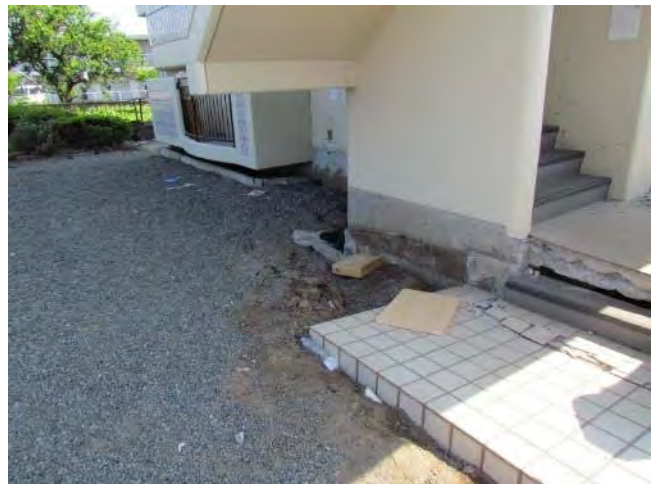
北妻面の周辺沈下 20cm 程度
