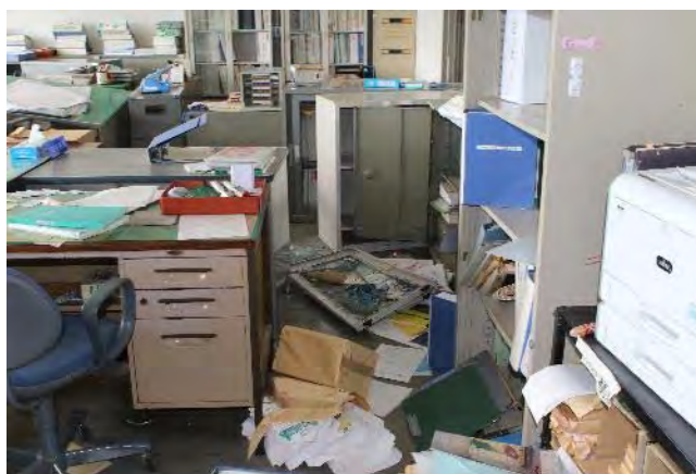
増築した S 造部における家具の転倒
