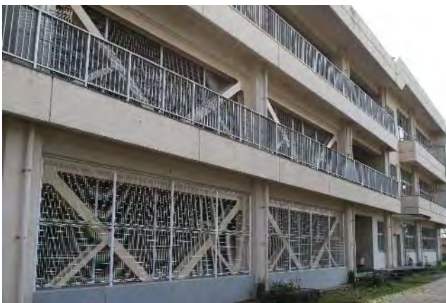
建物全景 ブレース補強
