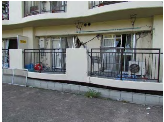
桁行方向東側方立壁のせん断破壊。
