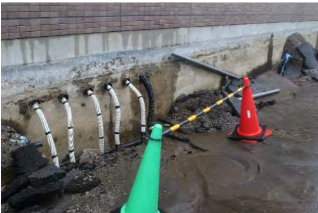
配管の応急修理
