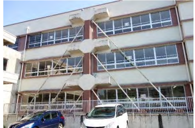
桁行方向を平行工法で補強済み（2セット）
