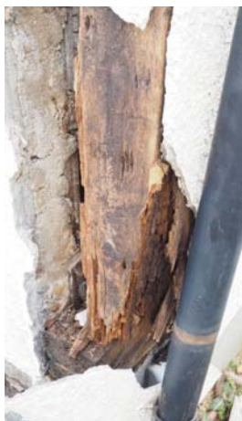
隅柱周辺の腐朽
