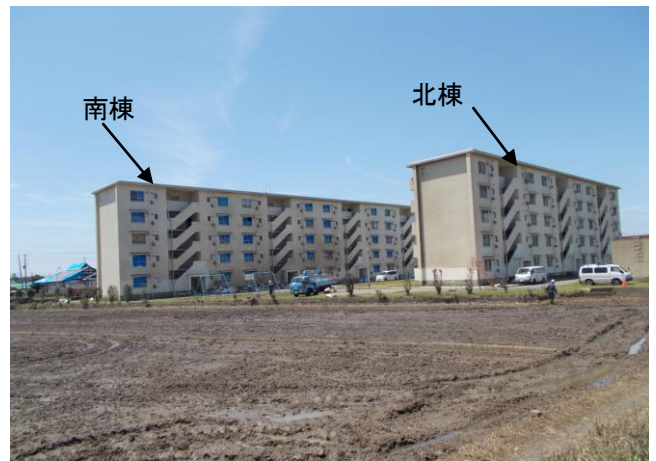
写真16 ⑩ RC造の共同住宅は東西を長手方向に並列し建っている。
