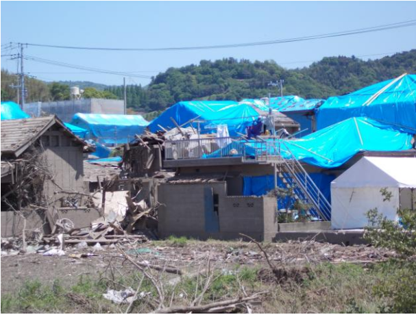
写真7 ③ この周辺では多くの住宅がブルーシートで覆われている
