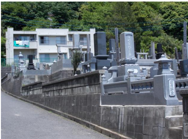
写真27 ⑭ 墓石・ブロック塀 無被害
