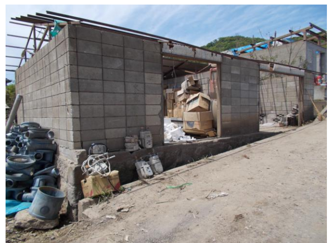
写真24 ⑫ 木造屋根材は吹き飛んだが、ブロック 造部分は無被害
