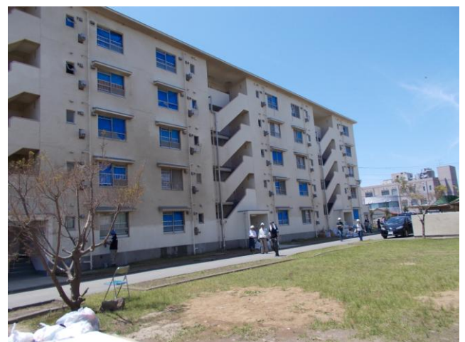
写真18 ⑩ RC造の共同住宅（南棟 北面） 窓ガラスの破損はなく，縦樋も健全である 南棟受風面より被害は小さい
