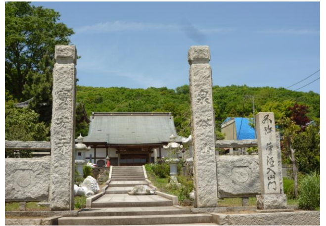
写真26 建屋，石造の門ともに無被害
