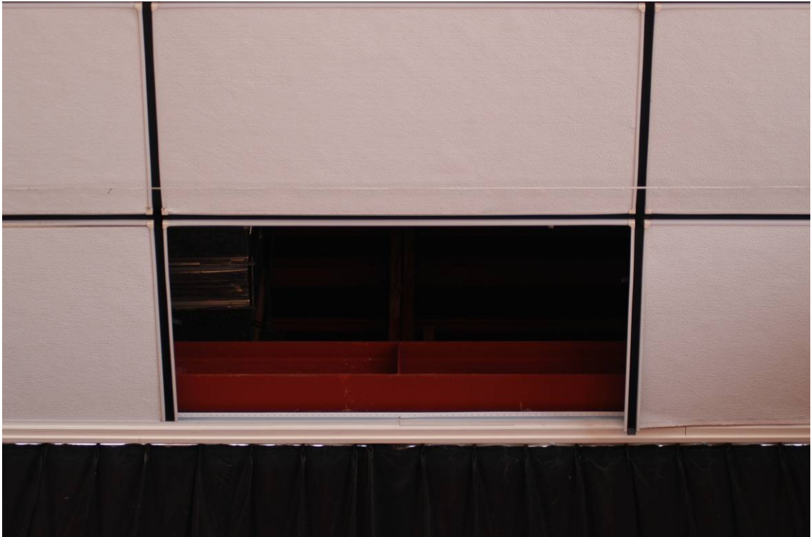
写真 8 妻側部の天井材落下状況
