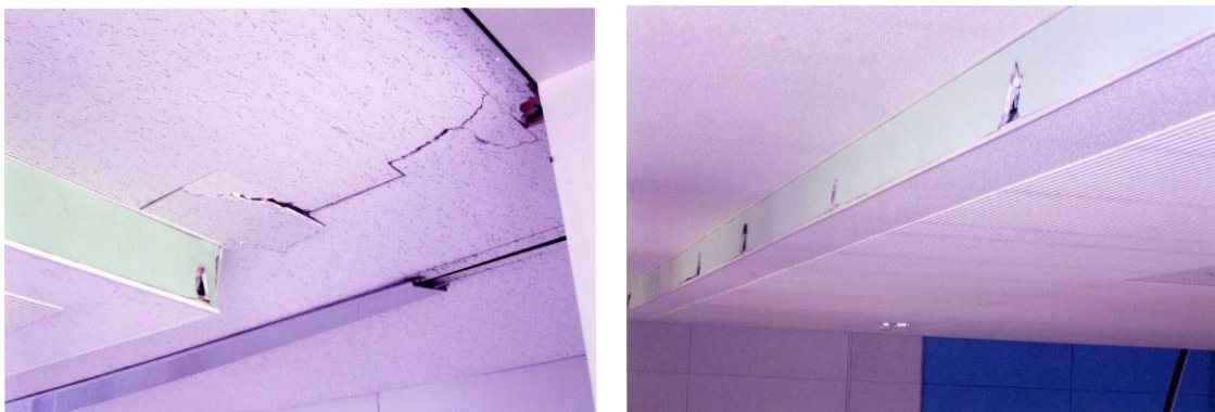
写真 18 食堂の天井材の被害（教頭先生提供）
