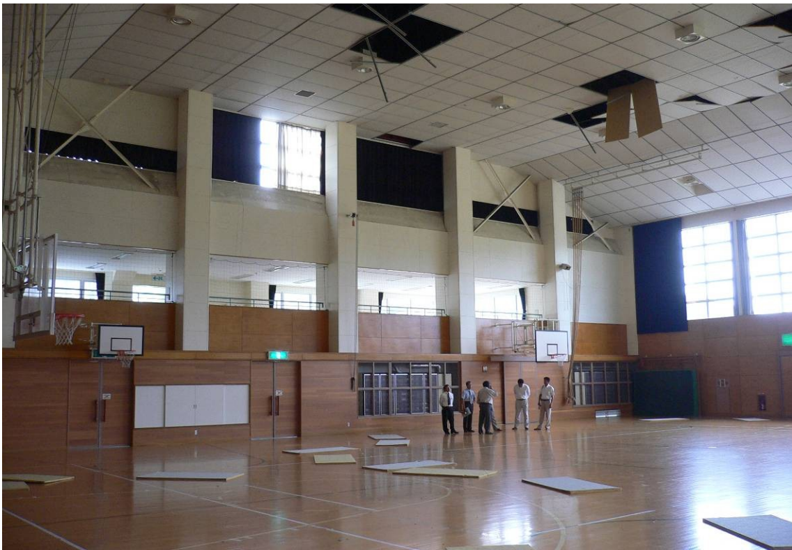
写真 13 落下した天井材の散乱状況
