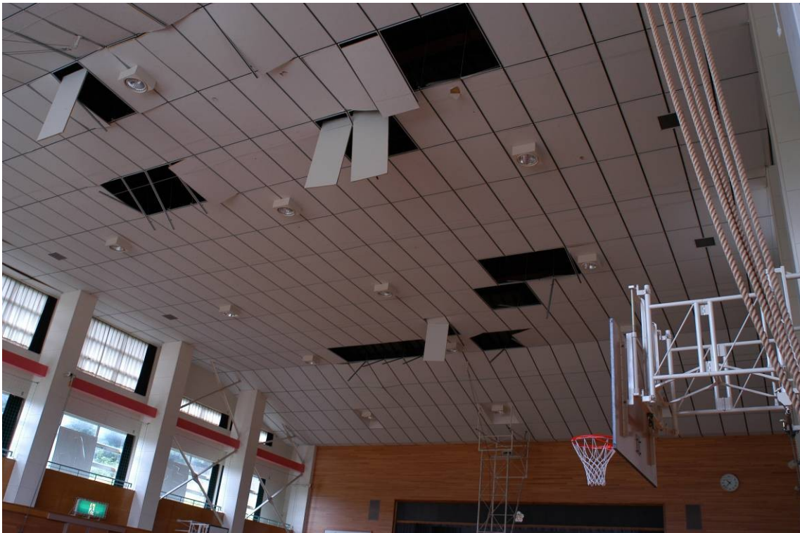
写真2 ステージ側の被害状況
