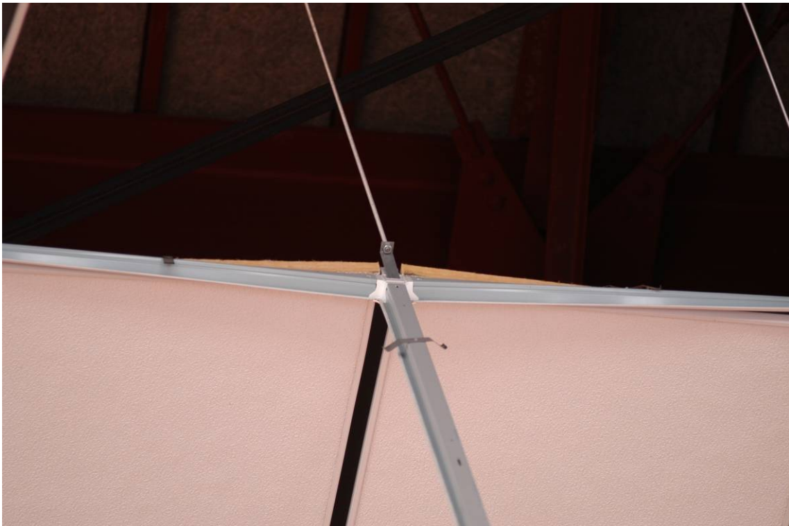
写真 10 吊り材の状況のアップ（スチール枠側）
