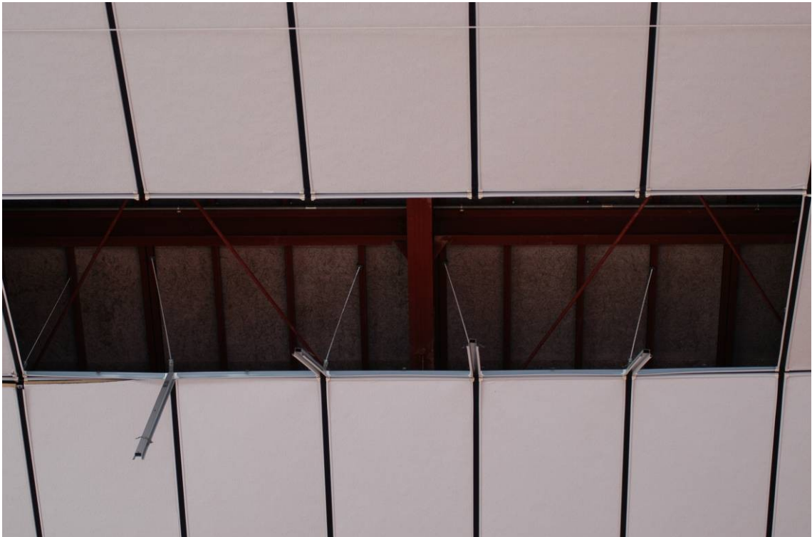
写真 9 吊り材の状況
