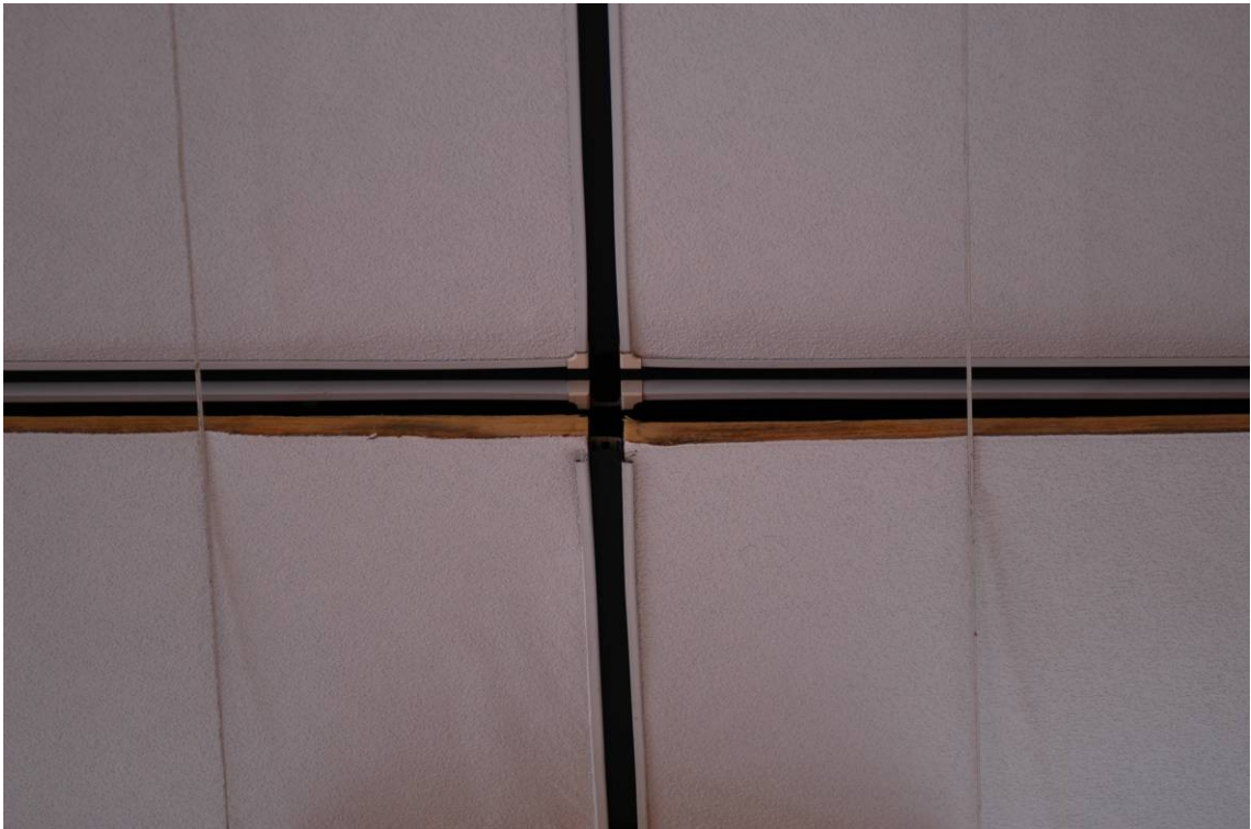
写真7 スチール枠交点のはずれ状況
