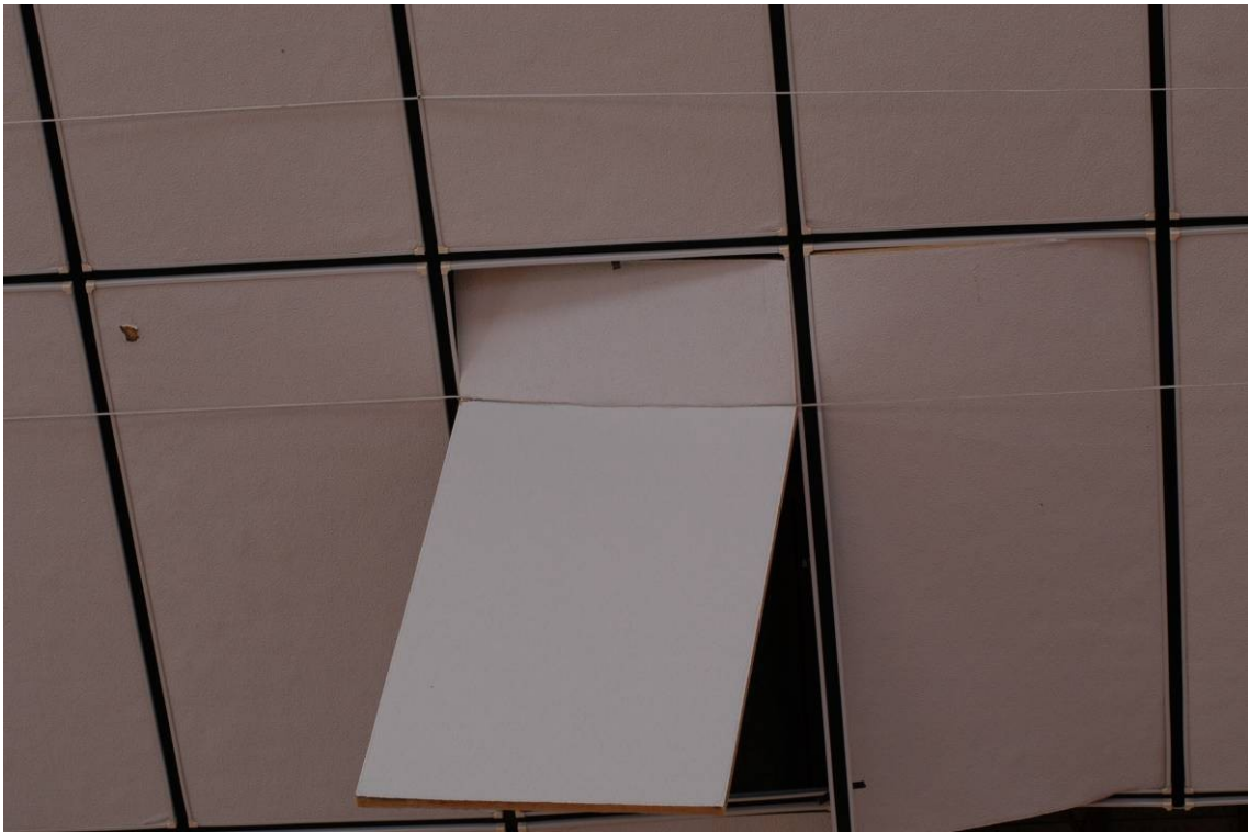
写真 12 消防設備用配管によって落下を免れ、ぶら下がった状態の天井材
