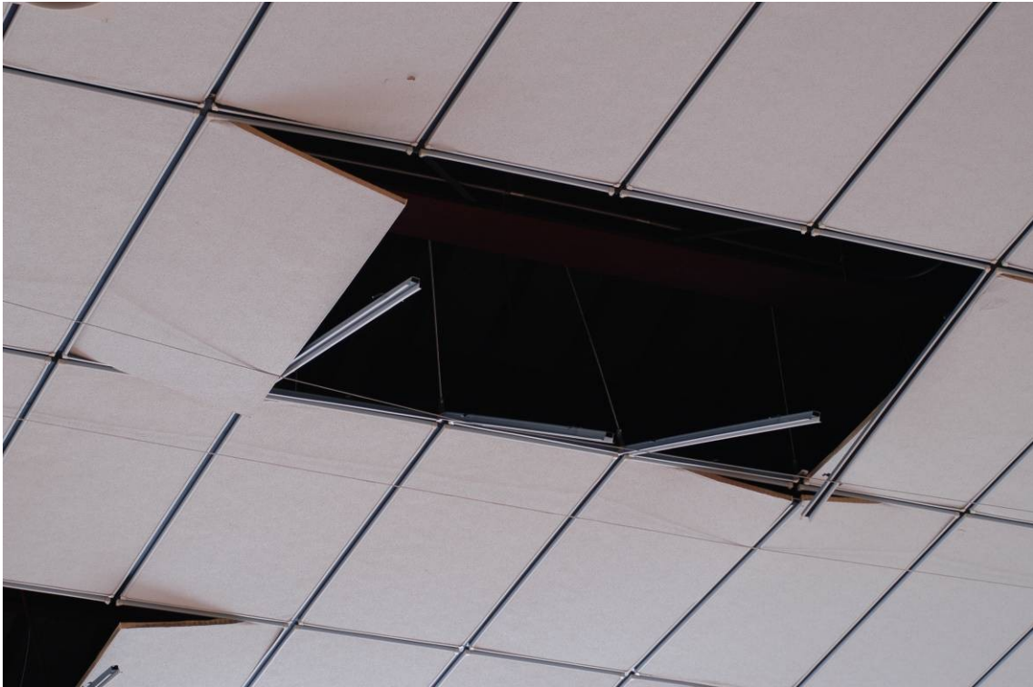
写真4 天井材落下部とその周辺状況
