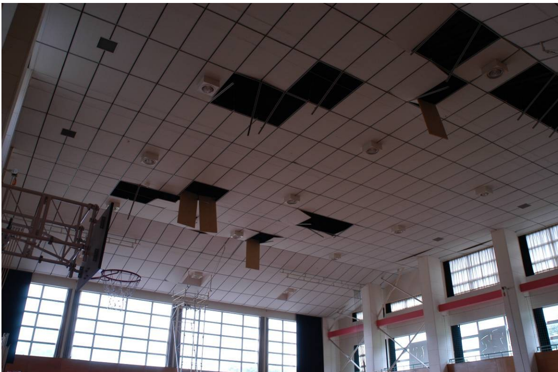
写真3 ステージ反対側の被害状況
