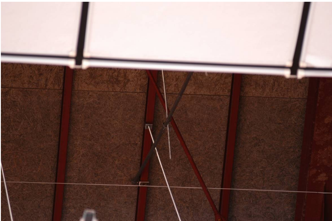
写真 11 吊り材の状況のアップ（母屋側）
