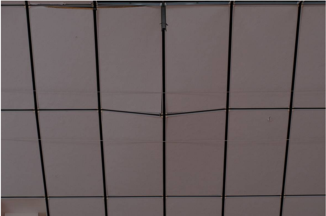
写真6 天井材のはらみだし
