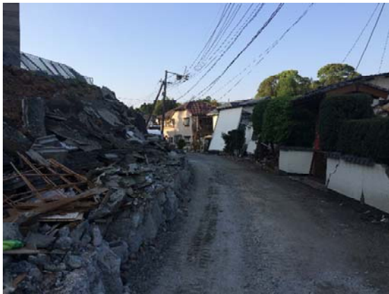
写真7・写真8 地盤変状の表出とそれに隣接する大破・倒壊建物（道は南北方向）
