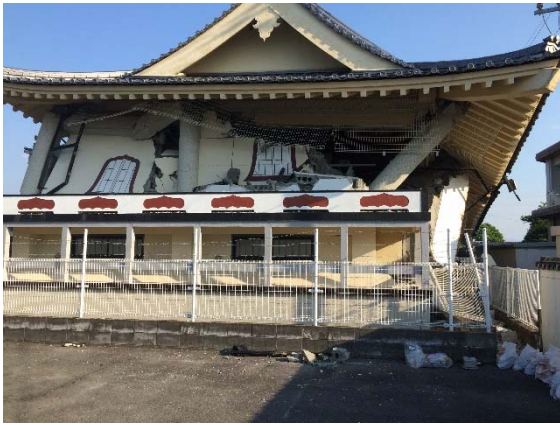
写真5 東西に大破した寺の本堂(RC、新耐震) 写真6 東西方向に転倒した墓石
