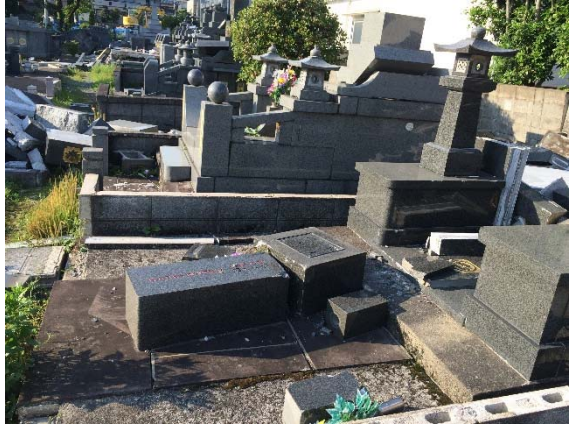
写真5 東西に大破した寺の本堂(RC、新耐震) 写真6 東西方向に転倒した墓石
