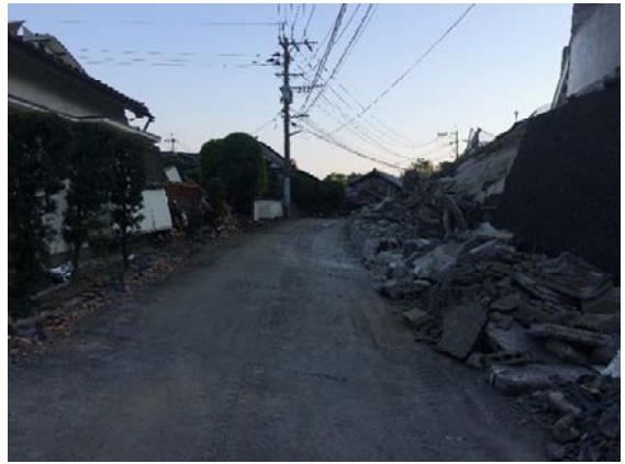
写真7・写真8 地盤変状の表出とそれに隣接する大破・倒壊建物（道は南北方向）
